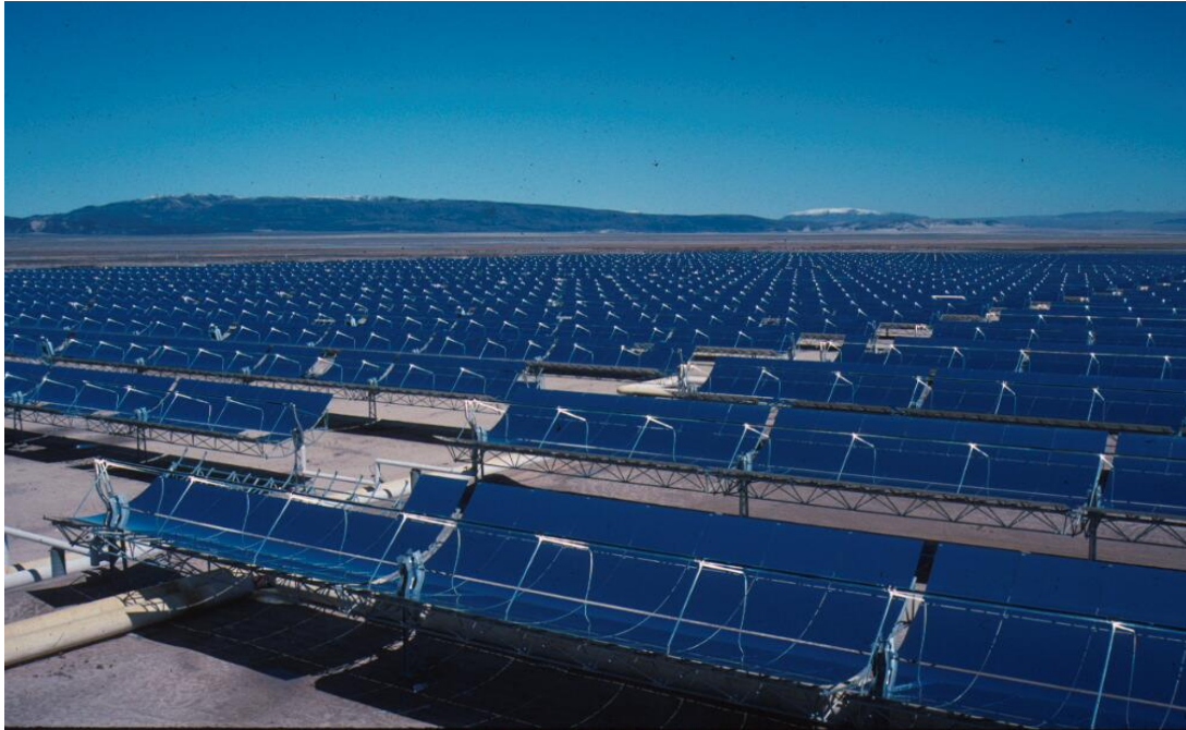
Εικόνα 2.8.3: Μέρος από τον σταθμό παραγωγής ενέργειας SEGS με συλλέκτες PTC, Καλιφόρνια [2.20].
