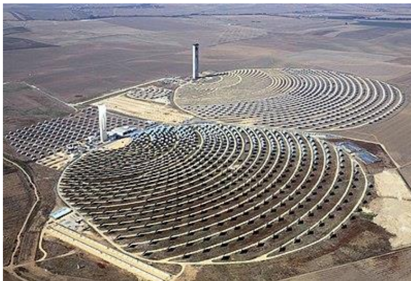
Σχήμα 2.8.9: Οι σταθμοί με ηλιακό πύργο PS10 και PS20 στην Ισπανία [2.28].
