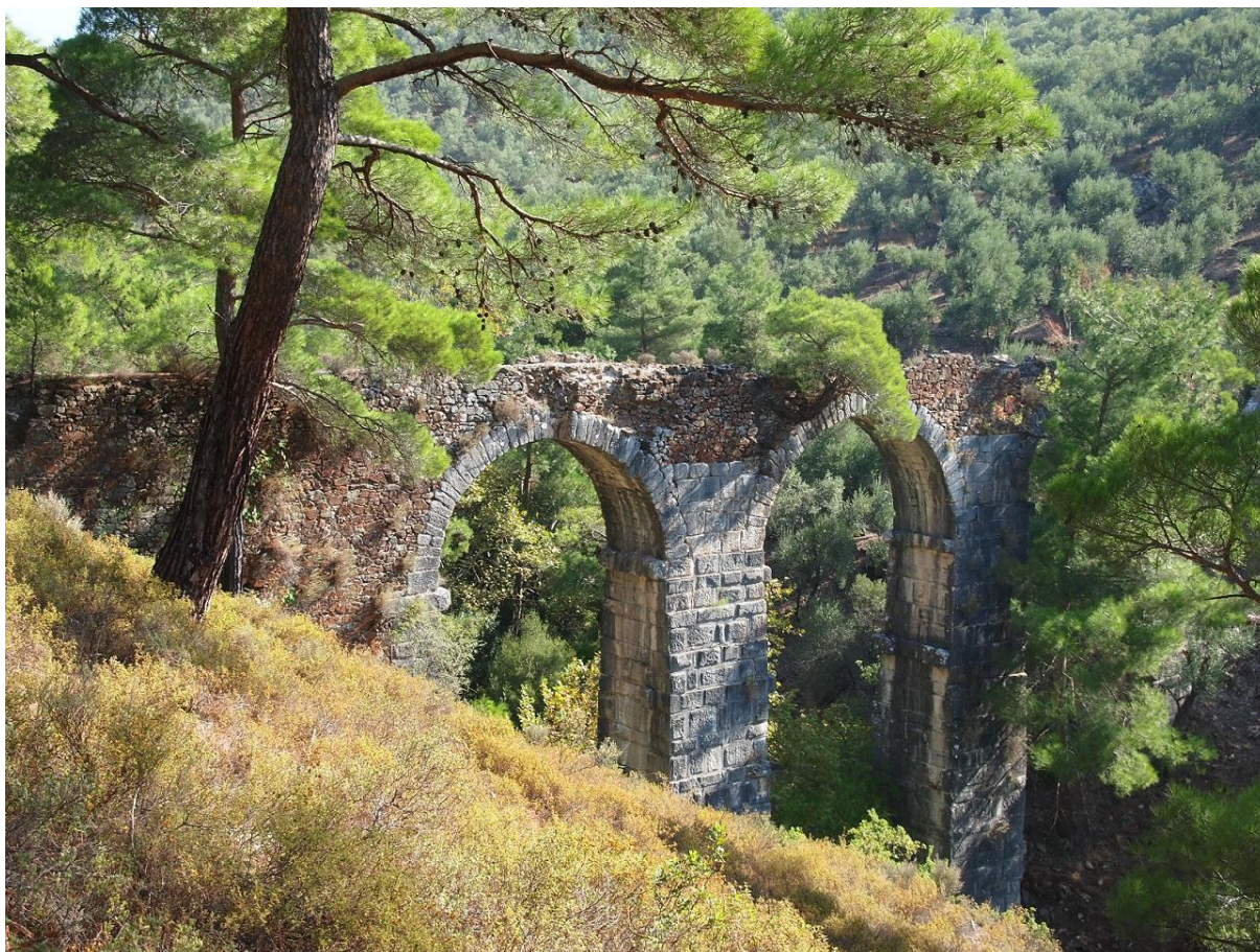
Εικ.80, Ρωμαϊκό υδραγωγείο Μυτιλήνης στη θέση Πασπαλά στους Λάμπου Μύλους
