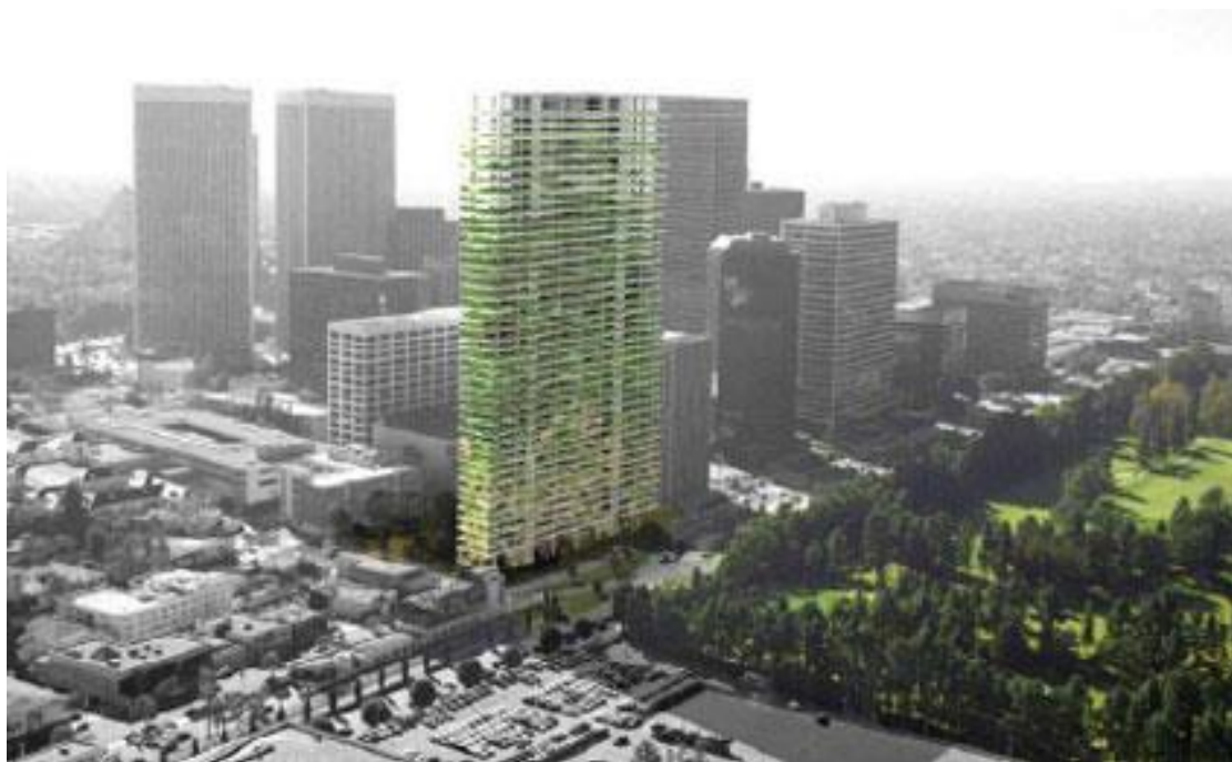
Εικ.77: Πρόταση του Jean Nouvel για τη δημιουργία πράσινου ουρανοξύστη στο Λος Άντζελες. Ο ίδιος ονόμασε το έργο 'Green blade' και λειτουργεί σαν χαρακτηριστικό παράδειγμα κάθετου κήπου αφού η δομή του ουρανοξύστη και τα στοιχεία φυτεύσεων συντίθεται συνολικά.
