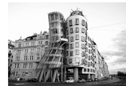
Εικόνα. 71. Dancing house στην Πράγα, F. Gehry. [Αντίστιξη παλαιού-νέου]
