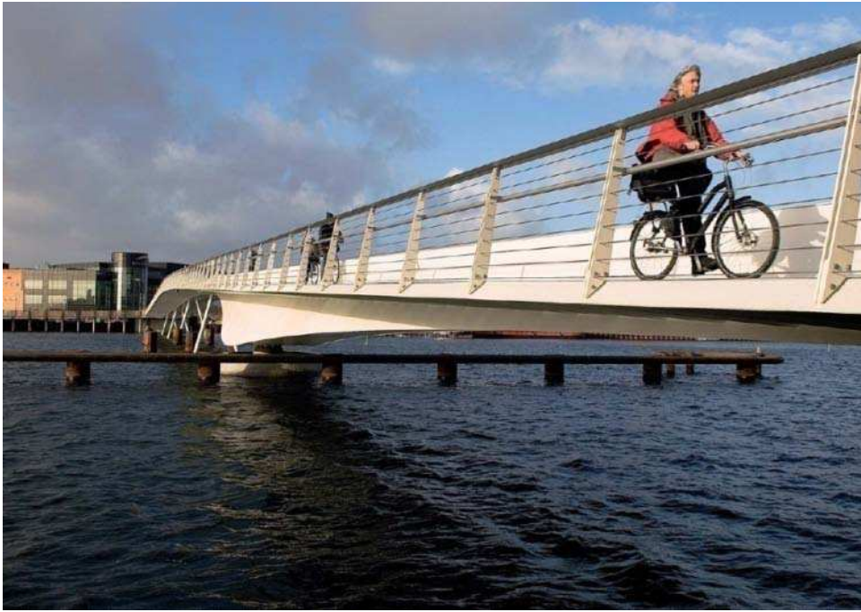
Εικόνα 11, Η γέφυρα Bryggebroen, Κοπεγχάγη
