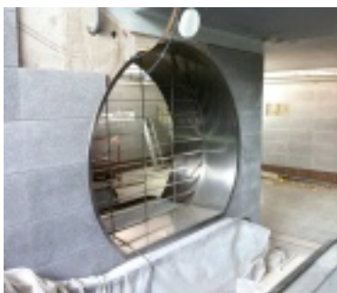
Εικόνα 14: Κατασκευή των εσόδων/εξόδων του Σταθμού (πηγή: ΑΤΤΙΚΟ ΜΕΤΡΟ Α.Ε)
