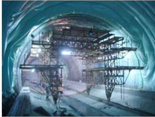
Εικόνα 13: Κατασκευή του Μετρό στο Χαϊδάρι (πηγή : ΑΤΤΙΚΟ ΜΕΤΡΟ Α.Ε)
