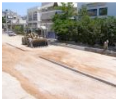
Εικόνα 15: Αποκατάσταση των οδών Αγ. Μαρίνας (πηγή: ΑΤΤΙΚΟ ΜΕΤΡΟ Α.Ε)
