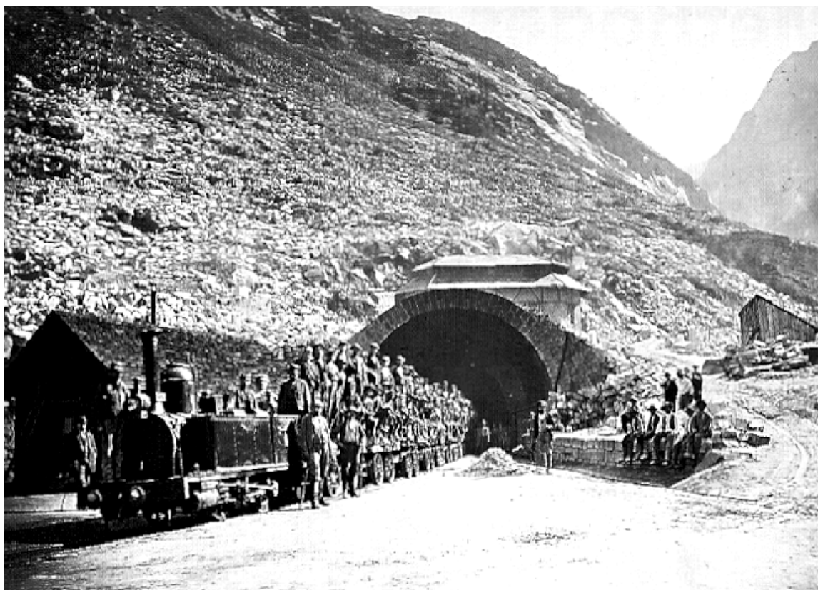
Εικόνα 3: Σήραγγα Saint Gothard στην Ελβετία στα τέλη 19 ου αιώνα (πηγή: Καλιαμπάκος 2009)
