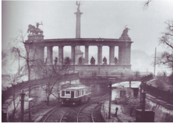
Εικόνα 10: Υπόγειος σιδηρόδρομος Millenium παλαιά φάση στην Πλατεία Ηρώων στη Βουδαπέστη
