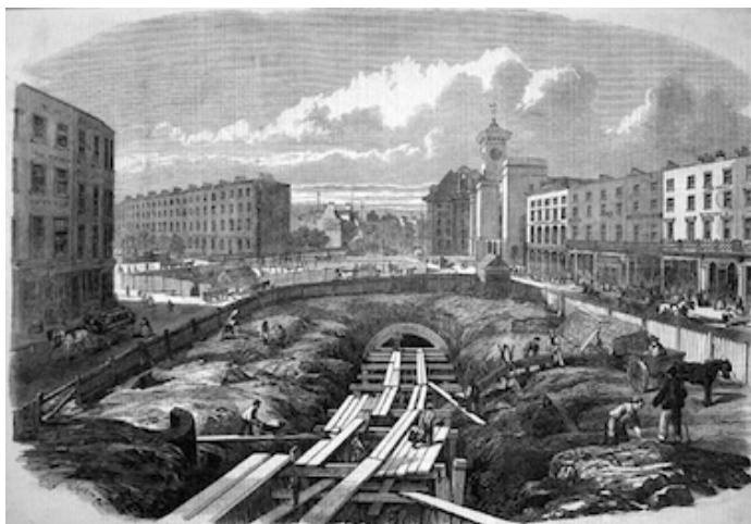
Εικόνα 9: Κατασκευή του υπόγειου σταθμού του Μετρό στο Λονδίνο το 1861 (Πηγή: el.wikipedia.org/wiki/Λονδίνο )
