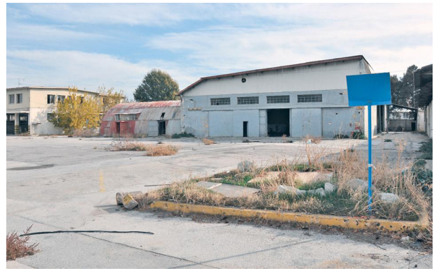
Εικόνα 38: Το κτίριο πριν την διαμόρφωσή του σε Τέμενος.
