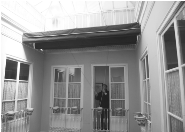
Απόψεις του στεγασμένου αίθριου από τον ισόγειο χώρο και τον πρώτο όροφο κατά την διάρκεια τοποθέτησης και λειτουργίας της τέντας
