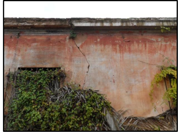
Εικ. 4.2.5: Διακρίνεται η ρωγή ΒΟ3 λόγω εκτός επιπέδου κάμψης της τοιχοποιίας.
