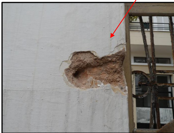
Εικ. 4.9.6: Αφαίρεση επιχρίσματος για έλεγχο τυχόν ύπαρξης ξυλοδεσιάς.
