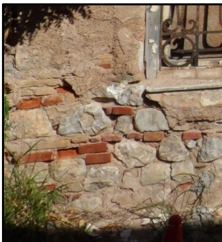
Εικ. 1.9: Χρήση εξισωτικών στρώσεων οπτοπλίνθων. Εικ. 1.10: Γωνιόλιθοι.
