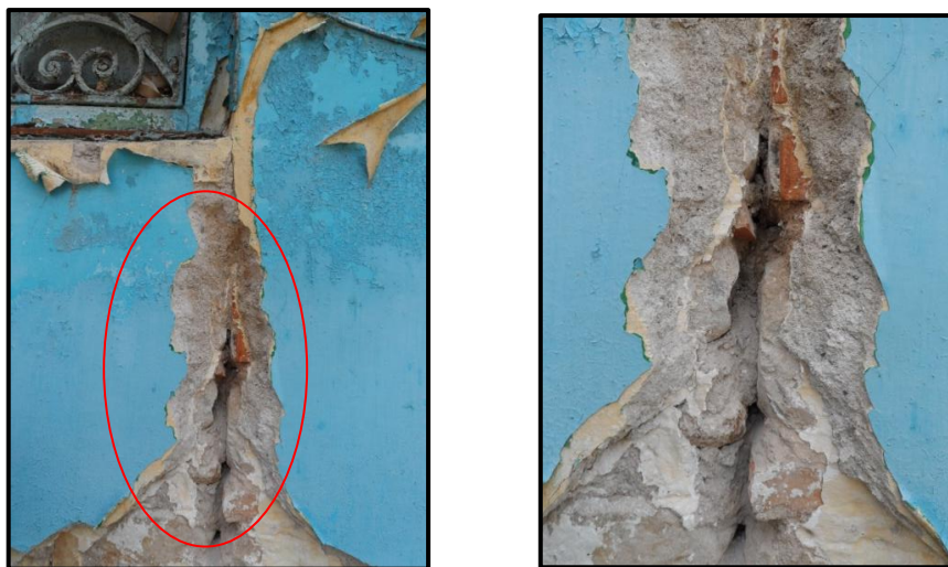
Εικ. 2.12: Μη αλληλεμπλοκή λίθων στο άνοιγμα αριστερά.
