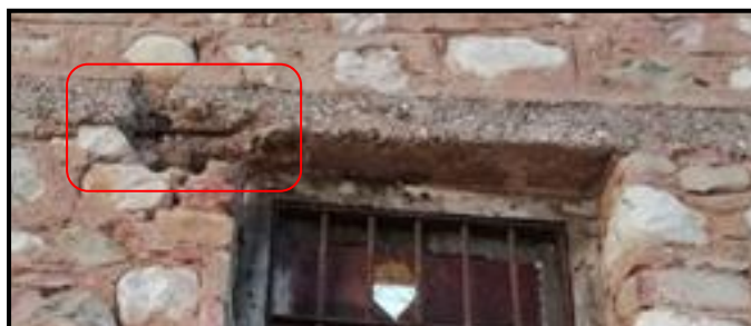
Εικ. 9.4.2.10: Διακρίνεται λεία οριζόντια ράβδος.
