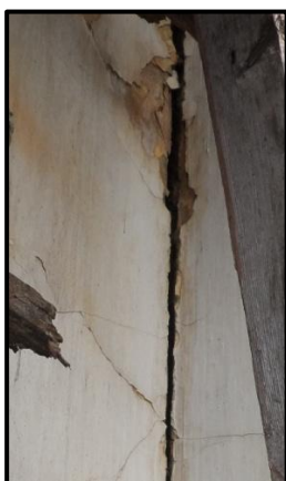
Εικ. 4.8.6: Κατακόρυφη ρωγή στη σύνδεση βόρειου & ανατολικού τοίχου εσωτερικά.
