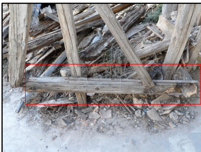
Εικ. 3.8: Σύνδεση ορθοστάτη με τον ελκυστήρα
