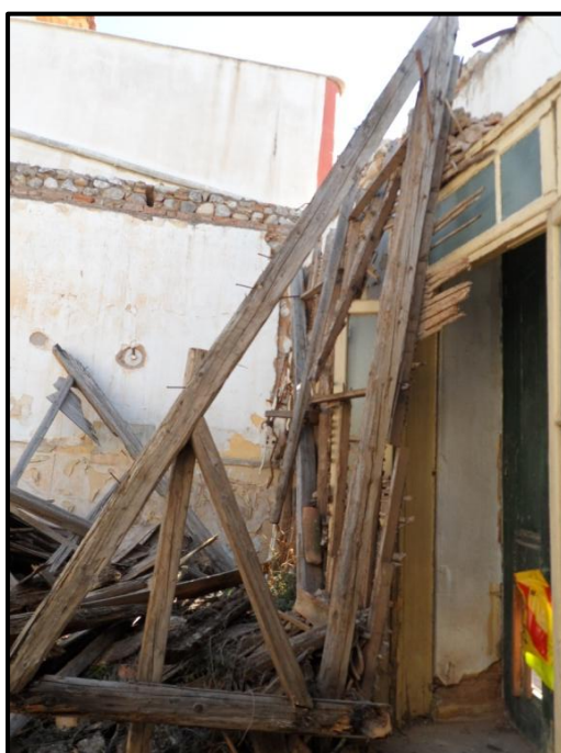
Εικ. 3.9: Το μοναδικό ημίζευκτο που έχει σωθεί και η αποτύπωσή του.
