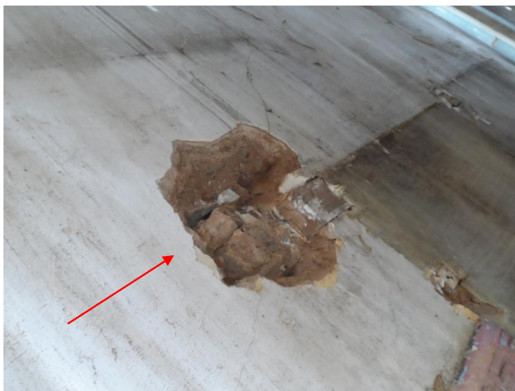
Εικ. 4.7.2: Αφαίρεση επιχρίσματος σε ύψος περίπου 1.85m για να γίνει έλεγχος αν υπάρχει ξυλοδεσιά στην τοιχοποιία.
