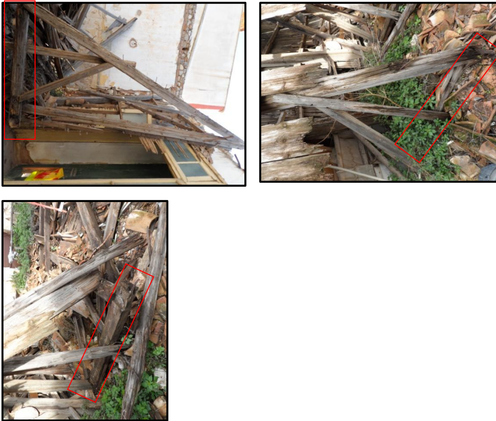
Εικ. 3.6: Βρέθηκαν τρεις ορθοστάτες επομένως τεκμηριώνεται η ύπαρξη τριών κύριων ζευκτών.
