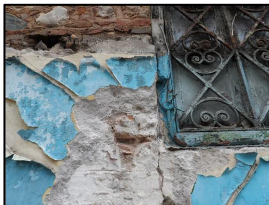
Εικ. 4.8.5: Αφαίρεση επιχρίσματος στην εξωτερική ανατολική όψη για τυχόν ύπαρξη ξυλοδεσιάς.
