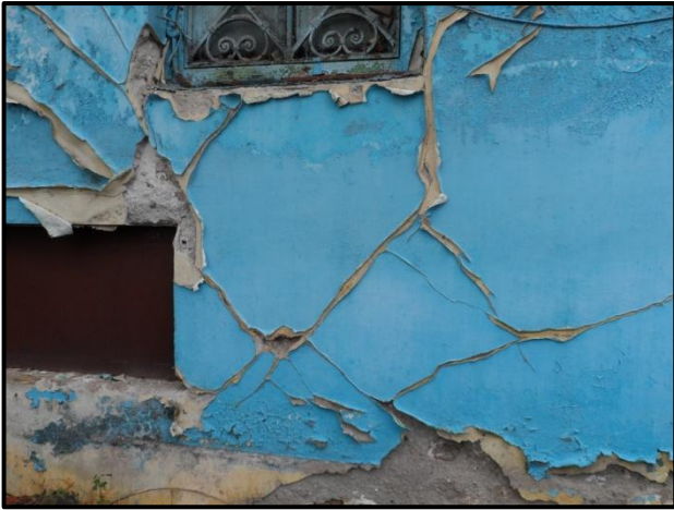
Εικ. 4.5.4: Πριν την αφαίρεση του επιχρίσματος
