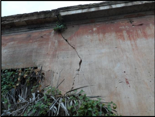
Εικ. 4.2.5: Διακρίνεται η ρωγή ΒΟ3 λόγω εκτός επιπέδου κάμψης της τοιχοποιίας.
