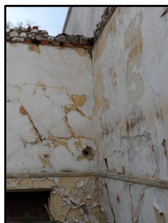
Εικ. 4.8.7: Σύνδεση ανατολικού & νότιου τοίχου εσωτερικά.
