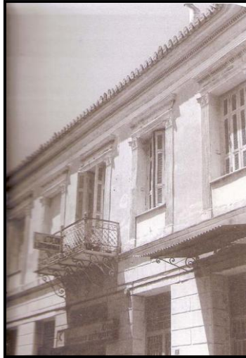
Εικ. 1.16: Παρατηρούνται σιδεριές στα καταστήματα του ισογείου στο Αρχοντικό του Βούλγαρη.
