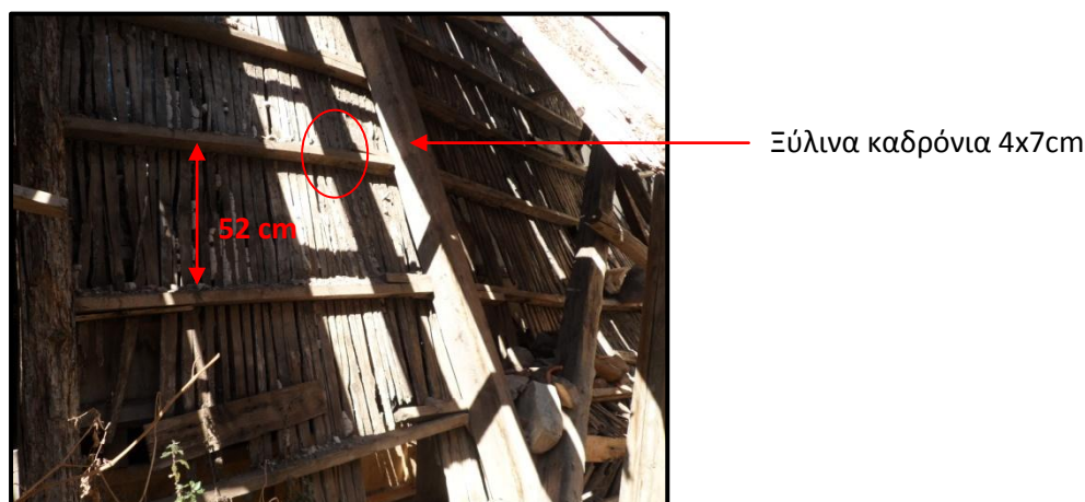
Εικ. 2.16: Διακρίνονται τα κατασκευαστικά χαρακτηριστικά της οροφής της στέγης.
