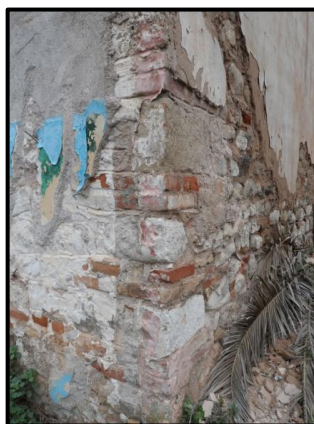
Εικ. 4.8.8: Σύνδεση βόρειου και ανατολικού τοίχου εξωτερικά.
