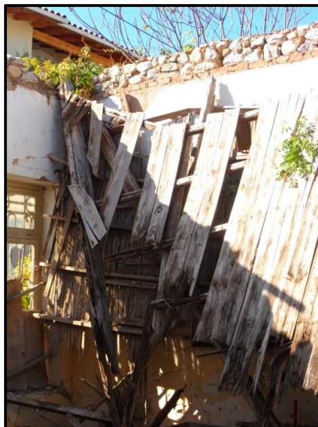
Εικ. 3.10: Διακρίνονται οι τεγίδες και το σανίδωμα της στέγης.
