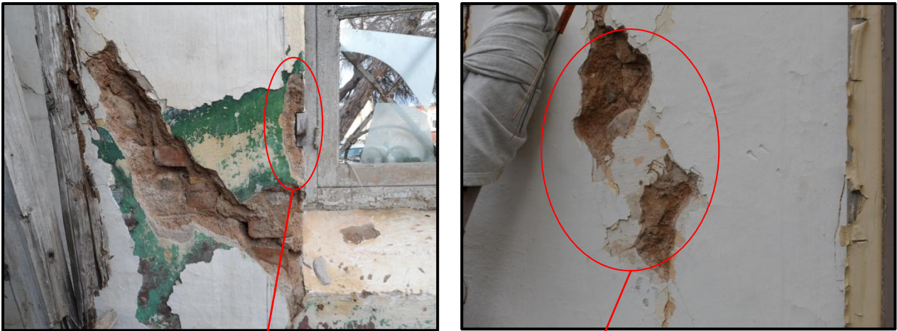
Εικ. 4.8.4: Αφαίρεση του επιχρίσματος σε ακόμη δύο σημεία της εσωτερικής όψης για τυχόν ύπαρξη ξυλοδεσιάς.
