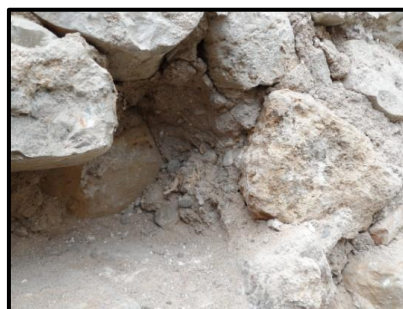
Εικ. 5.3: Η τοιχοποιία κατά το πάχος της μετά την αφαίρεση λιθοσώματος από την εσωτερική παρεία.
