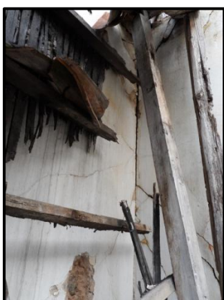
Εικ. 4.8.6: Κατακόρυφη ρωγή στη σύνδεση βόρειου & ανατολικού τοίχου εσωτερικά.
