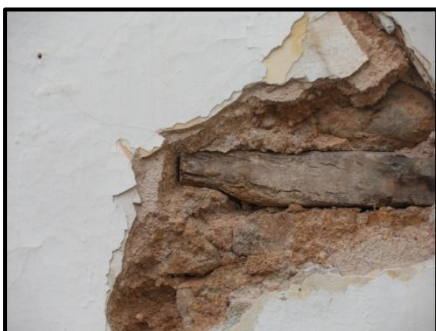
Εικ. 4.8.2: αριστερά: πριν την αφαίρεση του επιχρίσματος, δεξιά: αφαίρεση του επιχρίσματος αρχικά σε ύψος 1.85m και στη συνέχεια λίγο πιο ψηλά όπου και βρέθηκε η ξυλοδεσιά.
