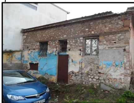
Εικ. 2.23: Ανατολική όψη κτηρίου
