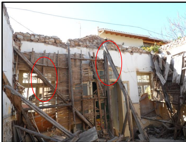
Εικ. 3.11: Διακρίνονται τα ημίζευκτα της στέγης.
