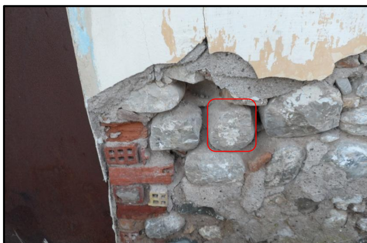
Φωτ. Α.3: Σημείο λήψης λιθοσώματος Ι. Στη στέγη της δυτικής όψης.
