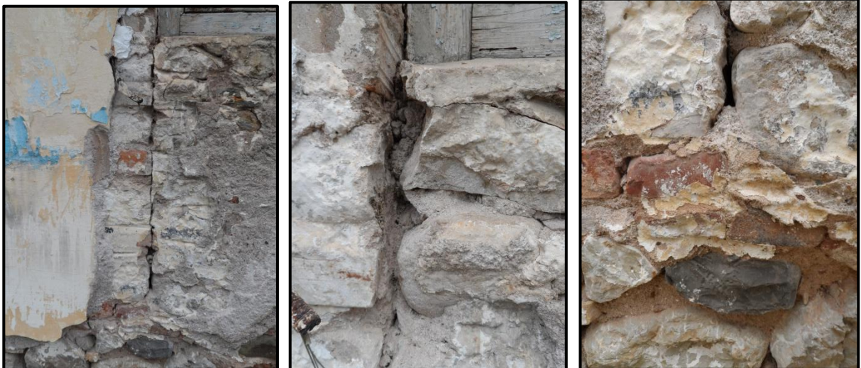
Εικ. 2.11: Από το κατώφλι του παραθύρου δεξιά και έως 80εκ. δεν παρατηρείται αλληλεμπλοκή των λίθων εξαιτίας της μείωσης του ύψους των παραθύρων.
