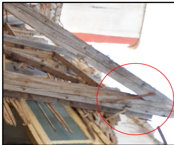
Εικ. 3.7: Σύνδεση αμείβοντα με τον ελκυστήρα.
