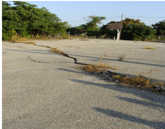
Φωτογραφία 4.4 Ενδείξεις ρηγματώσεων στην περιοχή
