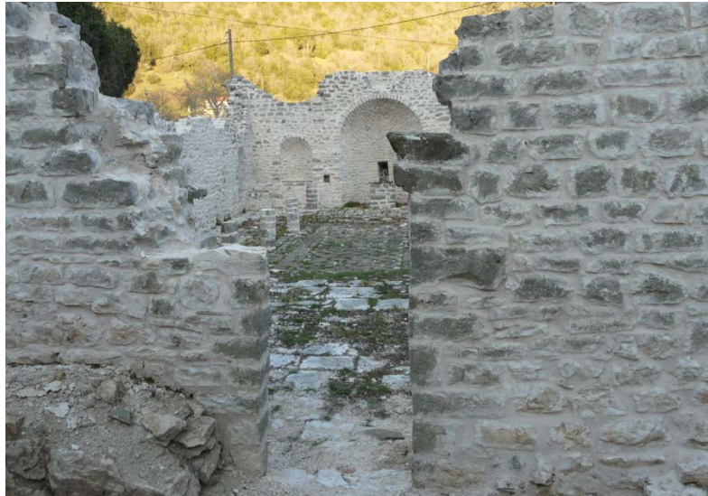
Εικ. 15 Άνοιγμα δυτική όψη
