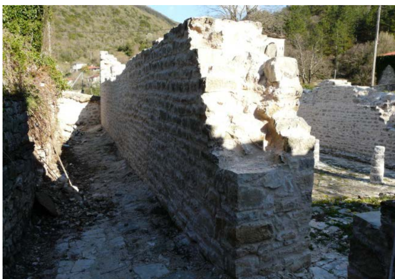
Εικ. 10 Βόρεια όψη
