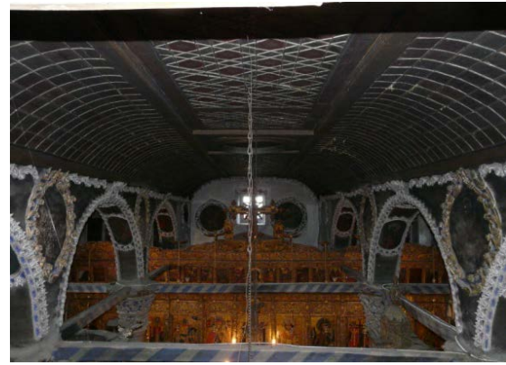
Εικ. 22 Οροφή Ι.Ν. Αγ. Μηνά στο Δίκορφο
