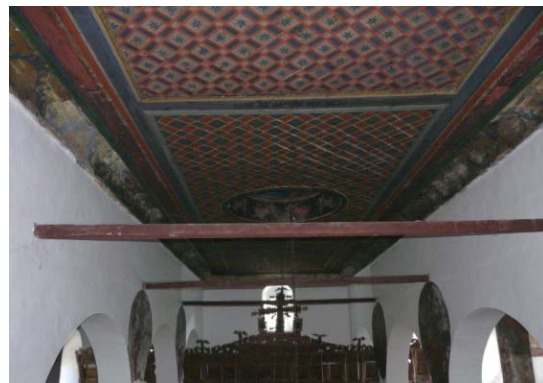
Εικ. 21 Οροφή Ι.Ν. Αγ. Νικολάου στον Ελαφότοπο
