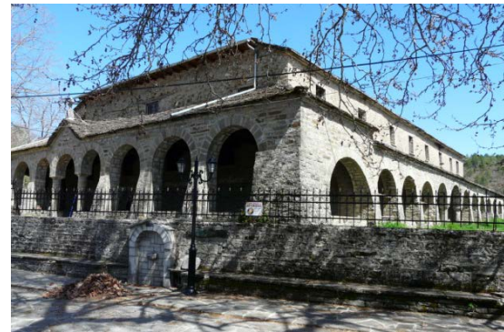
Εικ. 6 Ι.Ν. Αγ. Γεωργίου στις Νεγάδες φορές σε μεταγενέστερο χρόνο από τον κυρίως ναό όπως συμβαίνει και στον ναό του Αγ. Μηνά στο Μονοδένδρι 19 . Οι στοές είναι χαρακτηριστικό στοιχείο των ναών όλης της Ηπείρου λόγω κυρίως των δυσμενών κλιματολογικών συνθηκών. Κάλυπταν τόσο θρησκευτικές ανάγκες (προετοιμασία των πιστών, μοίρασμα σταριού στα μνημόσυνα) όσο και κοσμικές καθώς αποτελούσε χώρο συνάθροισης των ανδρών για τις κοινοτικές συνελεύσεις και παλαιότερα των δημογερόντων αλλά και χώρο κοινωνικών εκδηλώσεων 20 . Χαρακτηριστικά
