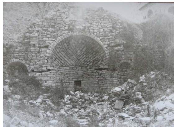
Εικ. 17 Δάπεδο του ναού κατά τη διάρκεια εργασιών Εικ. 18 Όψη του ιερού κατά τη διάρκεια εργασιών τη δεκαετία '80
