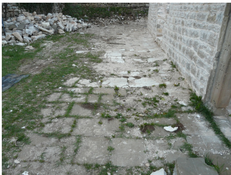
Εικ. 15 Εξωτερικό δάπεδο
