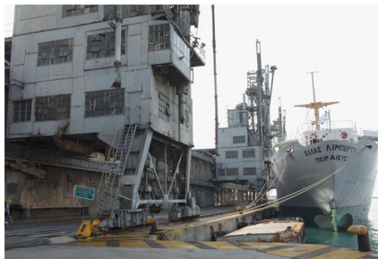
8. Ταινιόδρομος, δώροφος διάδρομος μεταφοράς σιτηρών
