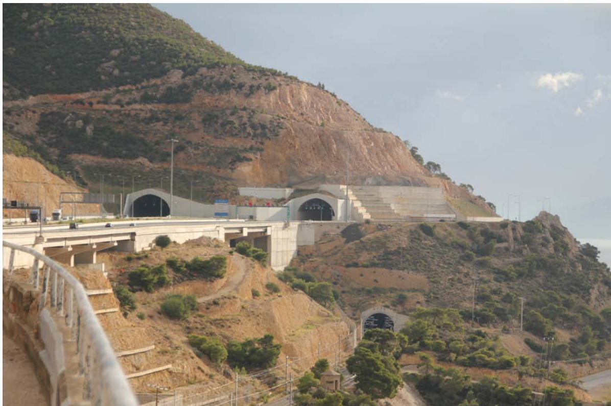
Εικόνα_3.9: Δίδυμη σήραγγα ΑΣ1
