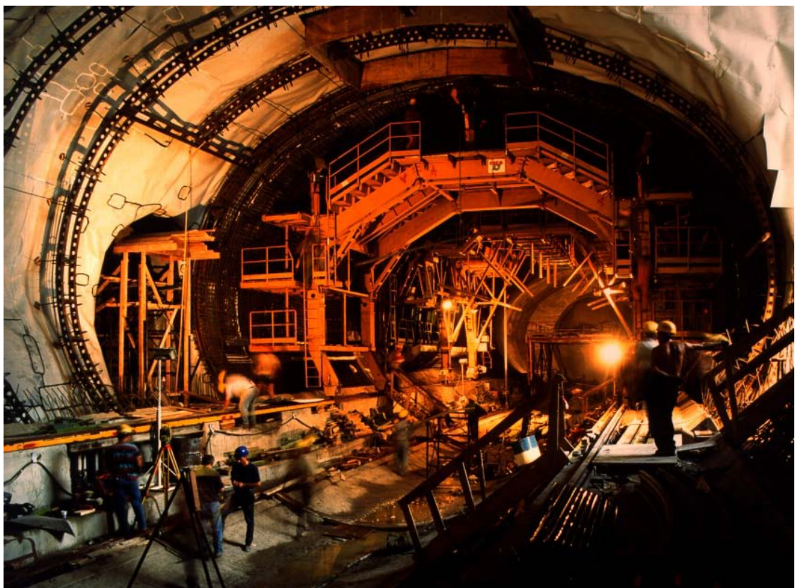
Εικόνα_2.5: Τοποθέτηση μεταλλότυπου για την κατασκευή της τελικής επένδυσης σε σήραγγα του μετρό της Αθήνας ( http://www.ametro.gr/page/default.asp?la=2&Id=61 )
