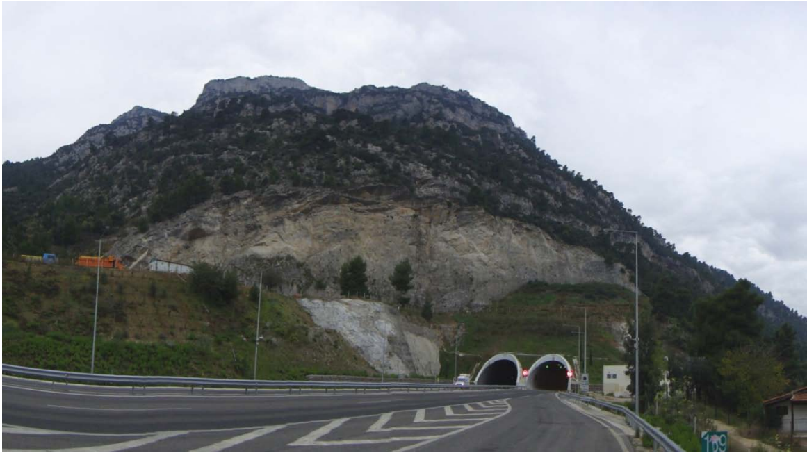
Εικόνα_3.11: Δίδυμα σήραγγα Κνημίδας
