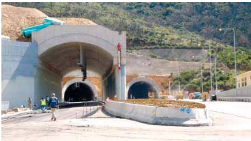
Εικόνα_3.3: Δίδυμη σήραγγα Ραψομαμάτη ( http://www.kalamatablogs.gr/2010/03/23/ )
