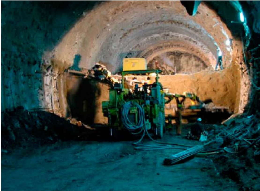
Εικόνα_2.2: Μέθοδος NATM που εφαρμόστηκε στην κατασκευή της σήραγγας Ανθοχωρίου (Τεχνικά Χρονικά, 2004)
