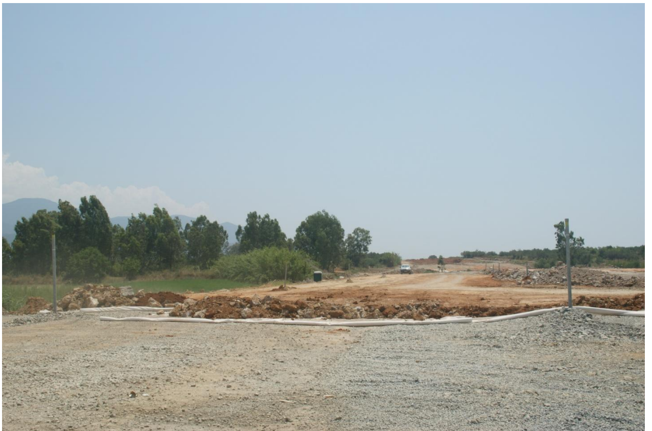
Εικόνα Β-5,Β-6: Τοποθέτηση γεωυφάσματος διαχωρισμού μεταξύ επιχώματος και ζώνης στράγγισης.
