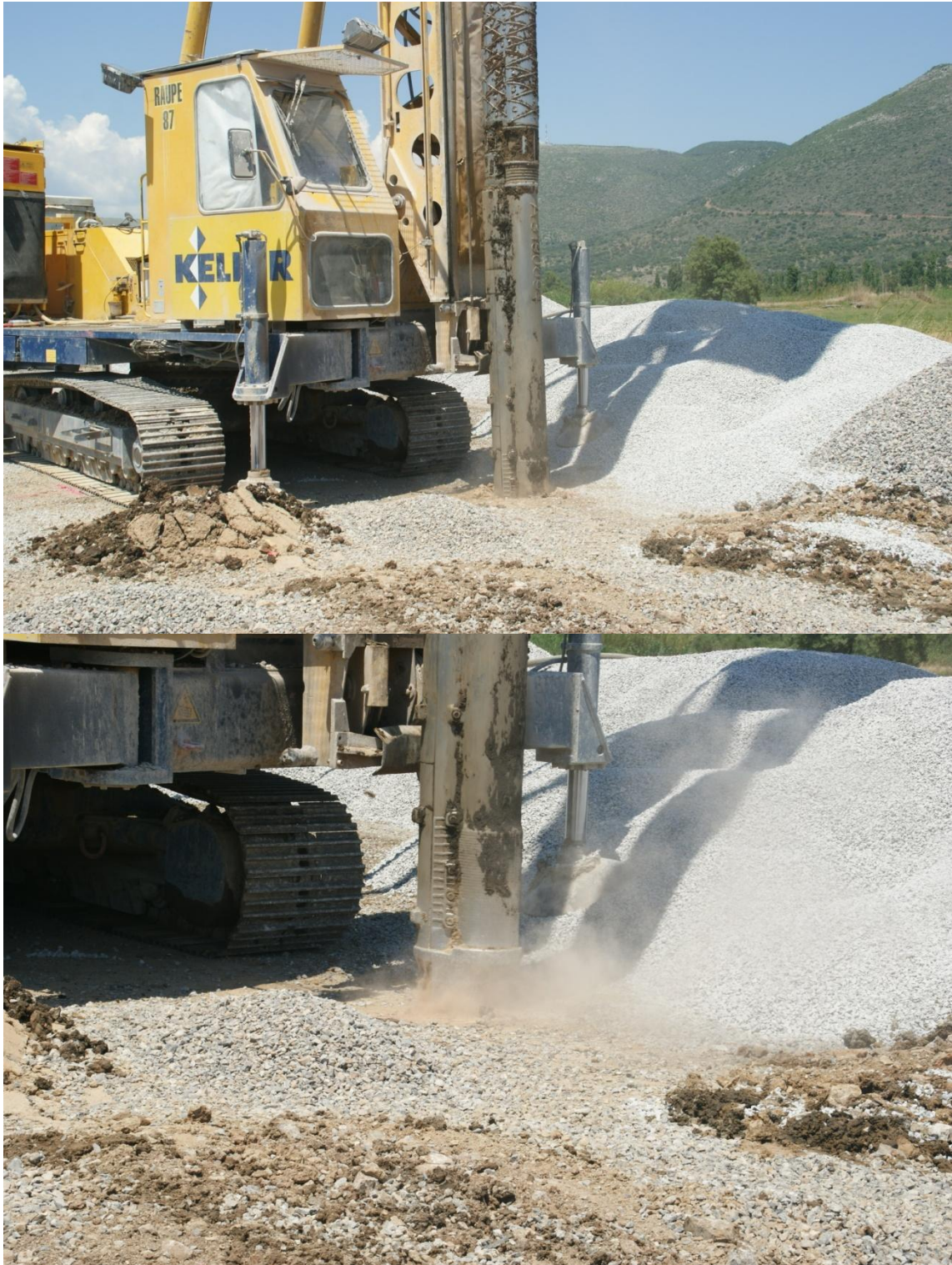
Εικόνα Β-10,Β-11, Β-12: Διείσδυση του δονητή μέχρι το βάθος σχεδιασμού.
