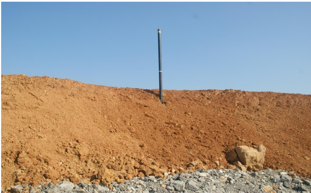
Εικόνα Β-1, Β-2: Μάρτυρες για την καταγραφή των καθιζήσεων του επιχώματος.
