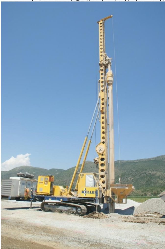
Εικόνα Β-9: Τροφοδοσία του μηχανήματος Δονητικής Συμπύκνωσης με αδρανή.
