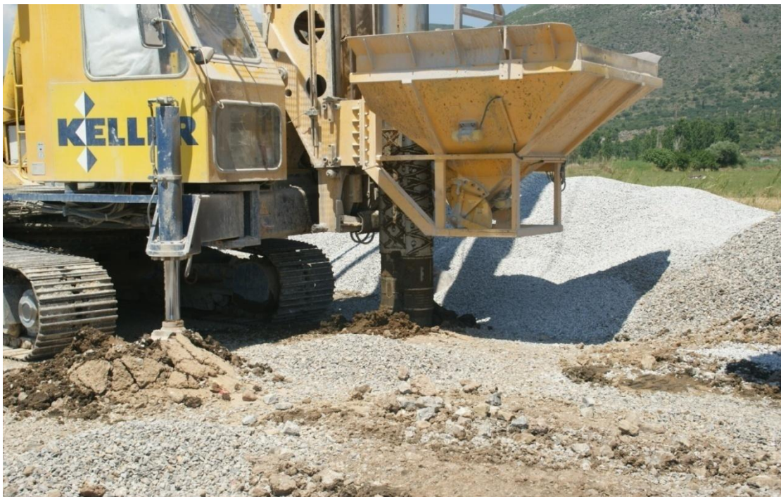
Εικόνα Β-7,Β-8: Κατασκευή χαλικοπασσάλων.
