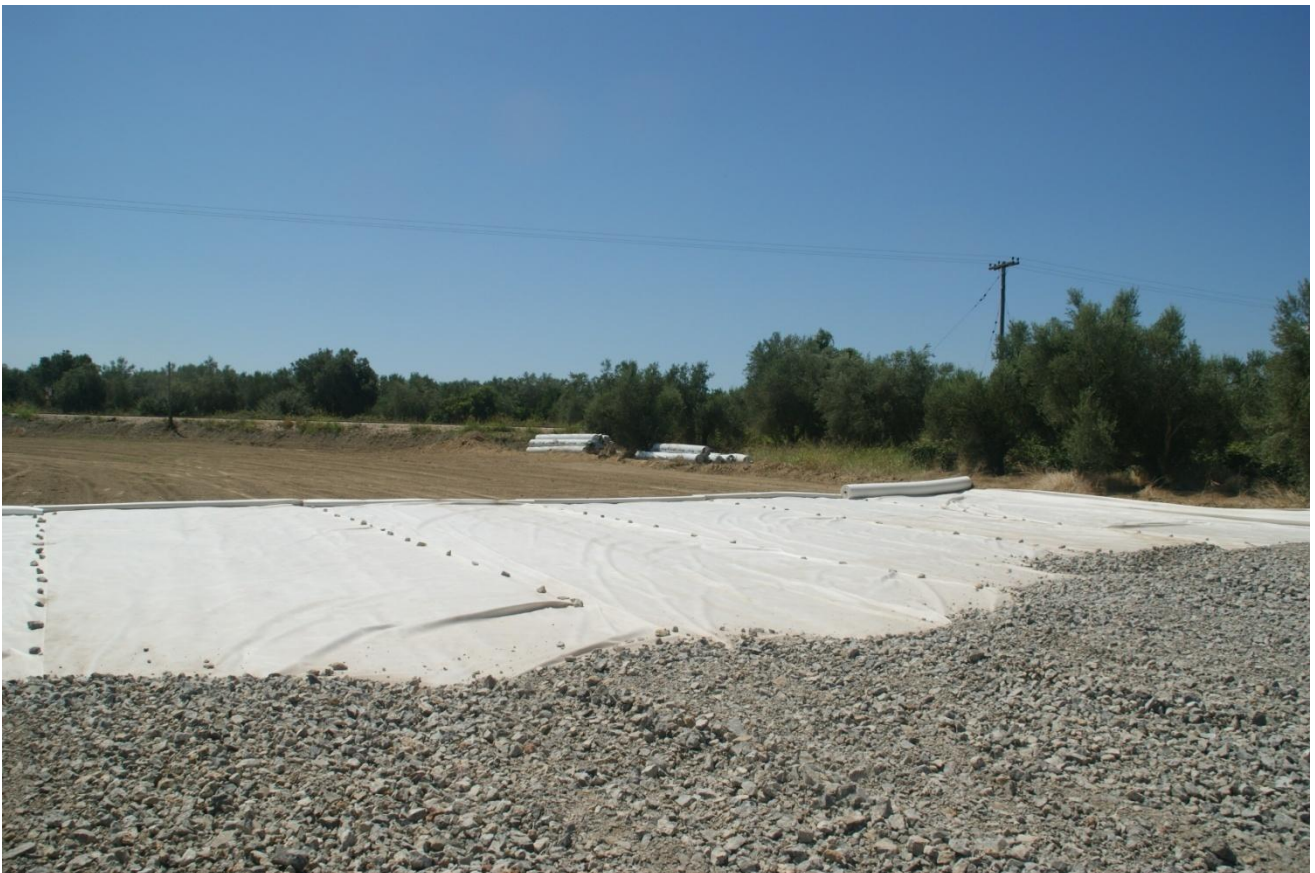
Εικόνα Β-4: Τοποθέτηση γεωφάσματος.
