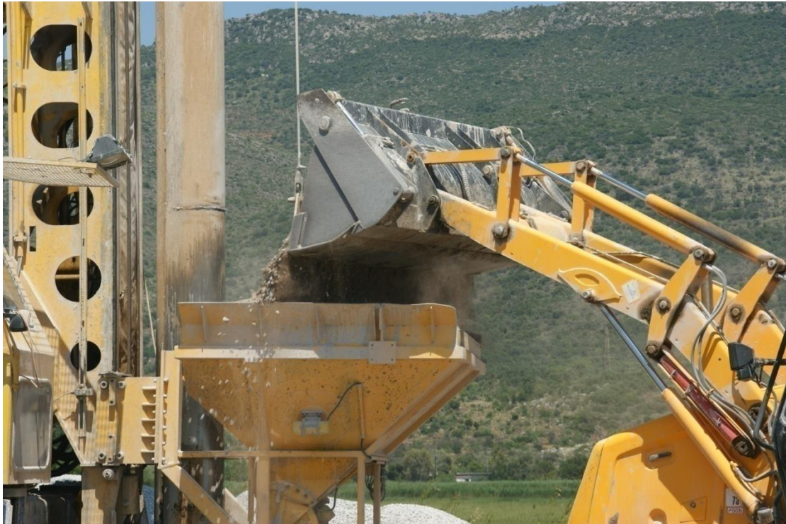
Εικόνα Β-9: Τροφοδοσία του μηχανήματος Δονητικής Συμπύκνωσης με αδρανή.
