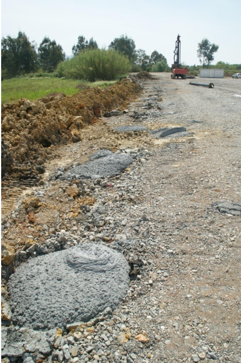
Εικόνα Β-14: Κατασκευή πασσάλων άοπλου σκυροδέματος στον πόδα του επιχώματος.
