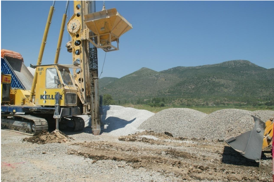
Εικόνα 5.1: Το μηχάνημα κατασκευής των χαλικοπασσάλων. Διακρίνονται το στέλεχος έμπηξης, ο τροφοδότης των αδρανών, τα αδρανή σε στοιβές καθώς και ο κουβάς του εκσκαφέα που τροφοδοτεί το μηχάνημα με τα αδρανή.
