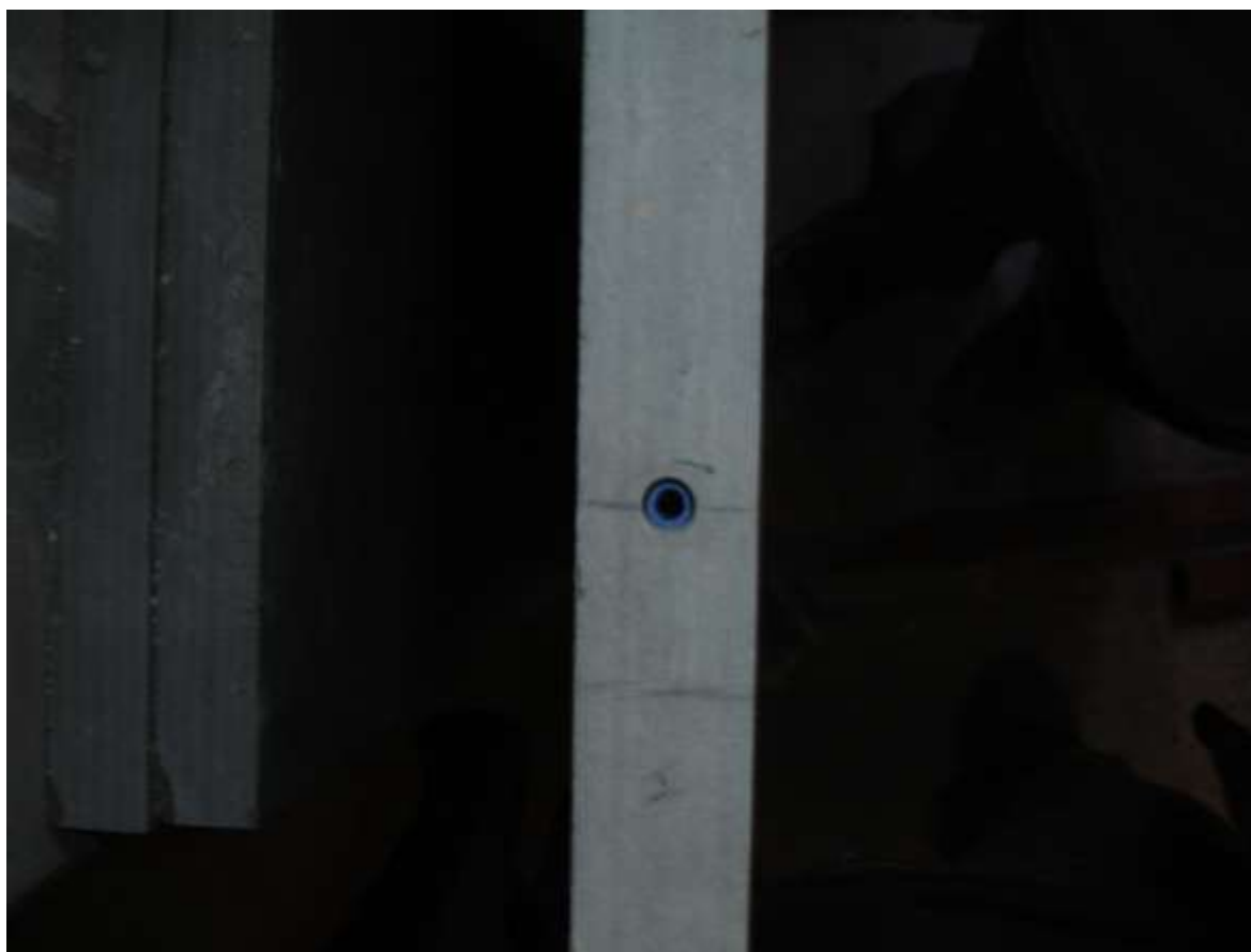
Εικόνα 16: Οπή για καβίλα σε πλάκα μαρμάρου
