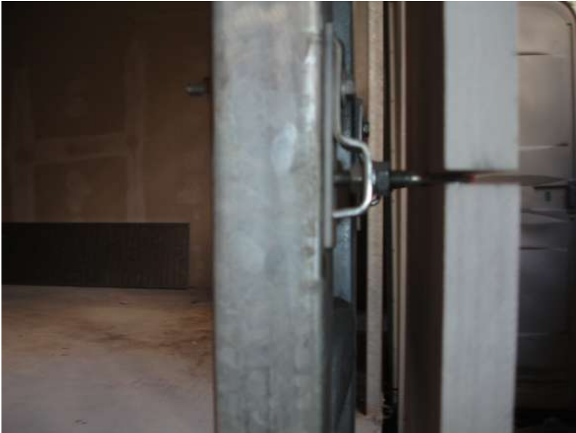
Εικόνα 17: Στήριξη αγκυρίου, εγκατεστημένου σε κοιλοδοκό, με πλάκες μαρμάρου
