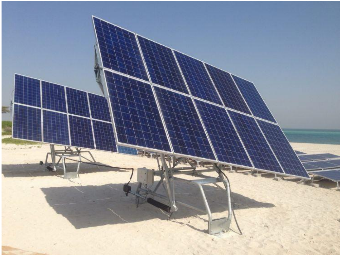
Εικόνα 9 1,5 axis tracker
