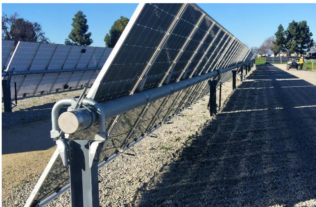
Εικόνα 7 Single axis tracker
