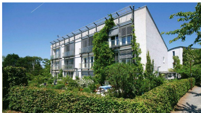
Εικόνα 3.4: Το πρώτο παθητικό κτήριο στο Darmstadt
