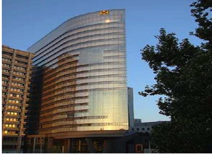
Εικόνες 3.12: RHW.2 Office Tower in Vienna, Austria
