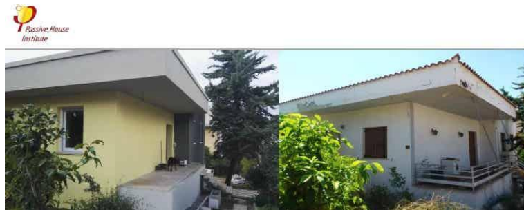
Εικόνα 3.16: Passivistas: The House Project (Paragou, Athens, Greece), το κτήριο που εξετάζεται στην εργασία και αποτελεί το πρώτο πιστοποιημένο παθητικό κτήριο ύστερα από ανακαίνιση και ενεργειακή αναβάθμιση στην ΝΑ Μεσόγειο και το πρώτο EnerPHit Plus στον κόσμο. Πρίν (δεξιά) και μετά (αριστερά) την ανακαίνιση τοπικού κτηρίου του 1964 [76]
