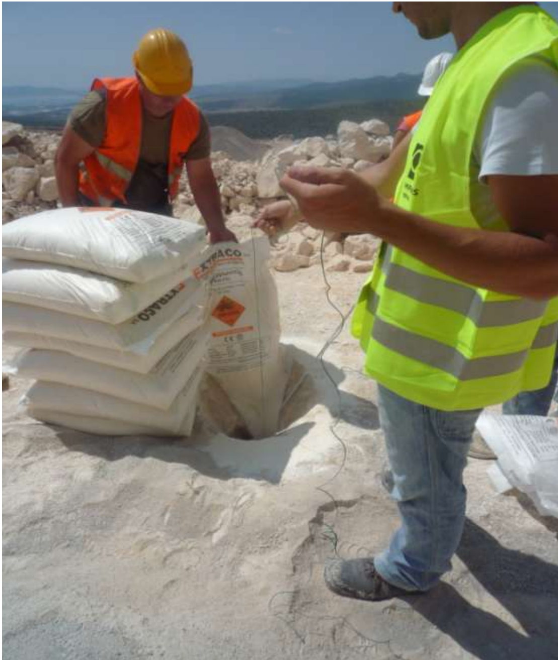
Εικόνα 29 : Γόμωση διατρήματος με ANFO
