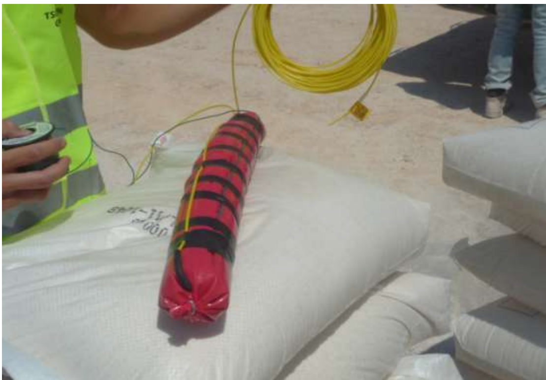
Εικόνα 27: Ο πυροκροτητής Nonel δένεται κατάλληλα στο φυσίγγιο της εναυσματικής γόμωσης
