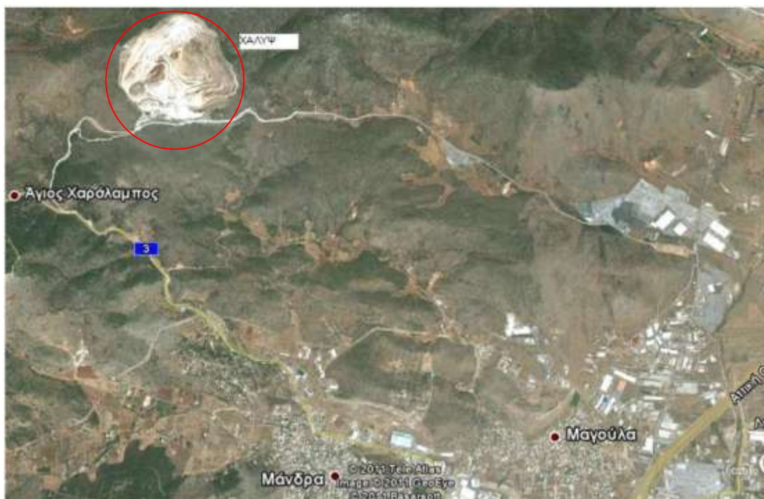
Εικόνα 21 : Αποτύπωση του λατομείου ΧΑΛΥΨ (πάνω και αριστερά) μέσω του Google maps
