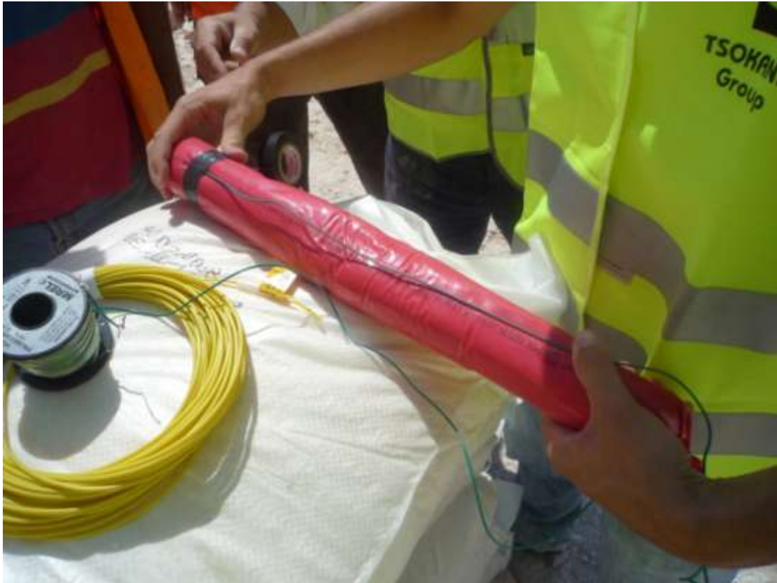
Εικόνα 25 : Φυσίγγιο εναυσματικής γόμωσης Poladyn 31 Eco και αισθητήρας PROBLECABLE-HT (πράσινο καλώδιο)
