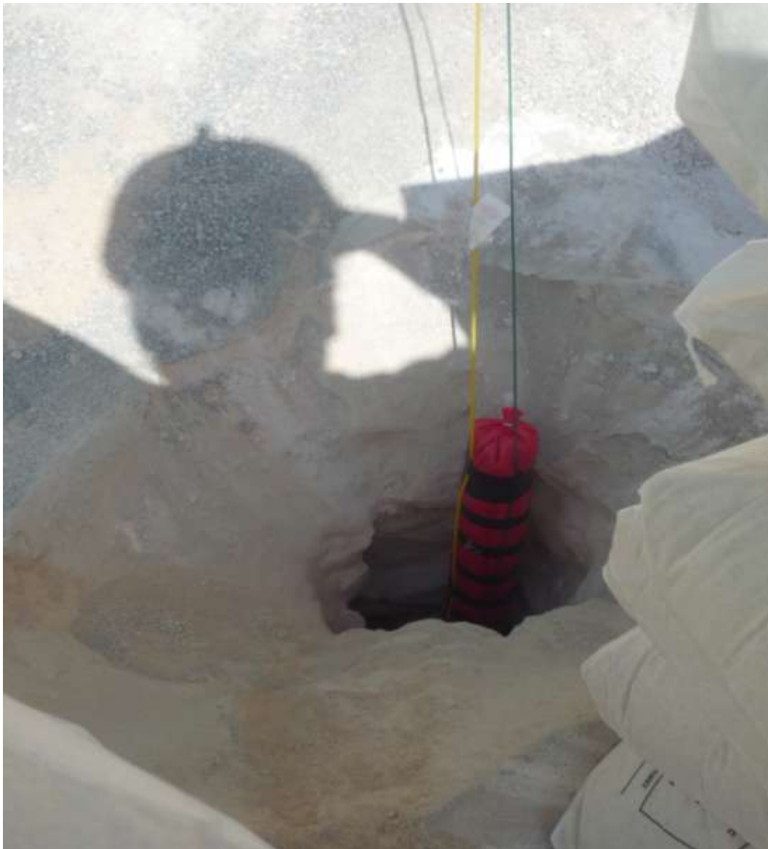
Εικόνα 28 : Το φυσίγγιο ο αγωγός PROBLECABLE-HT και ο σωλήνας Nonel κατεβαίνουν στο διάτρημα
