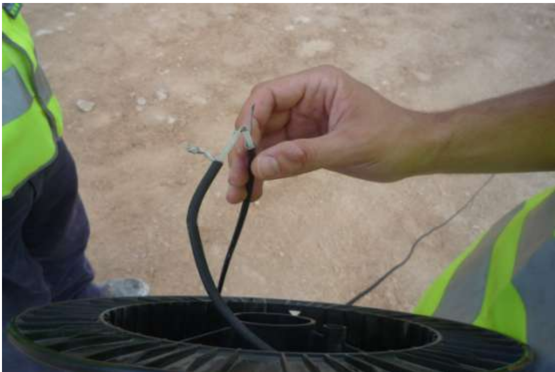
Εικόνα 32 : Το μονοαξονικό καλώδιο RG-58/U ενώνεται με τον αντάππορα BNC
