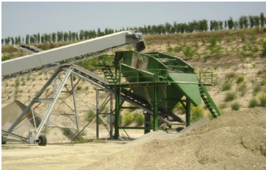
Σχήμα 3.4 - Είσοδος του υλικού στο θραυστήρα
