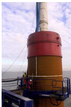
Σχήμα 8.2 Διαδικασία έμπηξης μονοπασσάλου μέσω ειδικού σφυριού [Kaiser & Snyder]
