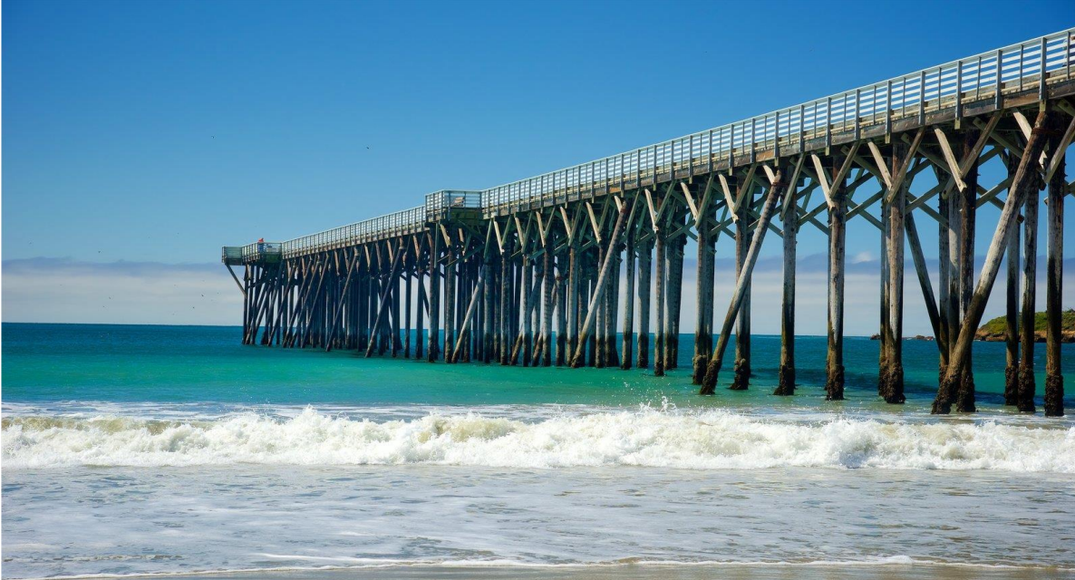
Εικόνα 1.2 Τυπική διάταξη μελών προβλήτας [Γαντές & Θανόπουλος , 2019]
