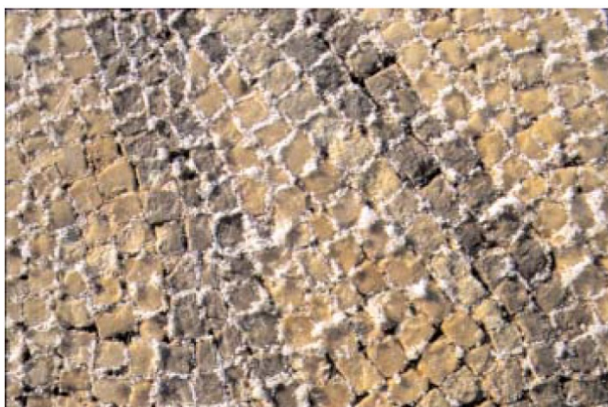
Εικόνα 22. Εξάνθιση αλάτων στα περατωτικά όρια ψηφίδων.
