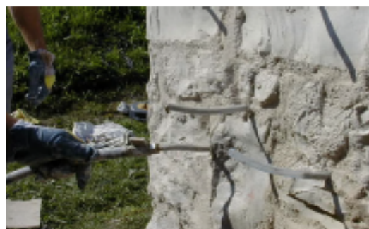
Εικόνες 5, 6, 7, 8. Εφαρμογή ενεμάτων σε τοιχοποιία
