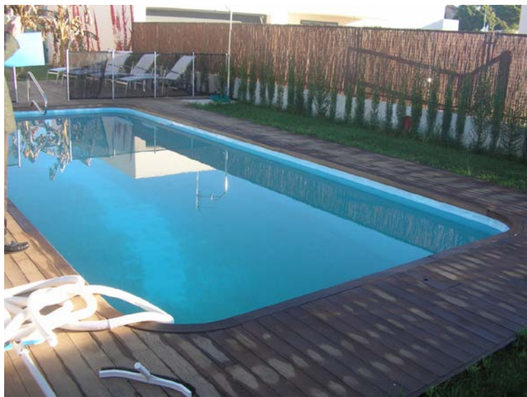
Σχήμα 2.5. Εφαρμογή ινοπλισμένου πολυεστέρα σε προκατασκευασμένες κατασκευές.
