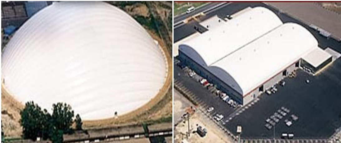
Σχήμα 2.4. Αριστερά μια αρχιτεκτονική κατασκευή πολυεστέρα με επίχρσιμα PVC και στήριξη από σύστημα εσωτερικής πίεσης αέρα, και δεξιά μια οροφή πολυεστέρα με εσωτερική στήριξη από χαλύβδινο σκελετό.
