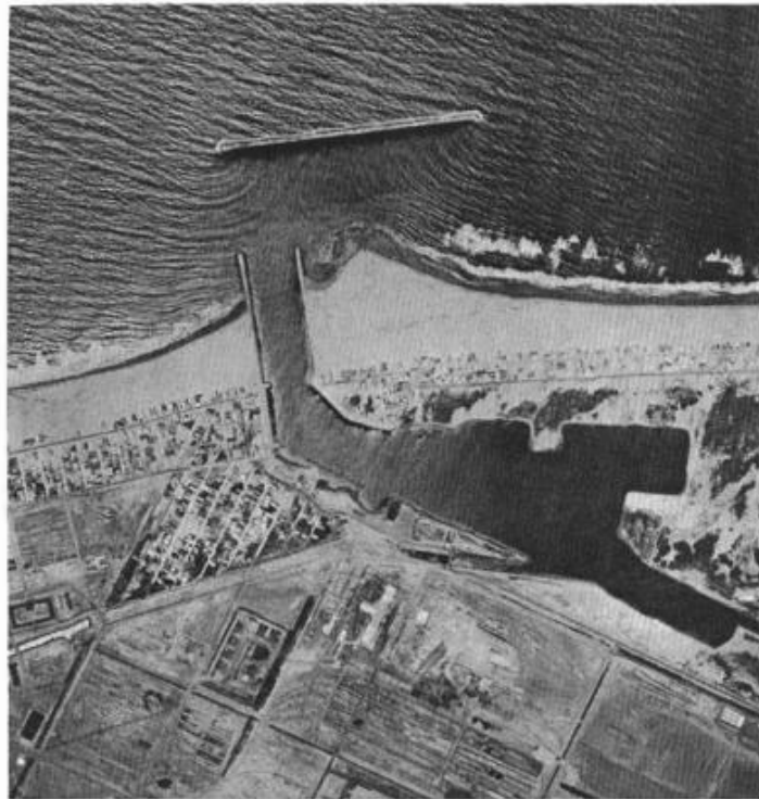
Εικόνα 8 Περίθλαση λόγω ύπαρξης κυματοθραύστη
