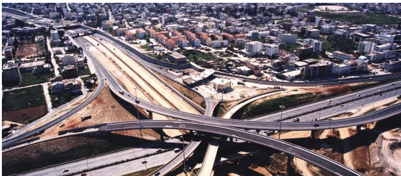
Σχήμα 4. 2: Γέφυρα στον κόμβο Μεταμόρφωσης
