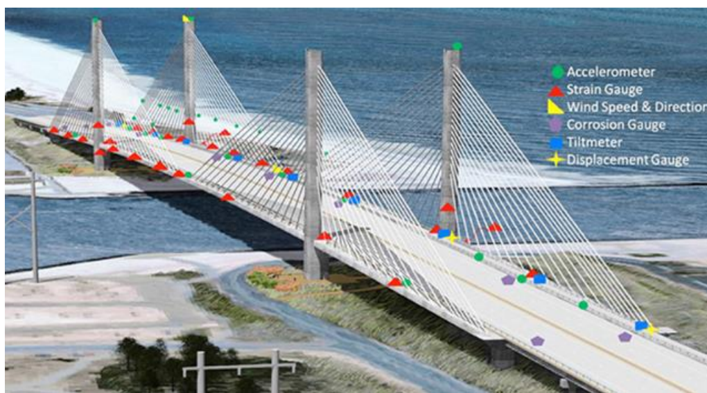
Σχήμα 3. 7 : Σύστημα αισθητήρων που εγκαθίσταται στην γέφυρα
