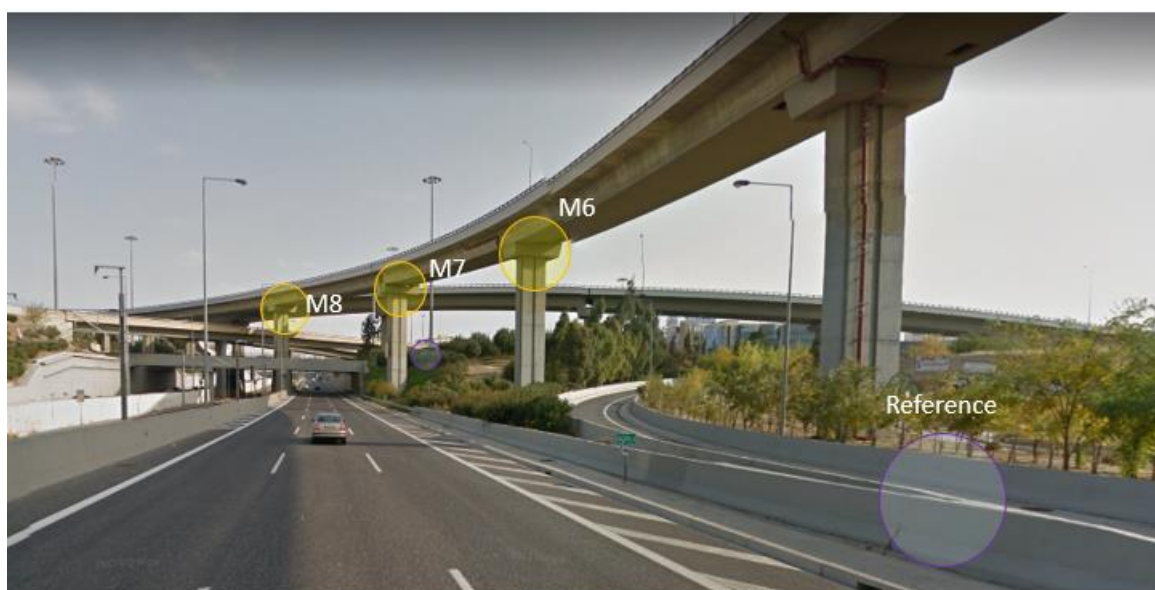
Σχήμα 4. 4 :Θέσεις των κλισιόμετρων στη στέψη των υψηλών βάθρων M6, M7, M8 και στο έδαφος.
