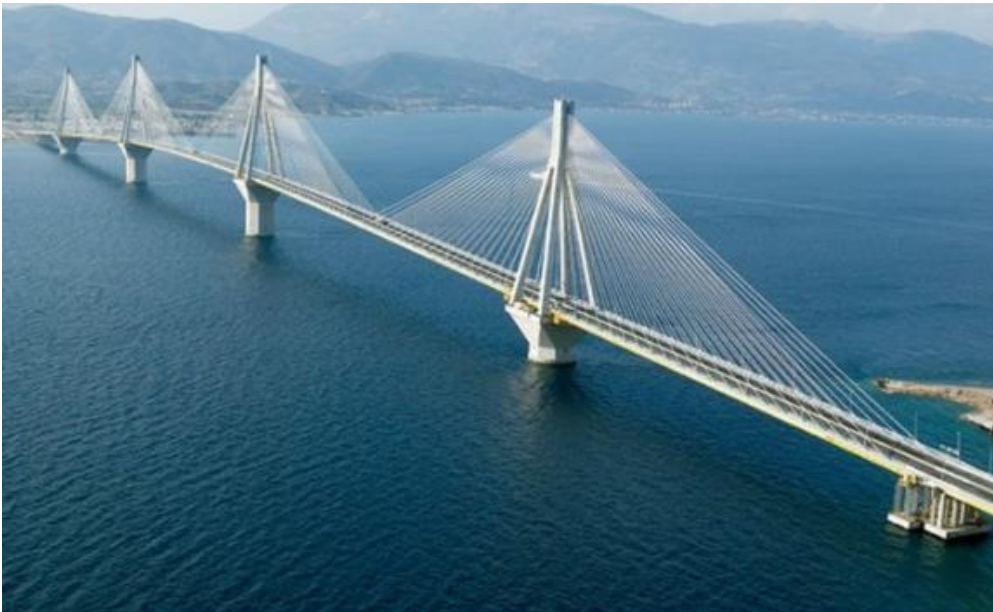
Σχήμα 2. 4: Γέφυρα Ρίου-Αντιρρίου, Πάτρα, Ελλάδα
