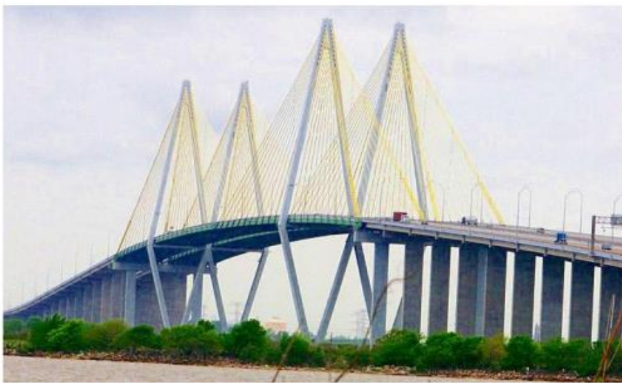
Σχήμα 2. 5: Γέφυρα Fred Hartman, Τέξας, Ηνωμένες Πολιτείες Αμερικής Figure 2.5: Fred Hartman bridge, Texas, U.S. of America (Πηγή: http://www.aecom.com )
