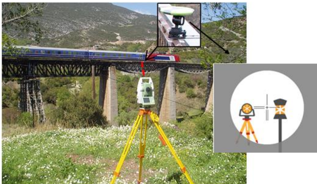
Σχήμα 1.11: Εφαρμογή για παρακολούθηση γέφυρας με την χρήση Ρομποτικού γεωδαιτικού σταθμού.
