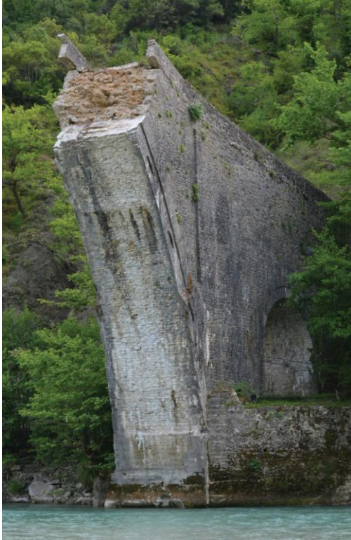
Εικόνα 11. Άποψη του του δυτικού βάθρου από τα βόριο-ανατολικά με εμφανή σημάδια φθοράς
