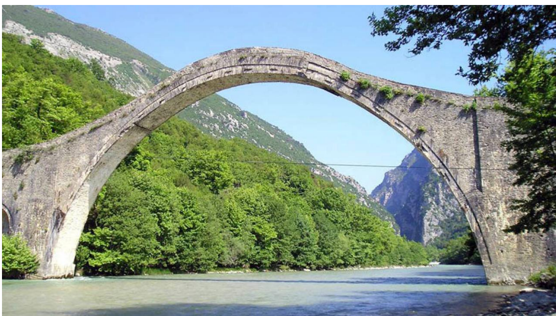
Εικόνα 5. Το γεφύρι της Πλάκας
