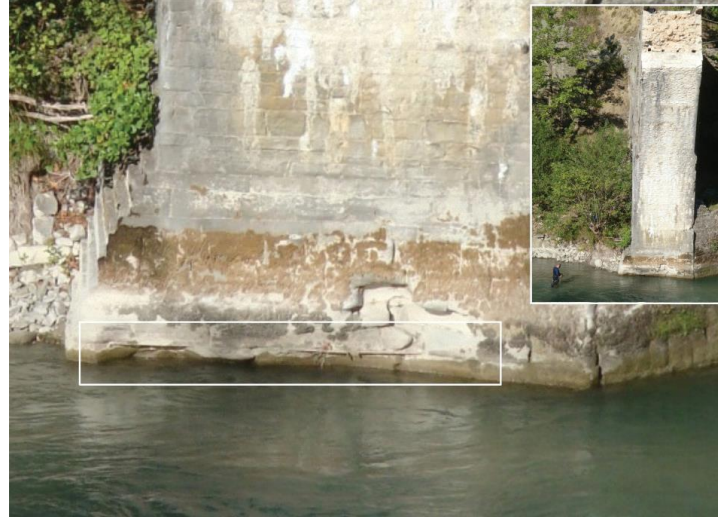
Εικόνα 8. Διακρίνονται στο λευκό πλαίσιο διαμήκεις μεταλλικοί σύνδεσμοι στο δυτικό βάθρο.
