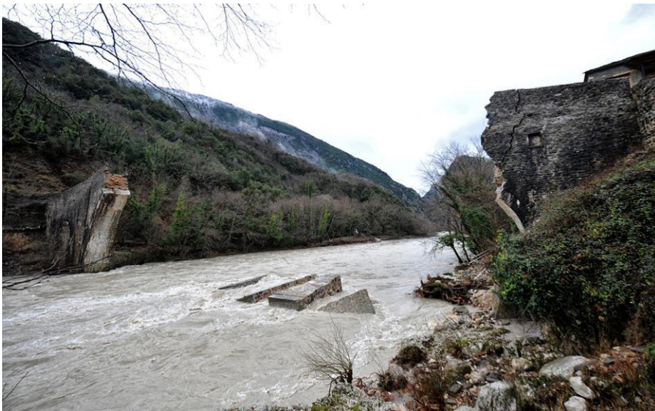
Εικόνα 12. Τα τμήματα του γεφυριού που παρέμειναν στην θέση τους και τα απομεινάρια που κατέληξαν στην κοίτη του ποταμού
