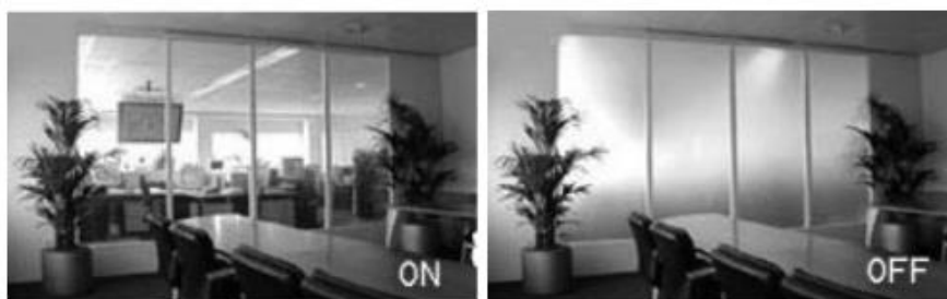
Σχήμα 4.11: Παράθυρα με στοιχεία υγρών κρυστάλλων στη διαφανή (αριστερά) και αδιαφανή (δεξιά) τους κατάσταση
