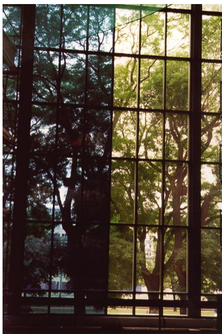
Σχήμα 4.6: Ηλεκτροχρωμικοί υαλοπίνακες στην αδιαφανή (αριστερά) και τη διάφανη (δεξιά) τους κατάσταση
