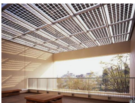
Σχήμα 3.11: Παράδειγμα ενσωμάτωσης φωτοβολταϊκών υαλοπινάκων σε κτίριο
