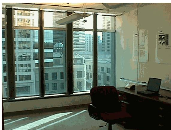
Σχήμα 4.7: Εφαρμογή των ηλεκτροχρωμικών παραθύρων E-Control της Pilkington σε κτίριο γραφείων
