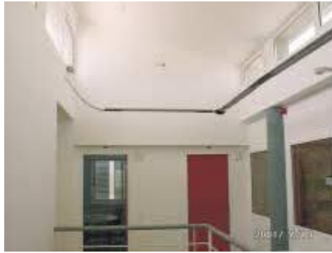
Εικόνα 3.6: Το ηλιακό αίθριο που χρησιμοποιείται ως σύστημα παθητικού δροσισμού, έμμεσου φυσικού φωτισμού και ηλιασμού [34].
