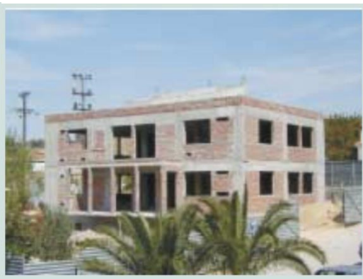
Εικόνα 3.4: Νοτιοανατολική όψη του κτηρίου κατά την περίοδο κατασκευής των οπτοπλινθοδομών [34]
