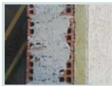
Εικόνα 3.5: Λεπτομέρεια εξωτερικής οπτοπλινθοδομής με εξωτερική θερμομόνωση [34].
