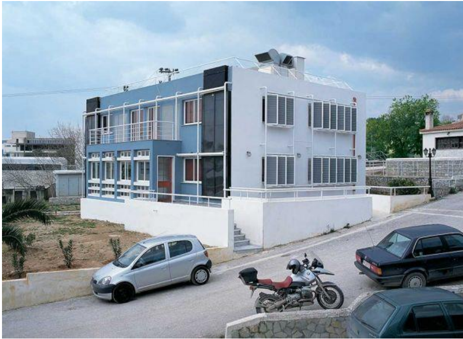
Εικόνα 3.1: Το μελετηθέν κτήριο γραφείων εξωτερικά [35]
