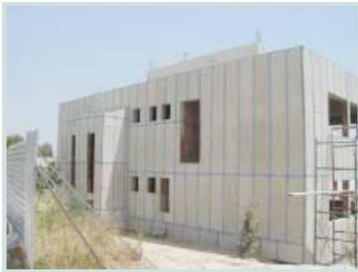
Εικόνα 3.3: Εξωτερική θερμομόνωση της βόρειας όψης του κτηρίου [34]
