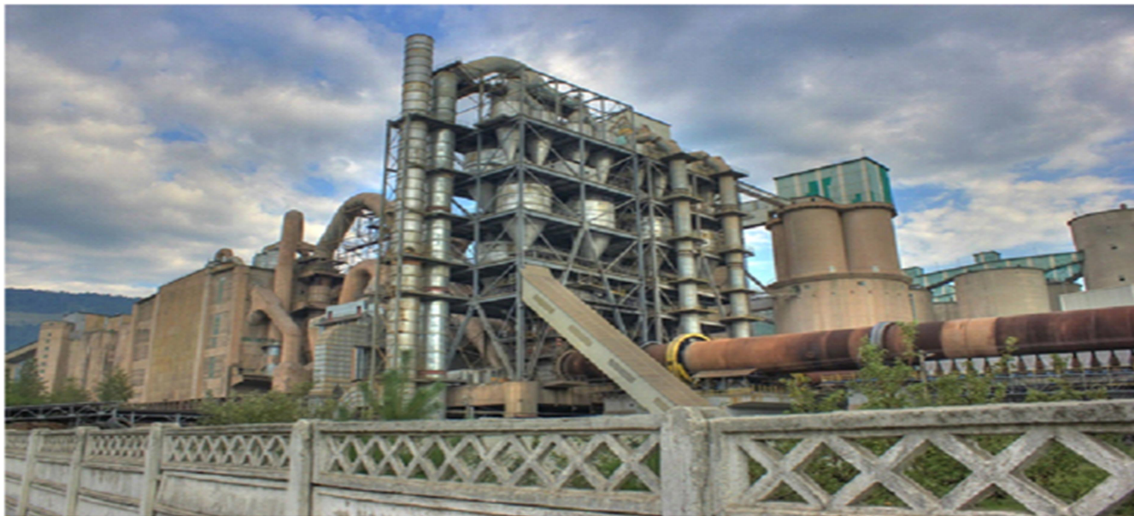
Εικόνα 1.6 Περιστροφική κάμιнос κλίνκερ τσιμεντοβιομηχανίας
