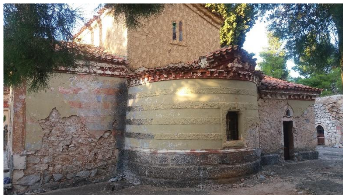
2. 19 Άποψη της στέγης της νότια κόγχης
