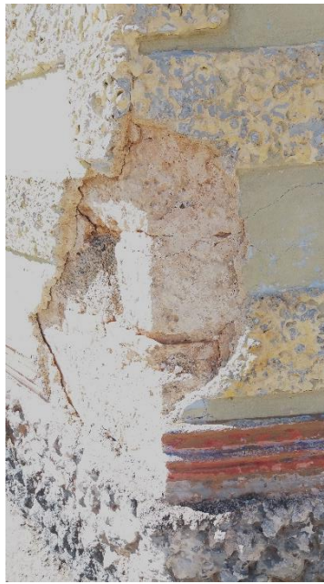
2. 24 Ανατολική Όψη-Ορθή γωνία σύνδεσης-Τοίχος της κεντρικής κόγχης του ιερού
