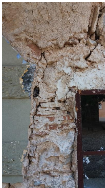
3. 27: Πρόχειρη διάνοιξη ανοίγματος –επέμβαση του 20ου αιώνα-Κακή αλληλοεμπλοκή με τον υπόλοιπο τμήμα του τοίχου- Βόρεια όψη
