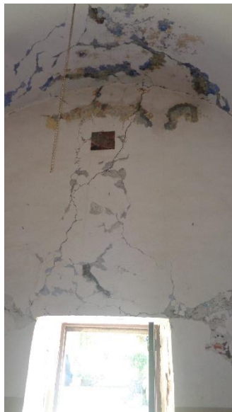
3. 21: Διατμητικές αστοχίες στην δυτική όψη του νάρθηκα
