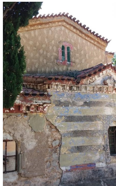
2. 18. Άποψη της στέγης της βόρειας κόγχης
