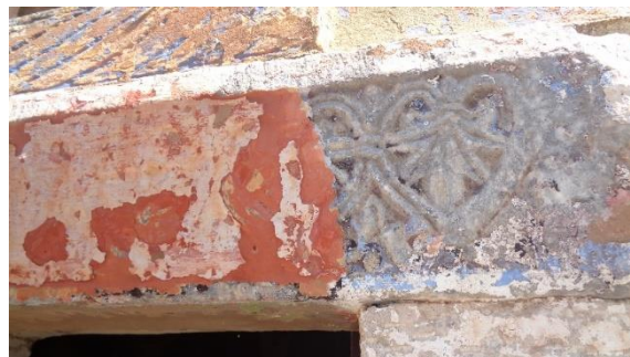
2. 15. Μονολιθικό στοιχείο στο ανώφλι του ανοίγματος της θύρας
