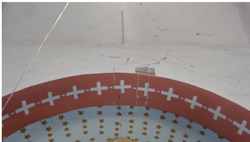
3. 7. Κάθετες ρωγμές στο πάχος του τόξου που χωρίζει το ιερό από το κύριο κλίτος
