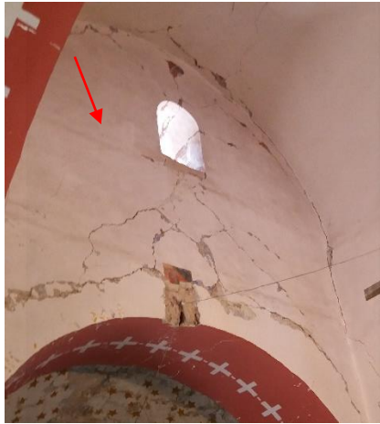
2. 6. Ίχνος της ξυλοδεσιάς στο τύμπανο της νότιας όψης
