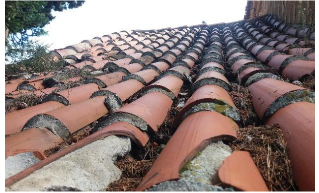
3. 2 Σπασμένα κεραμίδια και διαβρωμένο κονίαμα
