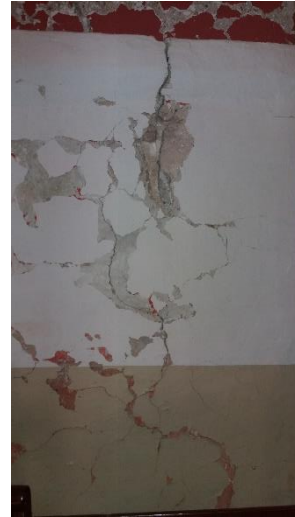
3. 13: Κατακόρυφη περίξ των λιθοσωμάτων κοντά στο αρμό σύνδεσης μεταξύ των δύο κατασκευαστικών φάσεων
