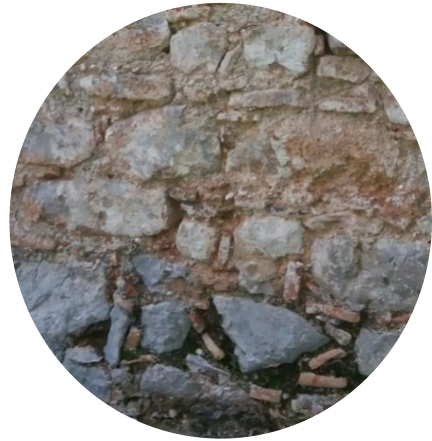
2. 1 α' φάση ασβεστόλιθοι, κροκάλες και κεραμίδι
