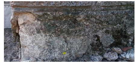
2. 25 Γωνία κοντά στο έδαφος βορειοανατολική άποψη, ορθώς συνδεδεμένη- β' κατασκευαστική φάση
