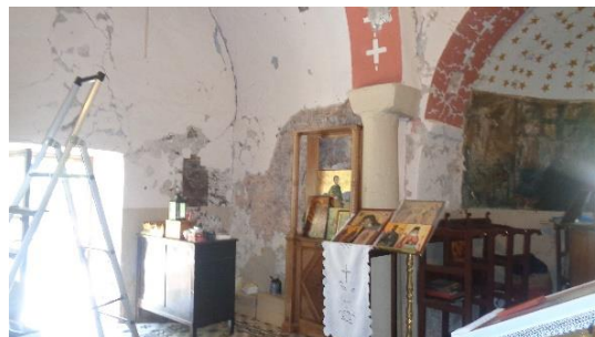
1. 18: Τμήμα δυτικής και βόρειας όψης
