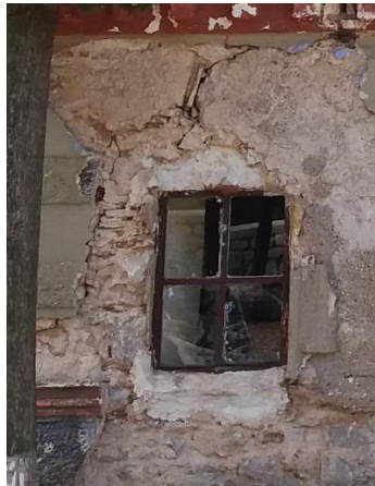
2. 34. Πρόχειρη διάνοιξη στην βόρεια όψη του παραβήματος του ιερού
