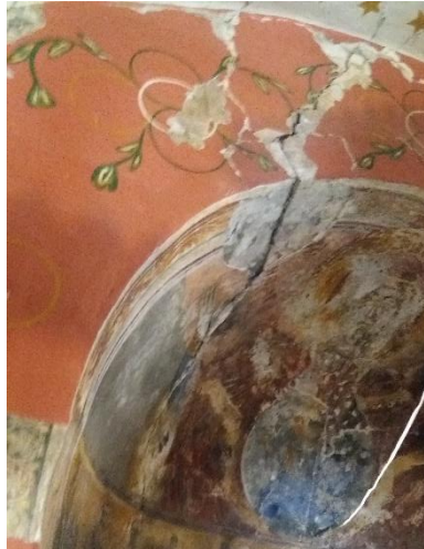
3. 8. Καθίζηση 2cm του λιθοσώματος στο σύνορο του τόξου της αψίδας τους θόλου
