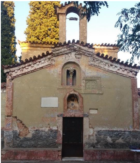
2. 17. Δυτική άποψη της δίρριχτης στέγης του νάρθηκα
