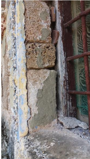
2. 13. Μονολιθικά στοιχεία περιβάλλουν τα ανοίγματα της βόρειας και νότιας κόγχης
