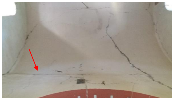
2. 5. Ίχνος της ξυλοδεσιάς στο κατακόρυφο στοιχείο που χωρίζει τον νάρθηκα από το κύριο κλίτος
