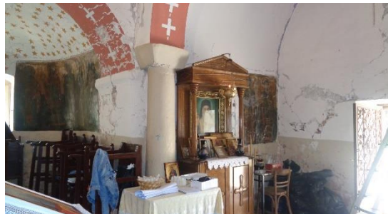
1. 17 Τμήμα δυτικής και νότιας όψης
