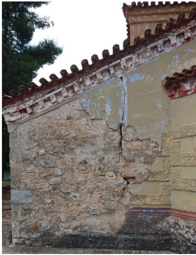
2. 23 Αρμός α' και β' κατασκευαστικής φάσης στην Ανατολική όψη .
