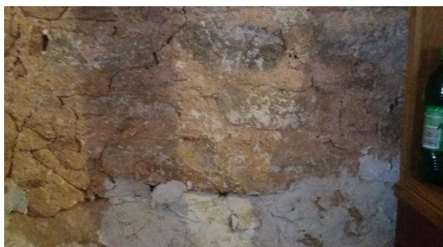
3. 28 Άποψη λιθοδομής από εσωτερικά του ναού-Καλύτερη κατάσταση του κονιάματος
