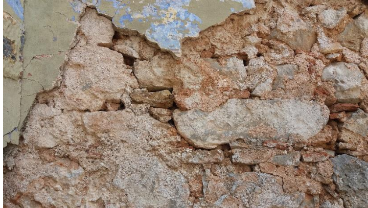
3. 25 Ακατέργαστο σχήμα λιθοσωμάτων- σημαντικό ποσοστό κεραμιδιών –πολλά κενά- Βόρεια όψη
