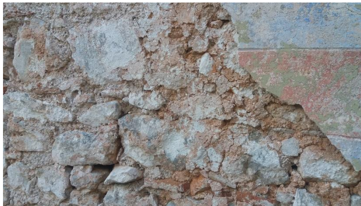
3. 26 Ακατέργαστο σχήμα λιθοσωμάτων- σημαντικό ποσοστό κεραμιδιών –πολλά κενά- Νότια όψη
