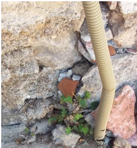
2. 26 Γωνία σύνδεσης βόρειας και δυτικής όψης. Κακώς λαξευμένοι λίθοι μικρών διαστάσεων
