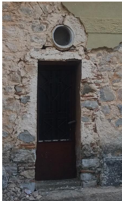
2. 35. Πρόχειρη διάνοιξη της θύρας στη νότια όψη του παραβήματος του ιερού
