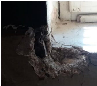
2. 8. Ξύλινο στοιχείο στο άκρο του ανοίγματος της νότιας κόγχης
