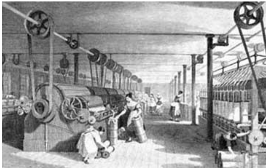
Εικόνα 4. Εργοστάσιο αυτοματισμού που τροφοδοτείται από συστήματα ζωνών και τροχαλιών
