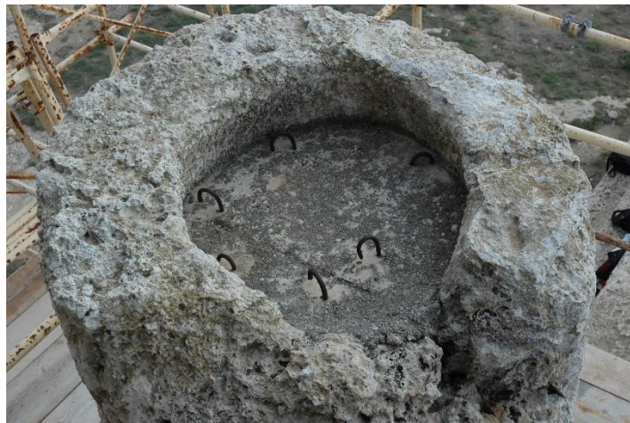
Εικόνα 9. Διαμόρφωση πυρήνα από οπλισμένο σκυρόδεμα στον κίονα κατά την ιταλική αναστήλωση
