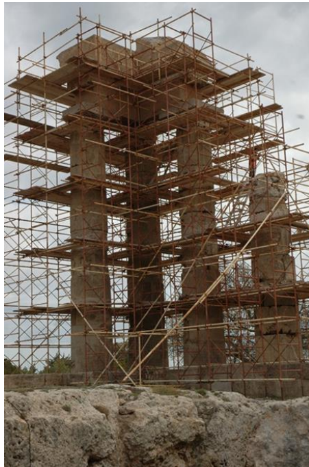
Εικόνα 12. Σημερινή εικόνα του Ναού με την τοποθέτηση ικριωμάτων
