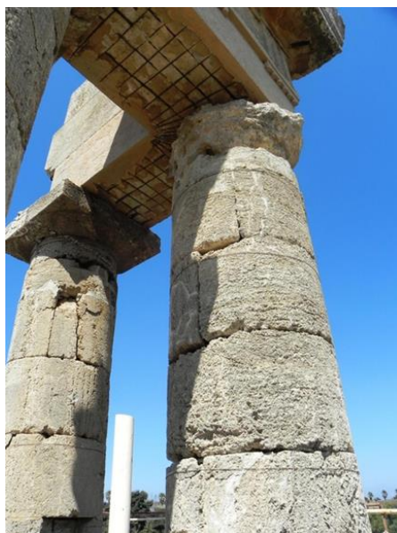
Εικόνα 18. Αποκόλληση επικάλυψης σκυροδέματος στην κάτω επιφάνεια του επιστυλίου
