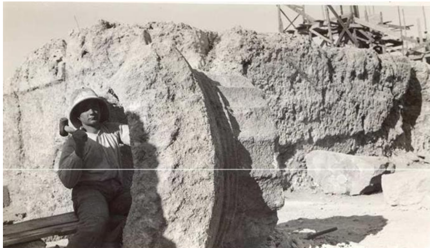
Εικόνα 8. Λάξευση πυρήνα στο αρχαίο κιονόκρανο, 1938
