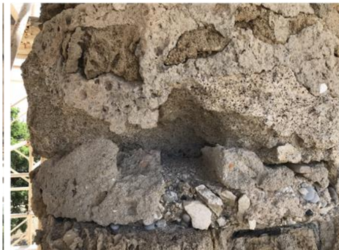
Εικόνα 14. Φαινόμενα σπηλαιώσης στους σπονδύλους των κίωνων
