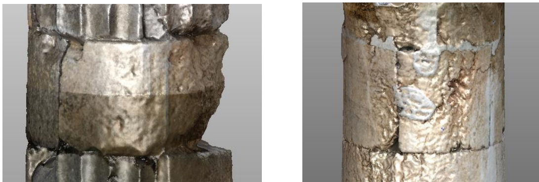
Εικόνα 81 Αποτμήσεις τμημάτων και ρωγμές στους νέους λίθους της ιταλικής αναστήλωσης
