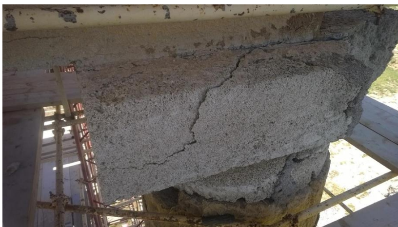
Εικόνα 17. Βλάβες στο αρχαίο κιονόκρανο
