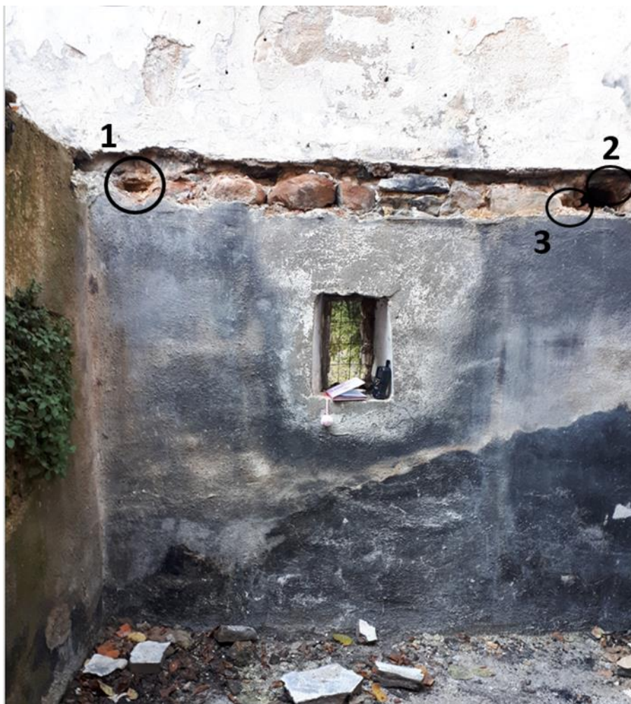
Εικόνα 3.9.: Ακριβής θέση των δειγμάτων που εξετάστηκαν από την περιοχή 1Γ (αριθμοί θέσεων δειγματοληψίας 1-3)
