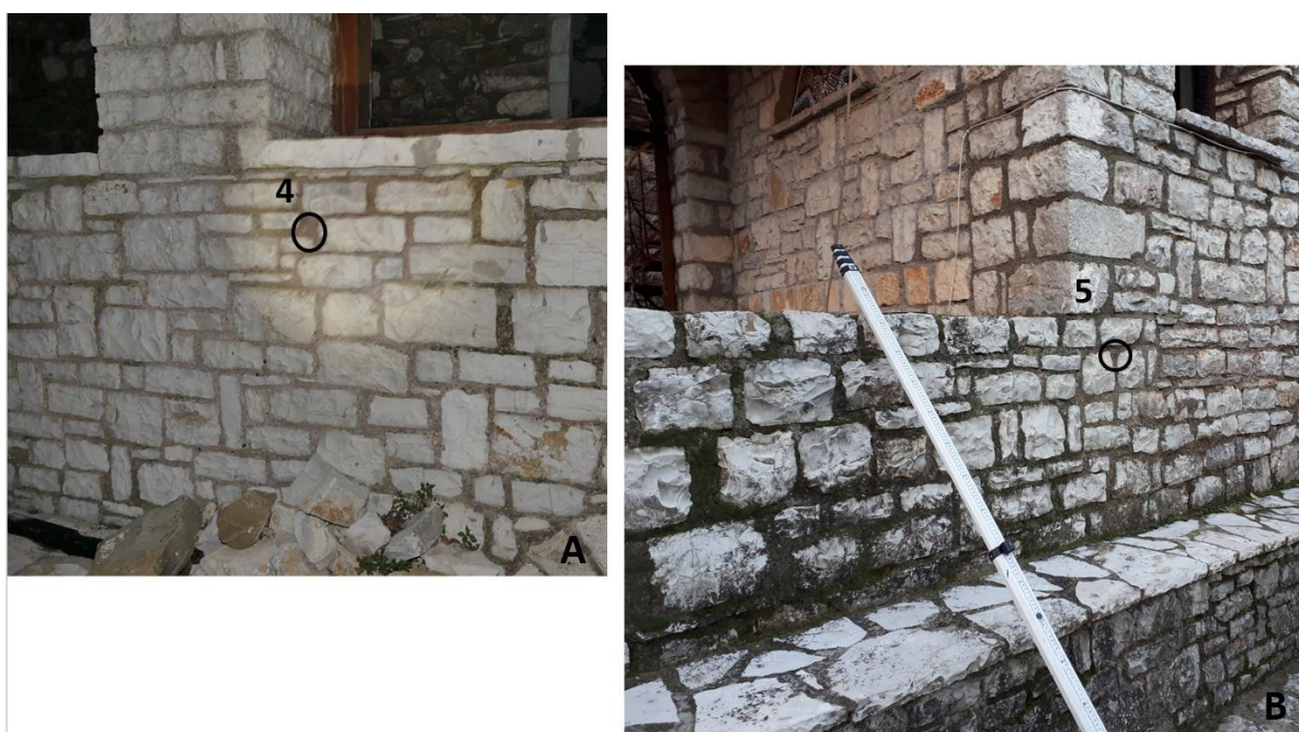
Εικόνα 3.17: Ακριβής θέση των δειγμάτων που εξετάστηκαν από την περιοχή 3Α (θέσεις δειγματοληψίας 4-5)
