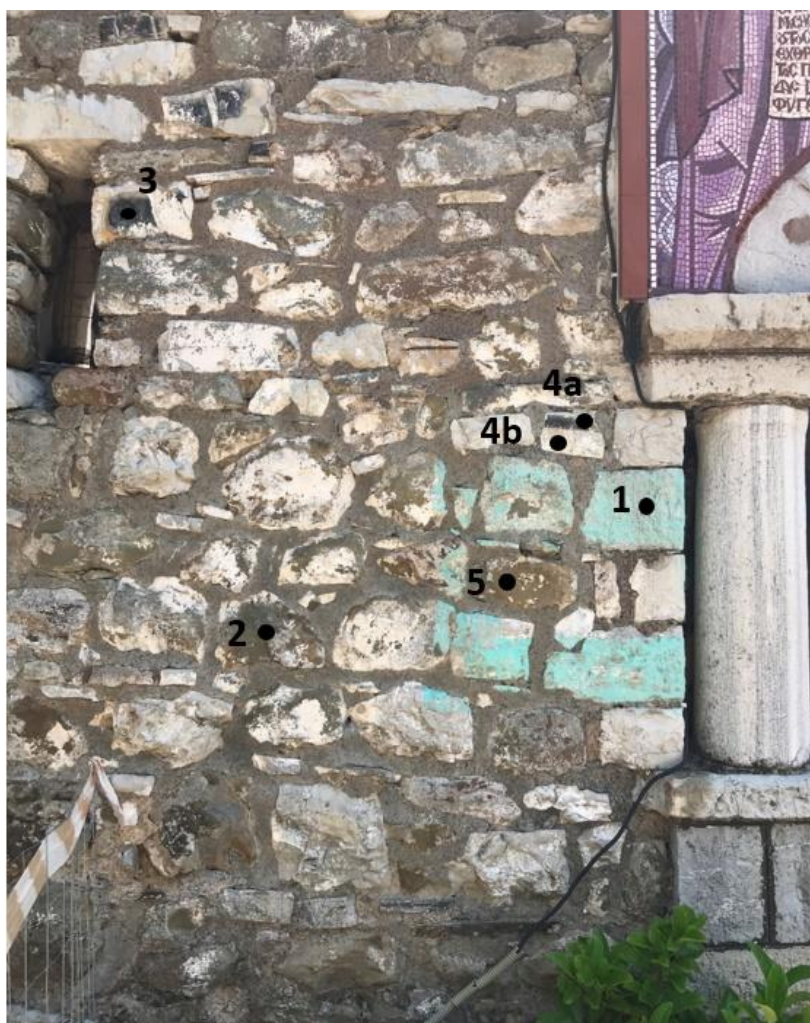
Εικόνα 4.60: Περιοχή 1: Πρόσοψη των κελιών, δίπλα στην είσοδο της Μονής στην περιοχή (ιστορική τοιχοποιία, δυτική όψη). Οι κουκίδες και η αρίθμηση υποδεικνύουν τα λιθοσώματα πού εκτελέστηκαν οι μετρήσεις SHR.
