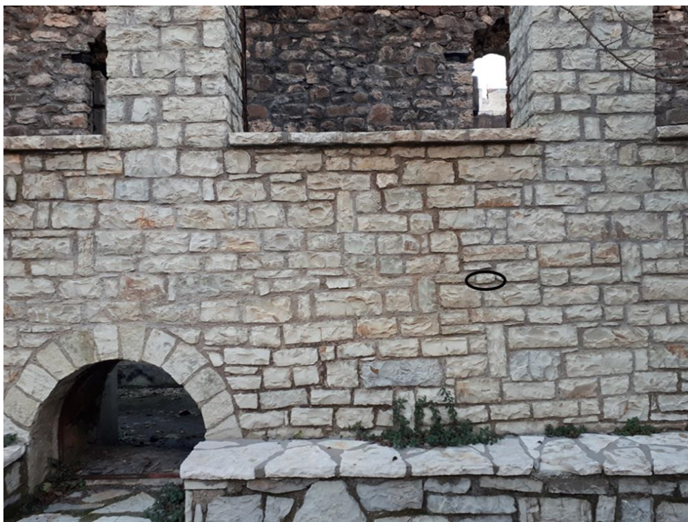
Εικόνα 4.63 : Νέα τοιχοποιία στο μεσαίο τμήμα των κελιών. Υπόδειξη σημείου μέτρησης περιοχής 4
