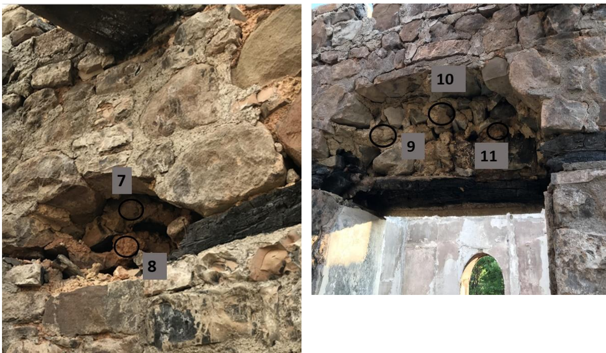
Εικόνα 3.10.: Ακριβή θέση των δειγμάτων που εξετάστηκαν από την περιοχή 2Α (αριθμοί θέσεων δειγματοληψίας 7-11)
