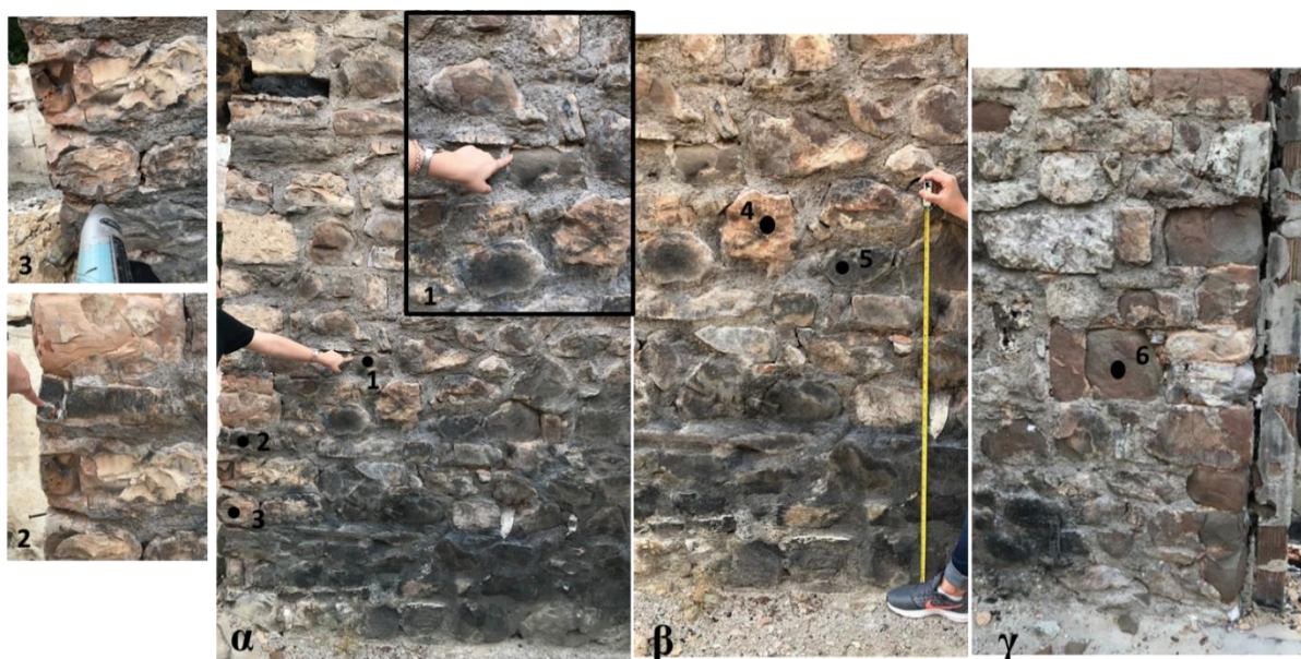
Εικόνα 4.61: Περιοχή 2: Ενδιάμεση τοιχοποιία των κελιών (ιστορικό τείχος, ανατολική όψη). Οι κουκίδες και η αρίθμηση υποδεικνύουν τις περιοχές στις οποίες πραγματοποιήθηκαν οι μετρήσεις SHR: (α) Τρεις υποπεριοχές που εξετάστηκαν κάτω από 50 cm. β) Δύο υποπεριοχές που εξετάστηκαν παραπάνω από 1 m. (γ) Ο εξεταζόμενος ψαμμίτης που έχει επηρεαστεί από τη φωτιά σε ενδιάμεσο ύψος μεταξύ 50cm και 1m. Οι κουκίδες και η αρίθμηση υποδεικνύουν τα λιθοσώματα που εκτελέστηκαν οι μετρήσεις SHR
