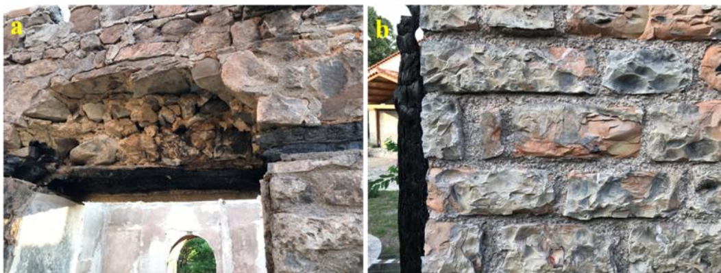
Εικόνα: 2.4(α) Κατάρρευση οικοδομικών υλικών από το ανώτερο τμήμα της ενδιάμεσης τοιχοποιίας. (β) Αποχρωματισμός και απολέπιση του μπεζ-γκρίζου ασβεστόλιθου στην εσωτερική (δυτική) πρόσοψη της νέας τοιχοποιίας.[59]
