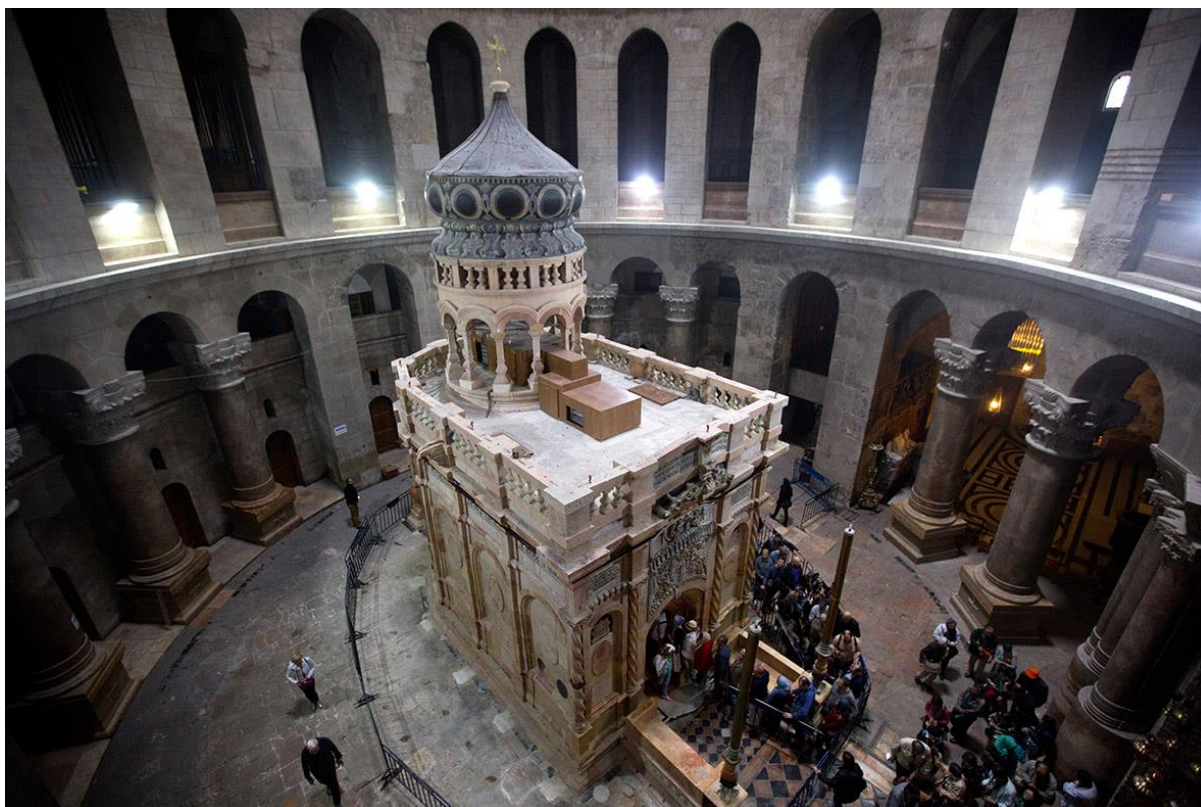
Εικόνα 9 Κατάσταση Κουβουκλίου μετά από την τελευταία αναστήλωση
