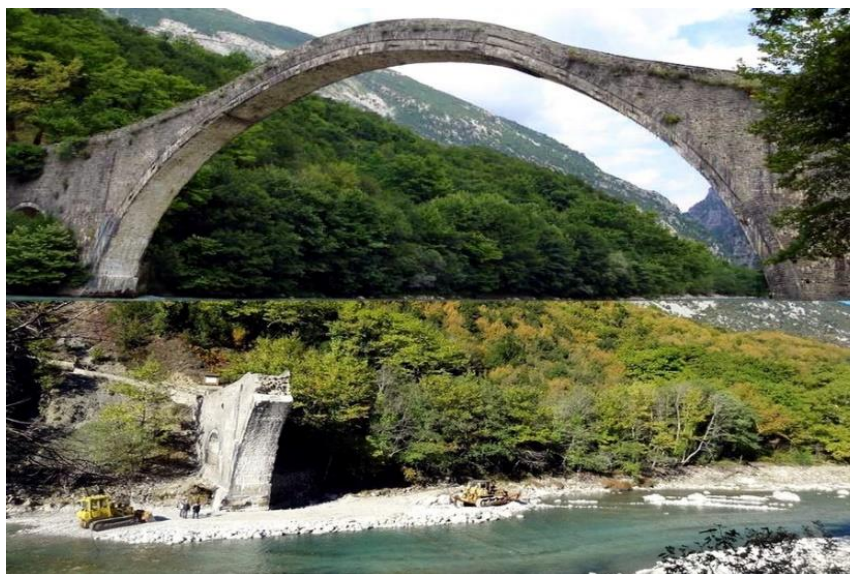
Εικόνα 6: Άποψη Γέφυρας πριν και μετά την κατάρρευση
