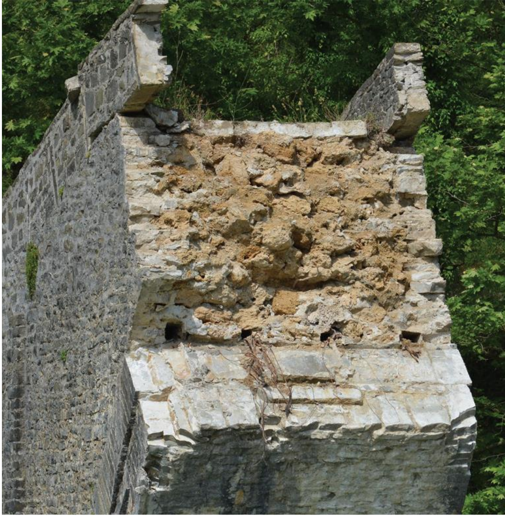
Εικόνα 22: Επιφάνεια αστοχίας δυτικού βάρου
