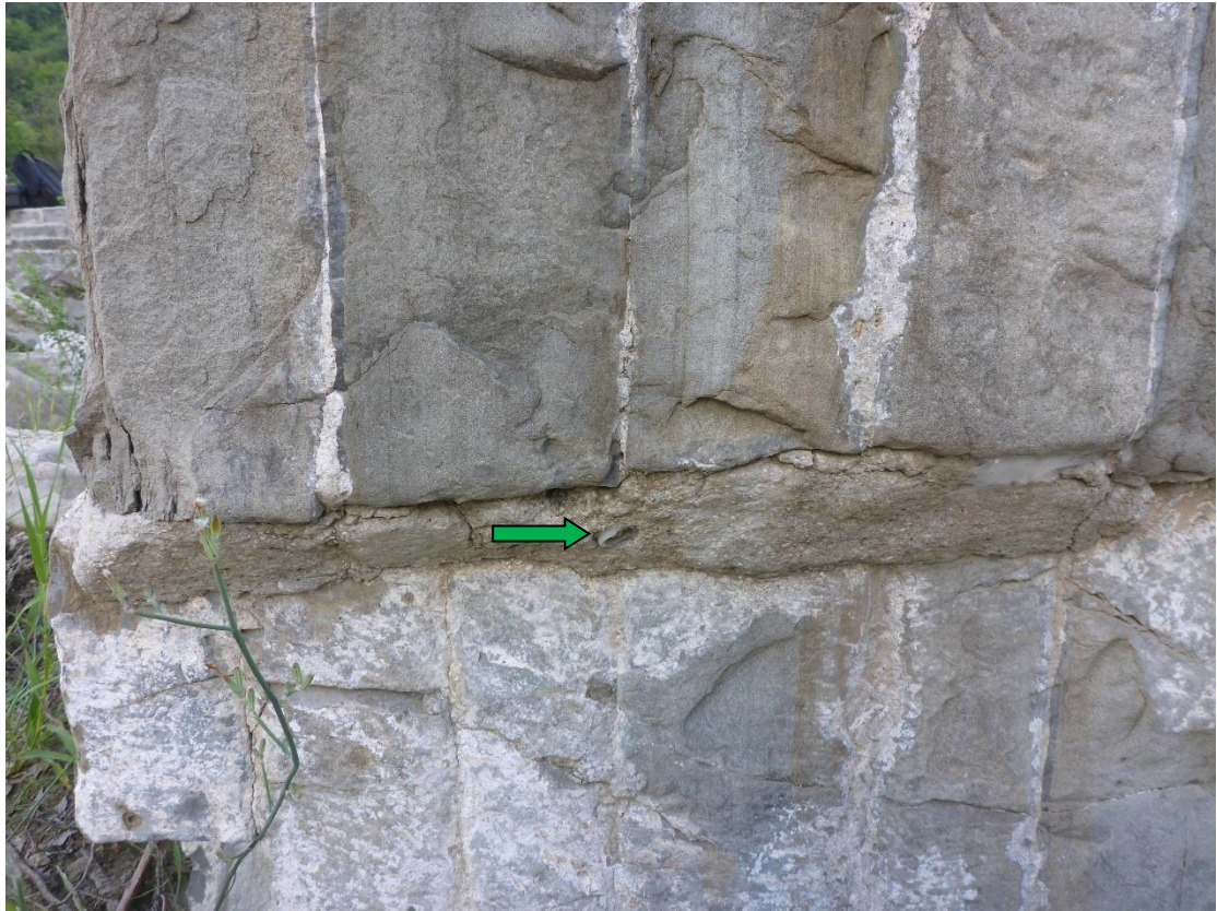
Εικόνα 28: Σωληνάκι ενεμάτωσης στο εναπομείναν τμήμα 1
