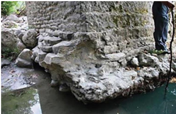
Εικόνα 15: Υποσκαφή θεμελίων
