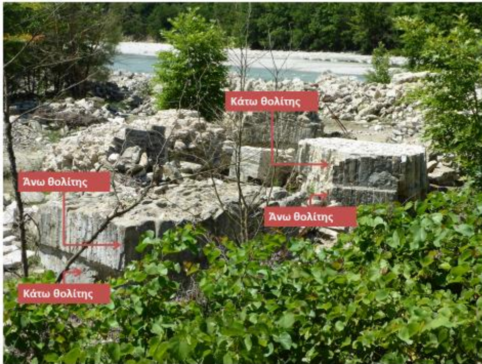
Εικόνα 25: Εναπομείναντα τμήματα των θολιτών του Γεφυριού
