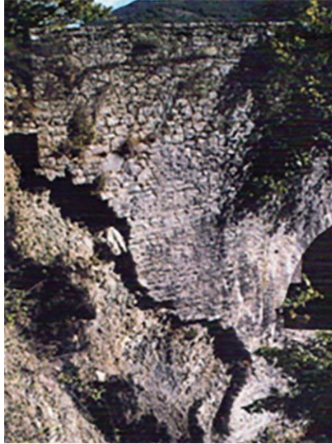
Εικόνα 13: Αποδιοργάνωση του κάτω τμήματος του τυμπάνου
