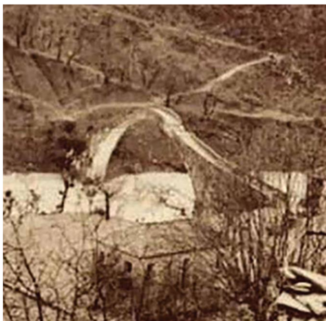
Εικόνα 10: Βλάβη της Γέφυρας από την έκρηξη
