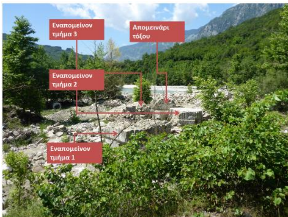
Εικόνα 24: Γενική άποψη του εργοταξίου που διαμορφώθηκε γύρω από τα εναπομειναντα τμήματα του Γεφυριού
