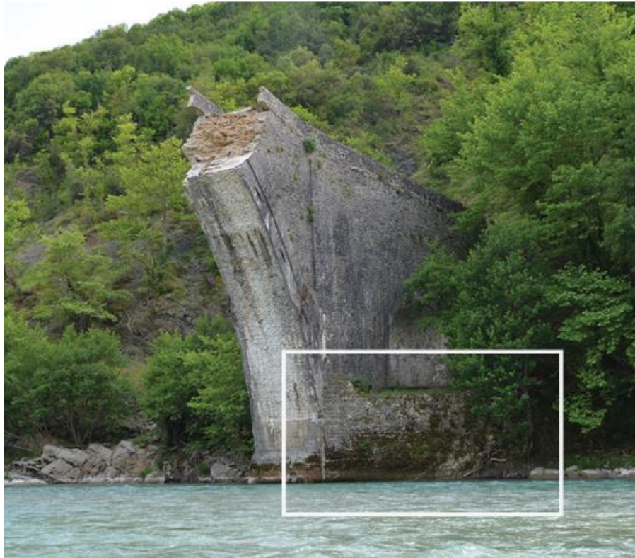
Εικόνα 18: Λίθινος τοίχος ανάντη του δυτικού μεσοβάθρου
