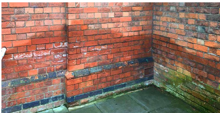
Εικόνα 23 : Παράδειγμα ανερχόμενης υγρασίας μέσω τριχοειδούς αναρρίχησης
