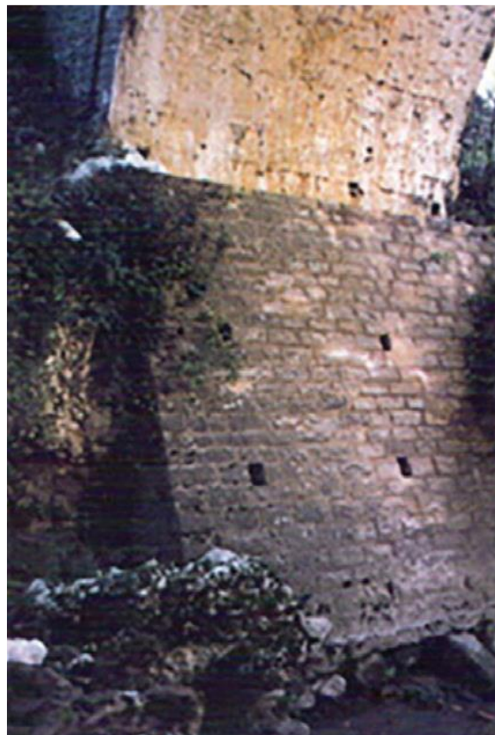
Εικόνα 17: Λίθινος τοίχος αντιστήριξης στη θέση του θεμελίου του ανατολικού βάθρου
