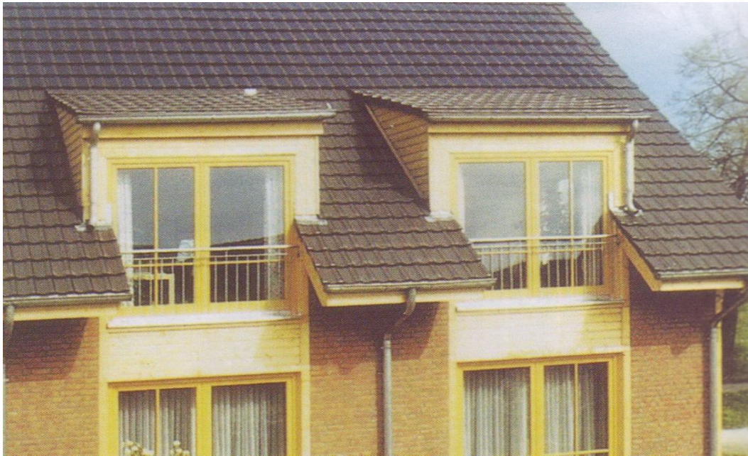
Εικ.9.19. Φωτοβολταϊκά κεραμίδια[11]
