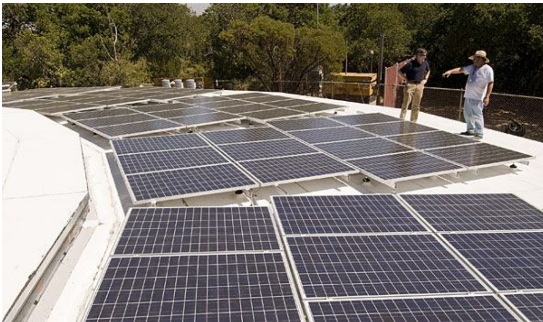
Εικ.9.18. Εγκατάσταση φωτοβολταϊκών συστημάτων σε επίπεδη οροφή[11]
