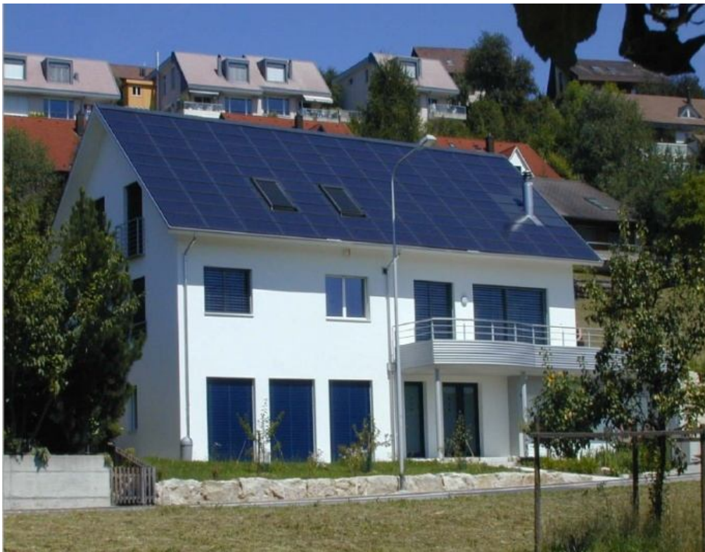
Εικ.9.17. Εγκατάσταση φωτοβολταϊκών συστημάτων σε επικλινή στέγη[11]
