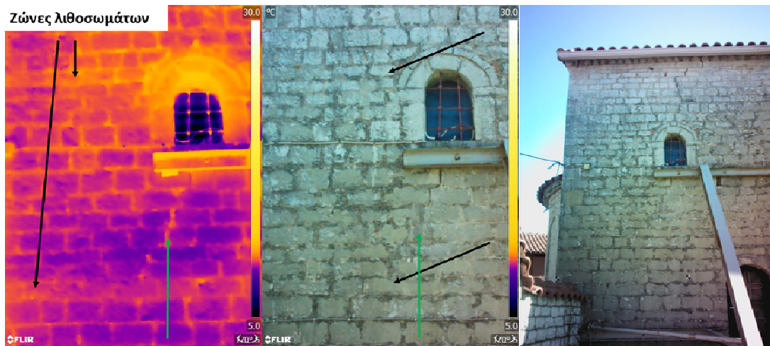
Εικόνα 52: Ζώνες λίθων στη Βόρεια όψη.
