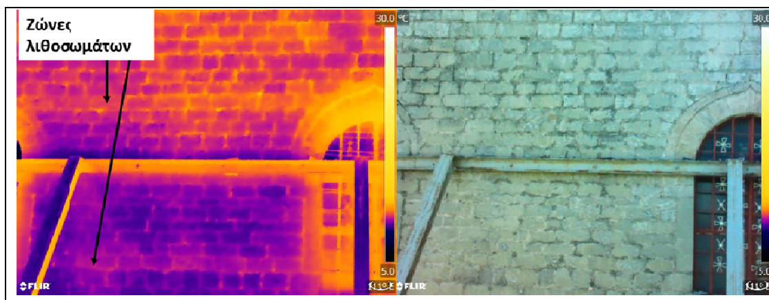
Εικόνα 54: Ζώνες λίθων στη Βόρεια όψη.
