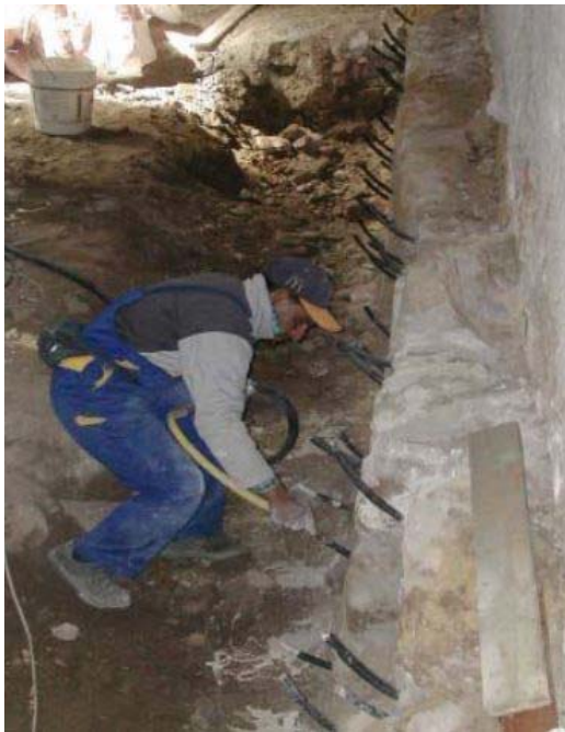
Εικόνα 113: Ενίσχυση τοιχοποιιών και θεμελιώσεων
