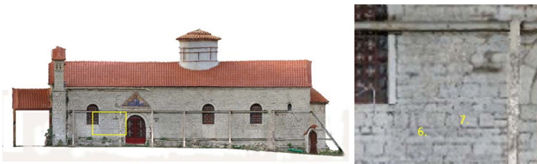
Εικόνα 48: Θέσεις εφαρμογής κρουσιμέτρου. Νότια όψη.
