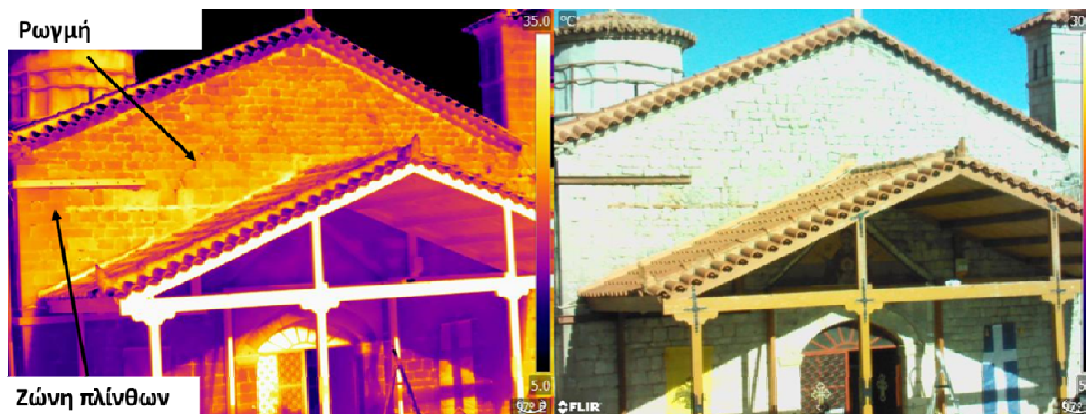
Εικόνα 50: Ζώνη πλίνθων και ρωγμή στη Δυτική όψη.
