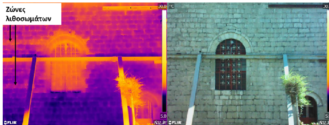
Εικόνα 53: Ζώνες λιθοσωμάτων στη Βόρεια όψη.
