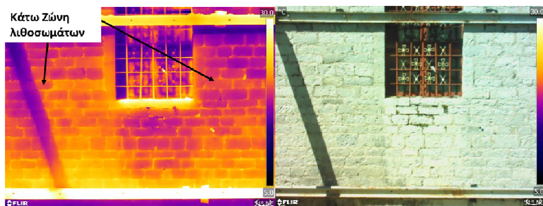
Εικόνα 62: Θερμογράφημα στην Νότια όψη. Κάτω ζώνη λιθοσωμάτων.
