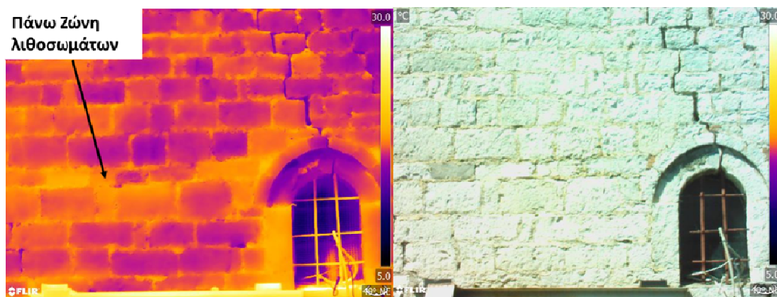
Εικόνα 67: Θερμογράφημα στην Νότια όψη.
