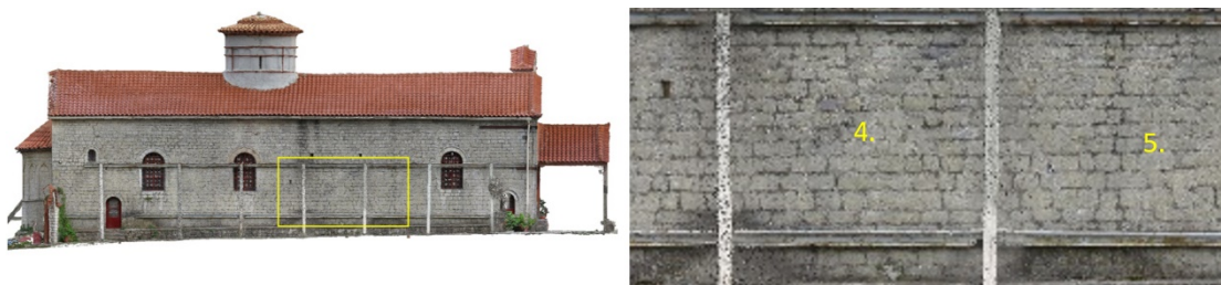
Εικόνα 47: Θέσεις εφαρμογής κρουσιμέτρου. Βόρεια όψη.
