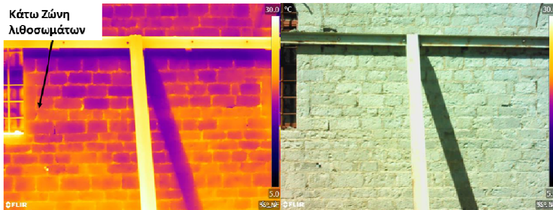
Εικόνα 63: Θερμογράφημα στην Νότια όψη. Κάτω ζώνη λιθοσωμάτων.
