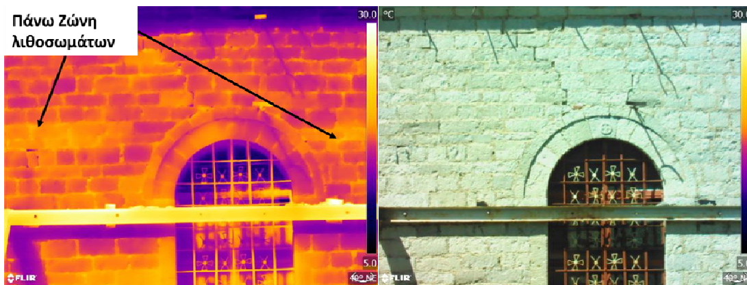
Εικόνα 64: Θερμογράφημα στην Νότια όψη. Πάνω ζώνη λιθοσωμάτων.
