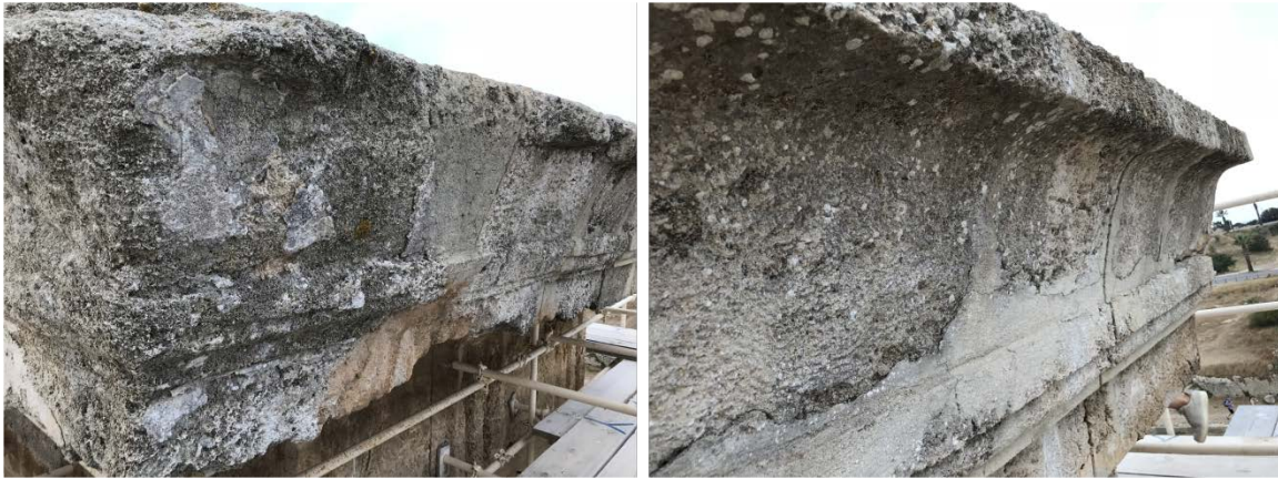
Εικόνα 45: Συμπληρώσεις αρχαίου λίθου με τσιμέντο στον θριγκό, βόρεια όψη
