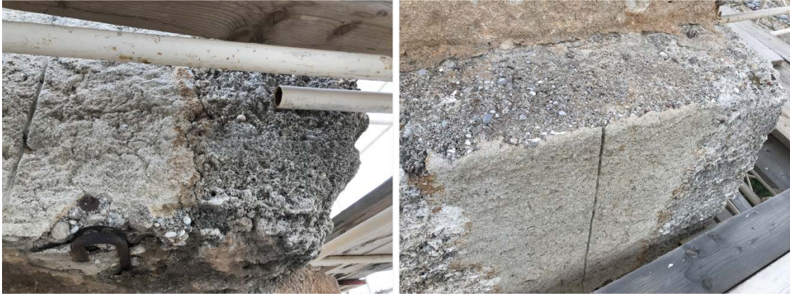
Εικόνα 42: Συναρμογή τμημάτων αρχαίου λίθου με σπλισμένο σκυρόδεμα στον θριγικό
