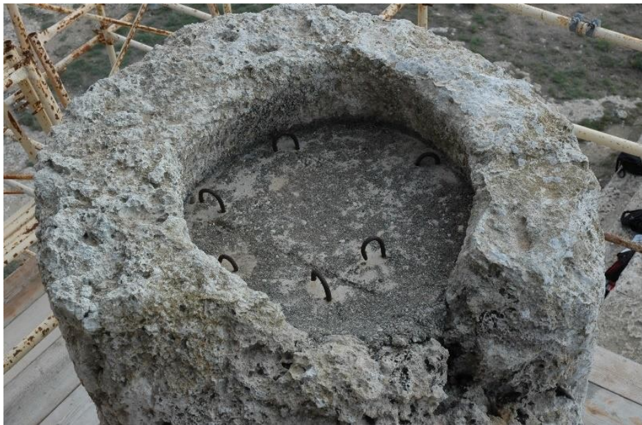
Εικόνα 5: Διαμόρφωση πυρήνα από οπλισμένο σκυρόδεμα στον κίονα κατά την ιταλική αναστήλωση
