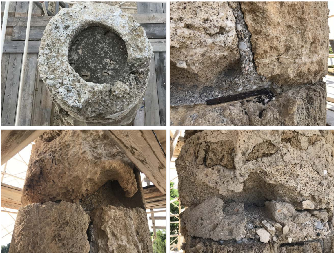
Εικόνα 41: Πυρήνας από οπλισμένο σκυρόδεμα, διαβρωμένος μεταλλικός σύνδεσμος και σπηλαιώσεις στους λίθους της Ιταλικής αποκατάστασης και τους αρχαίους λίθους
