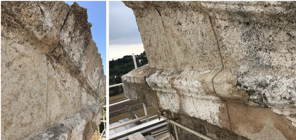
Εικόνα 44: Συμπληρώσεις αρχαίου λίθου με τσιμέντο στον θριγικό, ανατολική όψη
