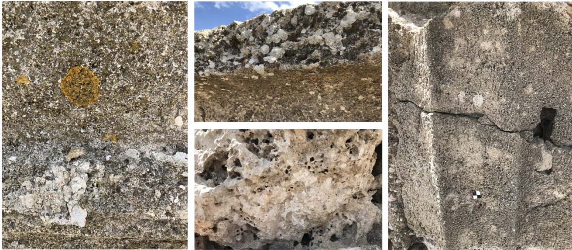
Εικόνα 46: Βρύα, κρουστώδεις επιλιθικές λειχήνες και μαύρη βιοδιάβρωση στο αρχαίο δομικό υλικό
