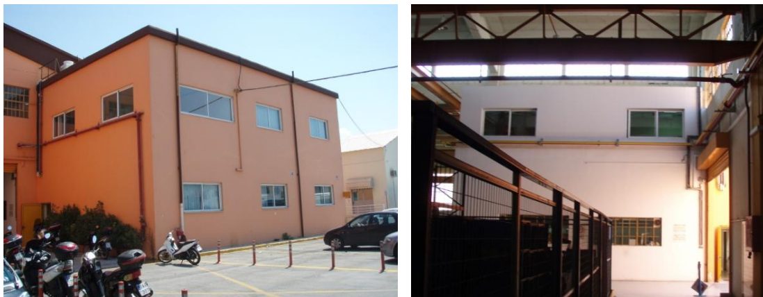
Εικόνα 9.1: Εξωτερική και εσωτερική άποψη των γραφείων διοίκησης
