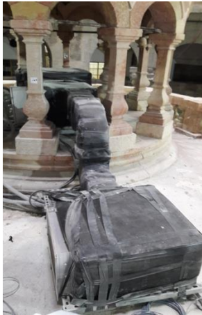
Εικόνα 1.8: Ολοκλήρωση τοποθέτησης συστήματος εξαερισμού και αφύγρανσης
