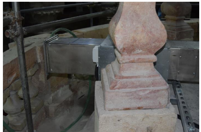
Εικόνα 1.7: Plenum – Διάταξη εξαερισμού στην οπή του Ταφικού Θαλάμου
