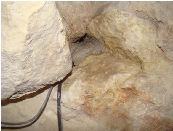
Εικόνα 4.12: Εντοιχισμένα ενσύρματα αισθητήρια DMS1 και ΤΜ1 στον Ιερό Βράχο
