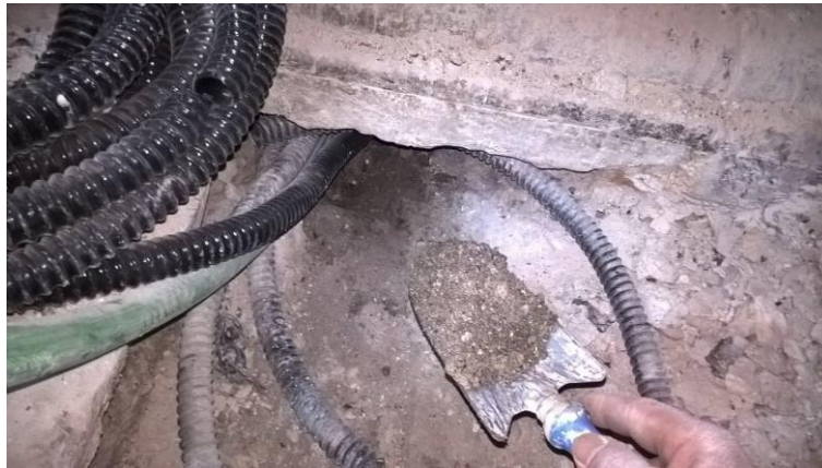
Εικόνα 3.8: Ύπαρξη υγρασίας στην βάση της νότιας τοιχοποιίας
