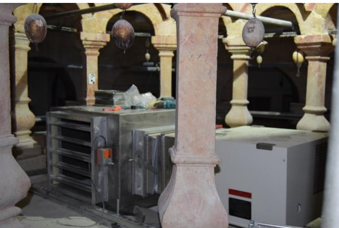
Εικόνα 1.7: Plenum – Διάταξη εξαερισμού στην οπή του Ταφικού Θαλάμου
