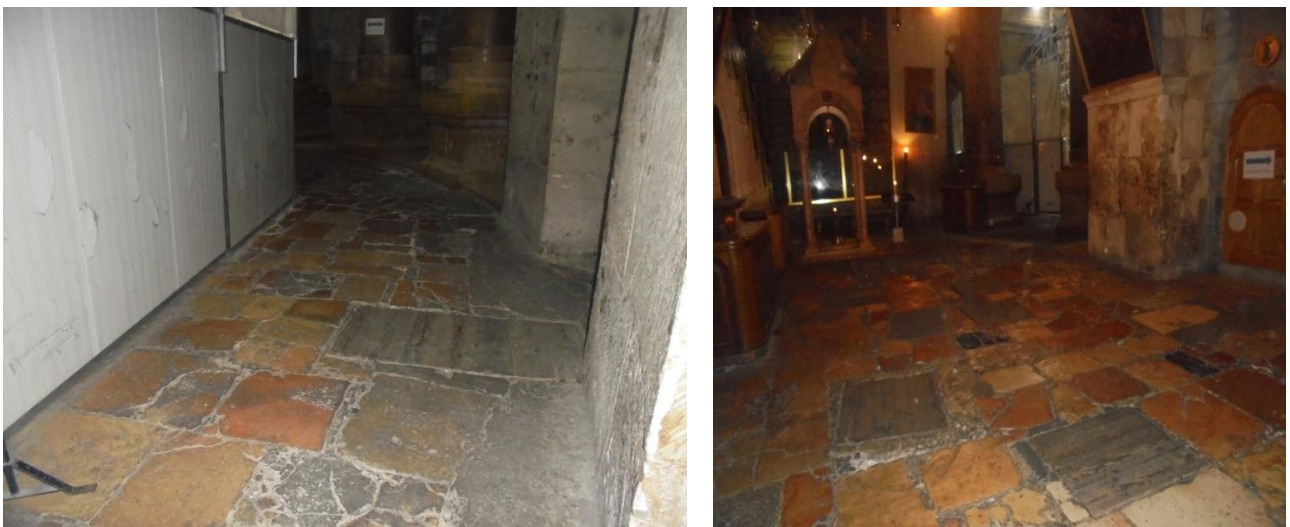
Εικόνα 3.5: Φρεάτια λυμάτων-όμβριων στο χώρο της Ροτόντας
