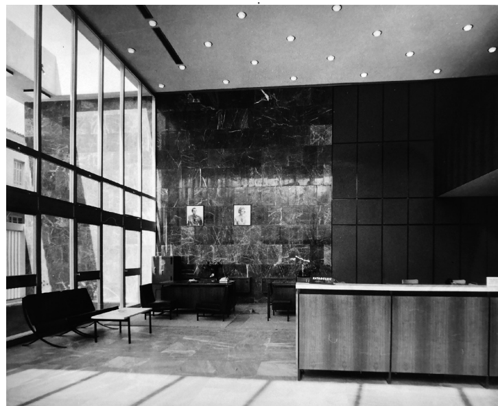
52β. Εμφανείς οι δουλεμένες συναρμογές μαρμάρου/υαλοστασίου/
