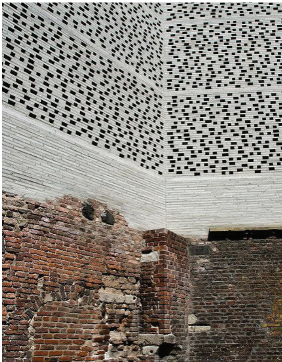
Εικ.32: Λεπτομέρεια συναρμογής παλαιού και νέου τούβλινου τοίχου
