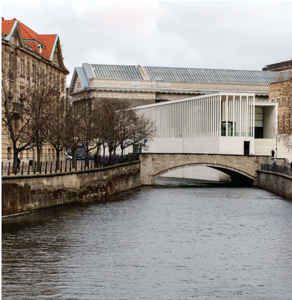
Εικ.1: Άποψη της James-Simon-Galerie από τον ποταμό Kupfergraben
