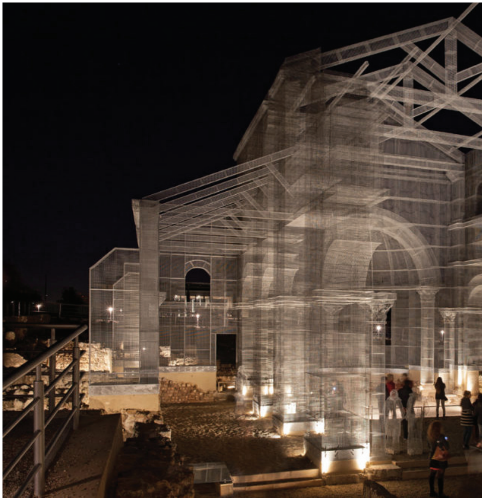
Εικ.44: Άποψη της μόνιμης εγκατάστασης της Βασιλικής του Siponto
