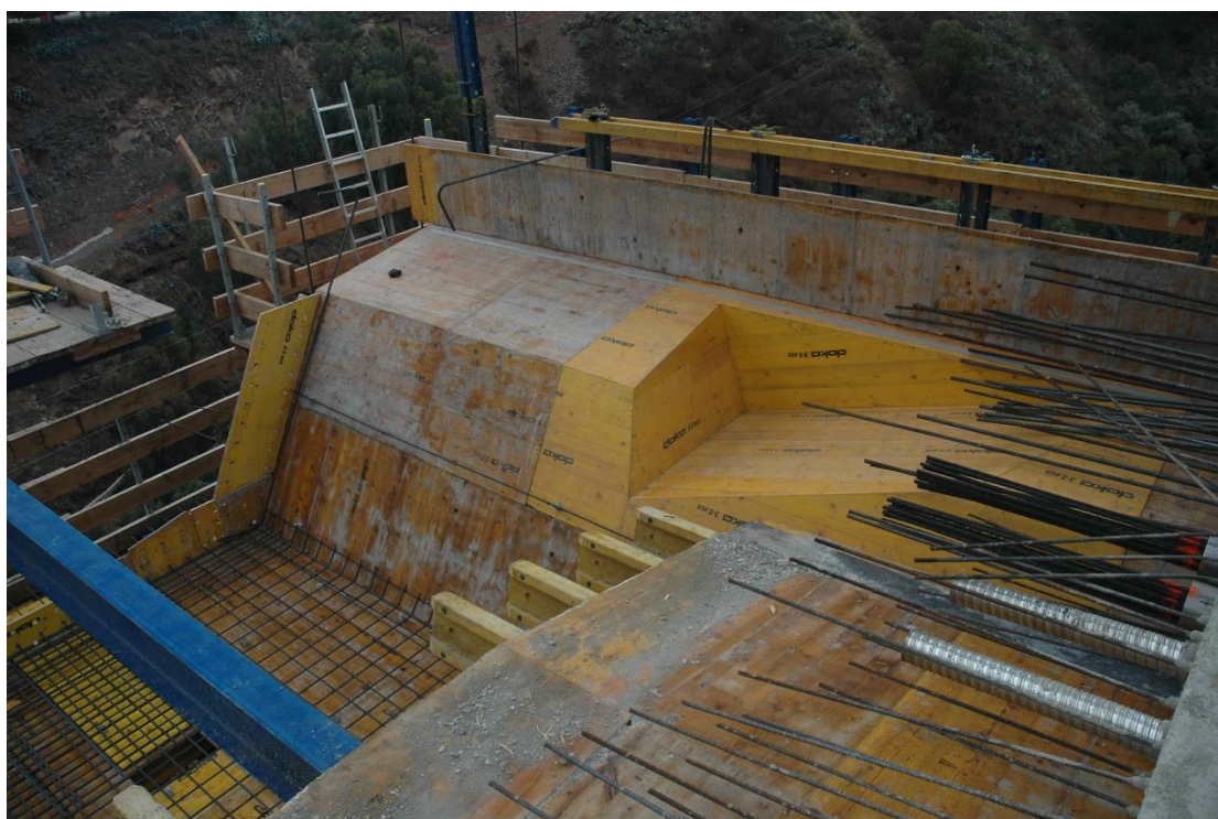
Εικόνα 28 Φορείο σκυροδέτησης σπονδύλων
