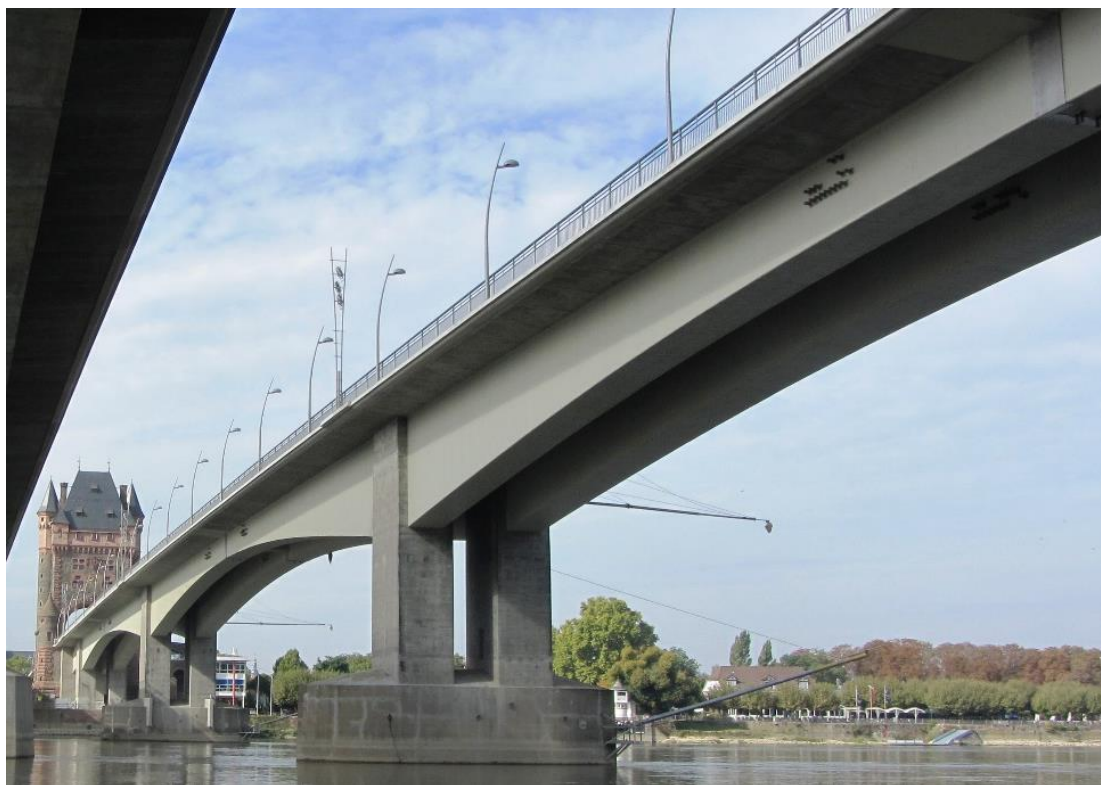
Εικόνα 8 Γέφυρα Nibelungen (1953), Γερμανία
