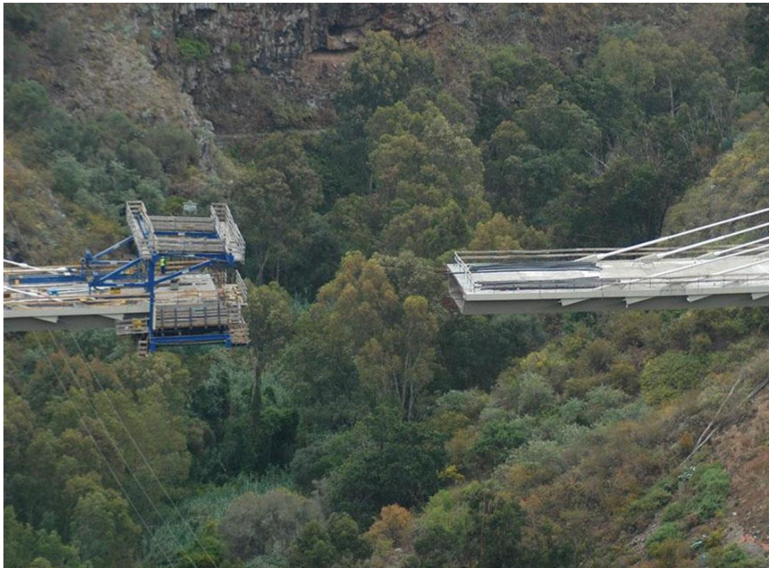
Εικόνα 36 Πριν την αποκατάσταση της συνέχειας (2)
