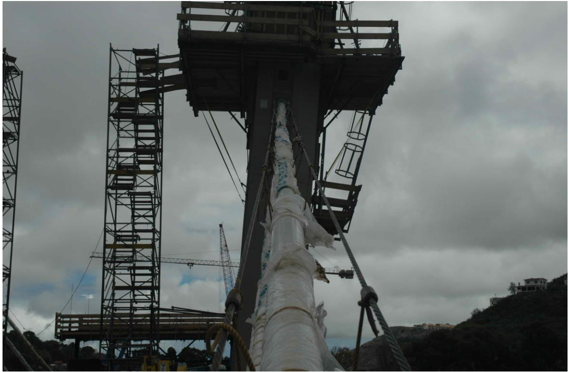
Εικόνα 33 Πυλώνας υπό κατασκευή
