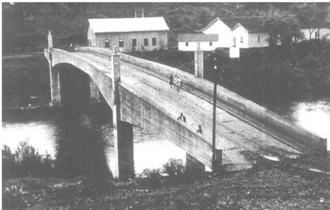
Εικόνα 5 Γέφυρα ποταμού Reixe (1933), Βραζιλία
