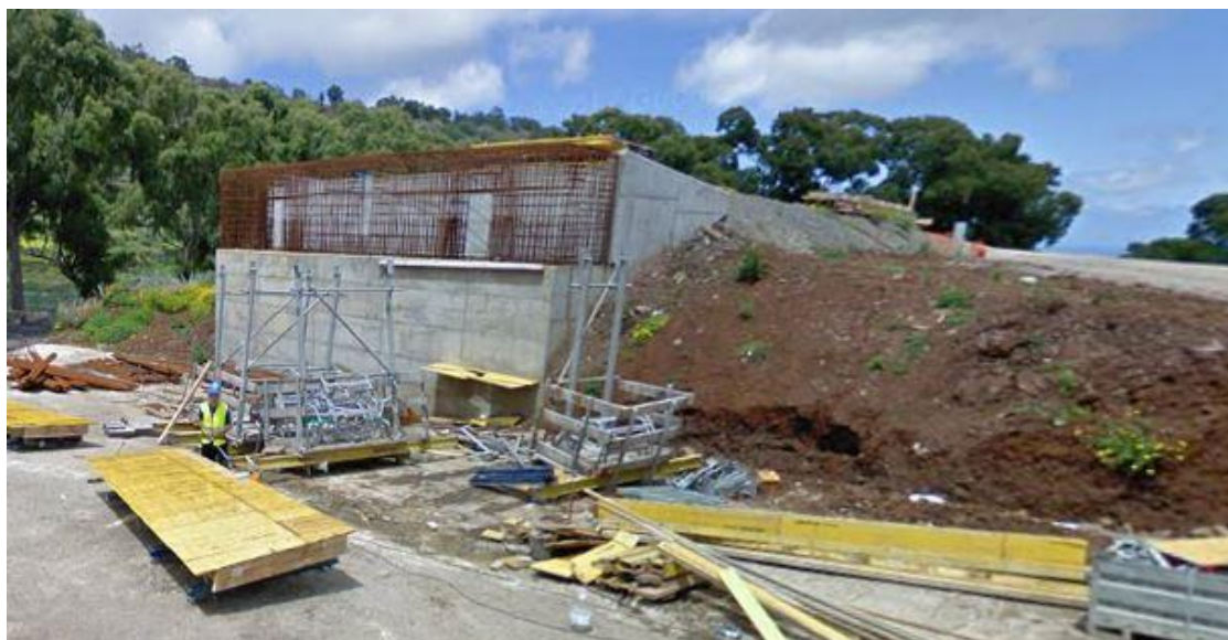
Εικόνα 27 Ακρόβαθρο E2 υπό κατασκευή
