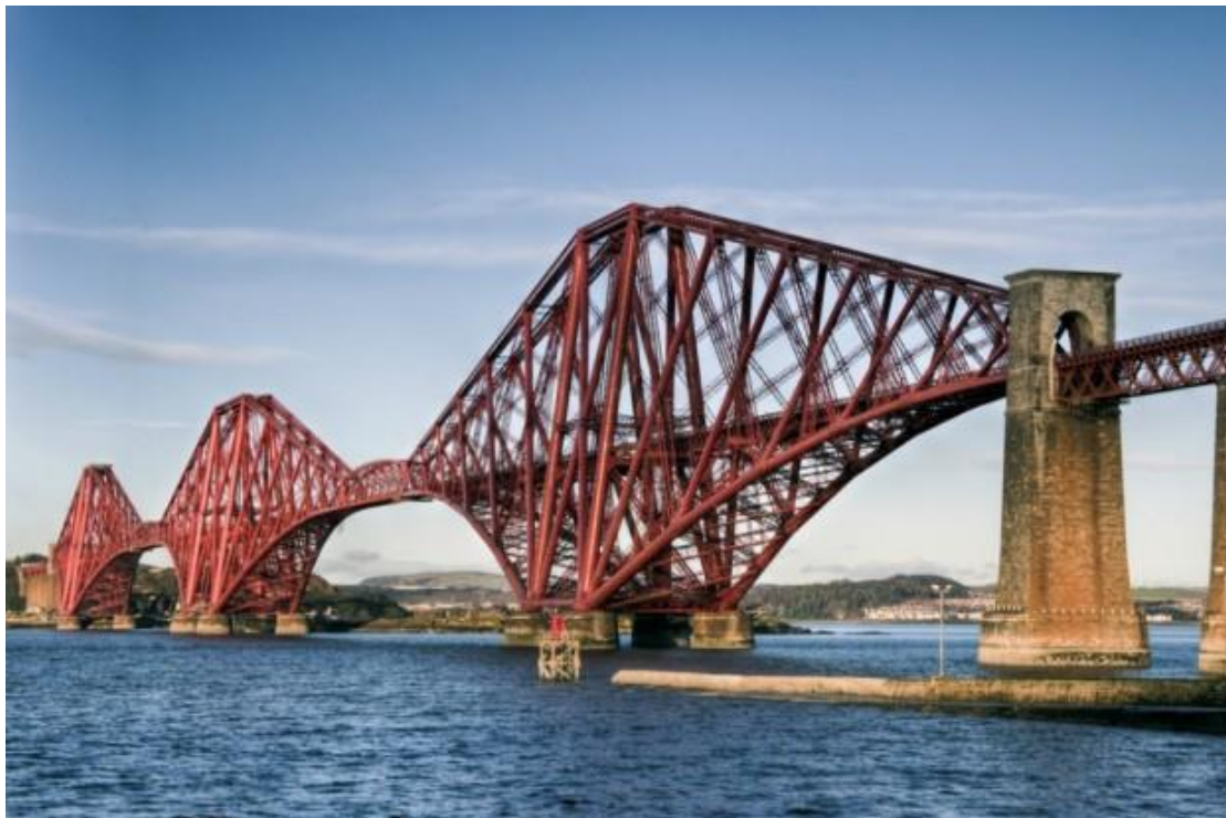
Εικόνα 2 Σιδηροδρομική γέφυρα Forth (1890), Σκωτία
