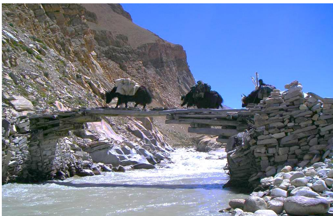
Εικόνα 1 Προβολοδόμηση με κορμούς στο Θιβέτ
