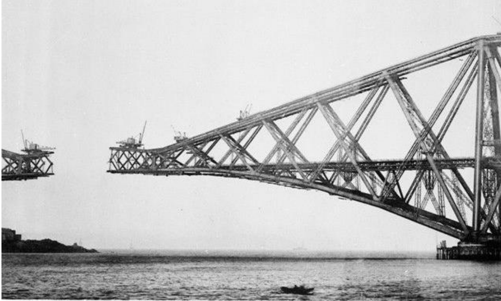
Εικόνα 3 Η γέφυρα Forth λίγο πριν την αποκατάσταση της συνέχειας
