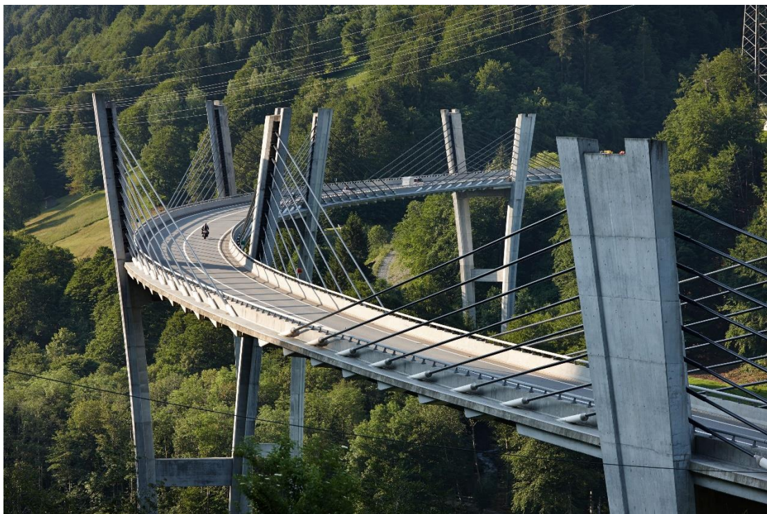
Εικόνα 22 Γέφυρα Sunniberg στην Ελβετία
