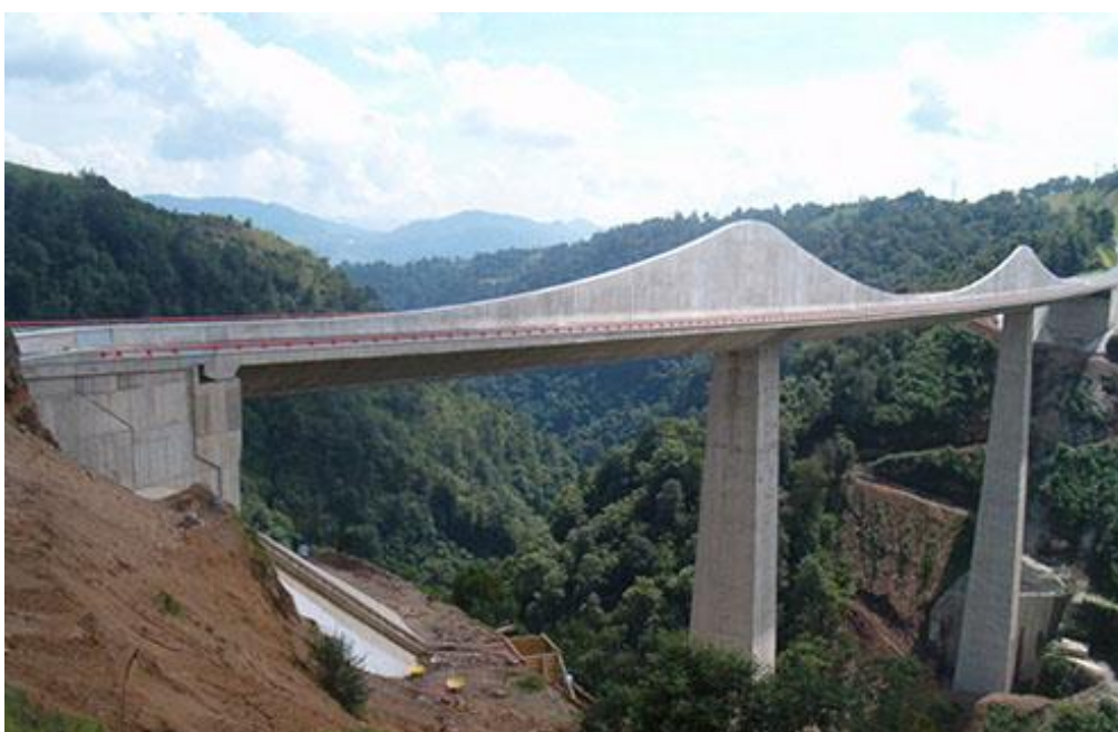
Εικόνα 11 Γέφυρα Barton Creek (1991), Τέξας
