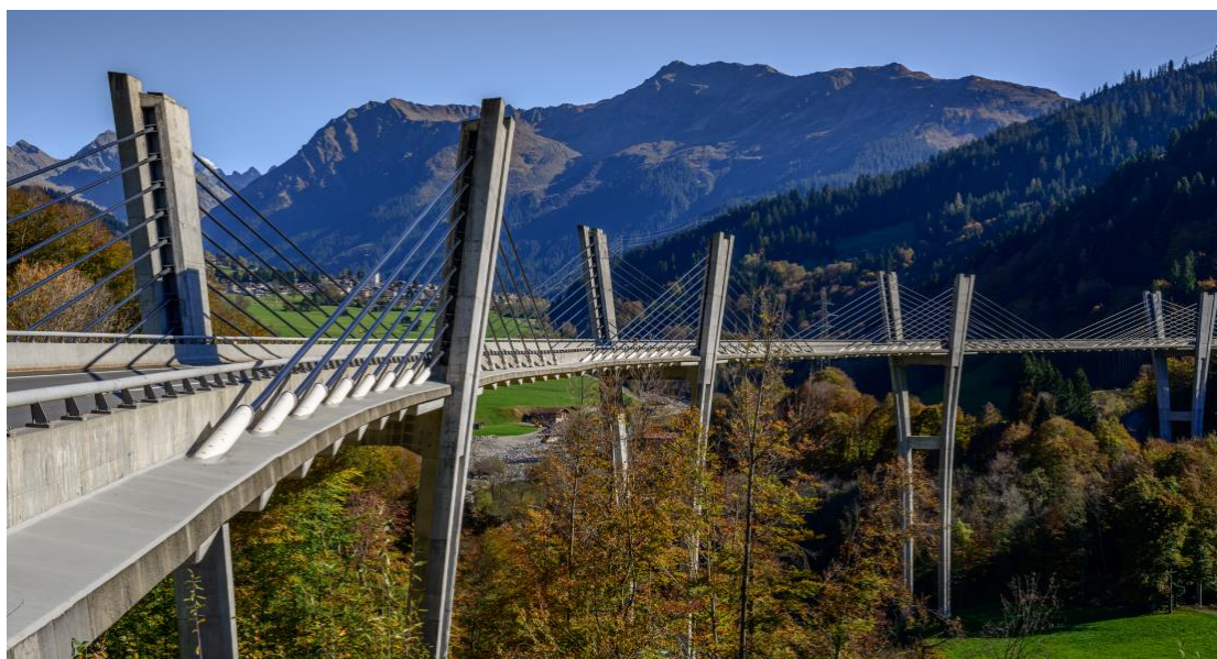
Εικόνα 16 Γέφυρα Sunniberg (1998), Ελβετία
