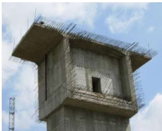
Εικόνα 21 Διαδοκίδα με ανθρωποθυρίδα διελεύσεως
