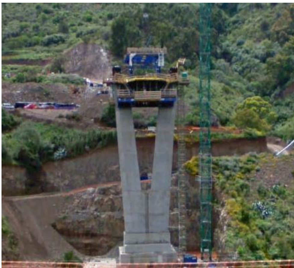
Εικόνα 29 Κατασκευή βάθρου P1
