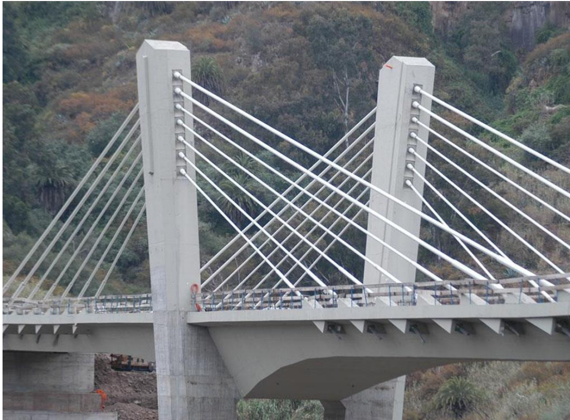
Εικόνα 39 Πυλώνες και εξωράχιοι τένοντες
