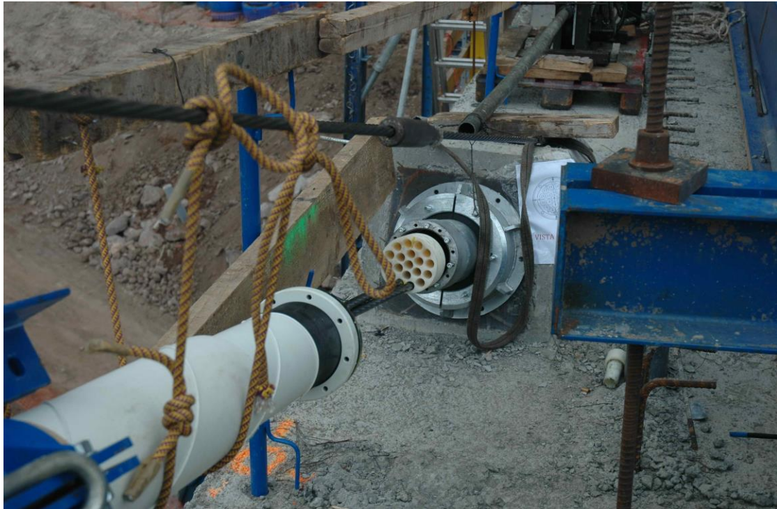
Εικόνα 31 Διάταξη αγκύρωσης εξ. τένοντα πάνω από το φτερό της διατομής
