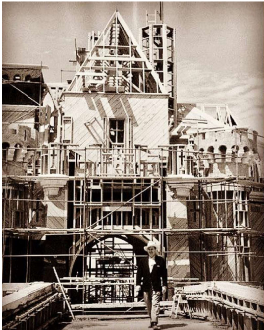
8. Ο Walt Disney επιβλέπει την κατασκευή της Disneyland, California, Μάιος 1955
