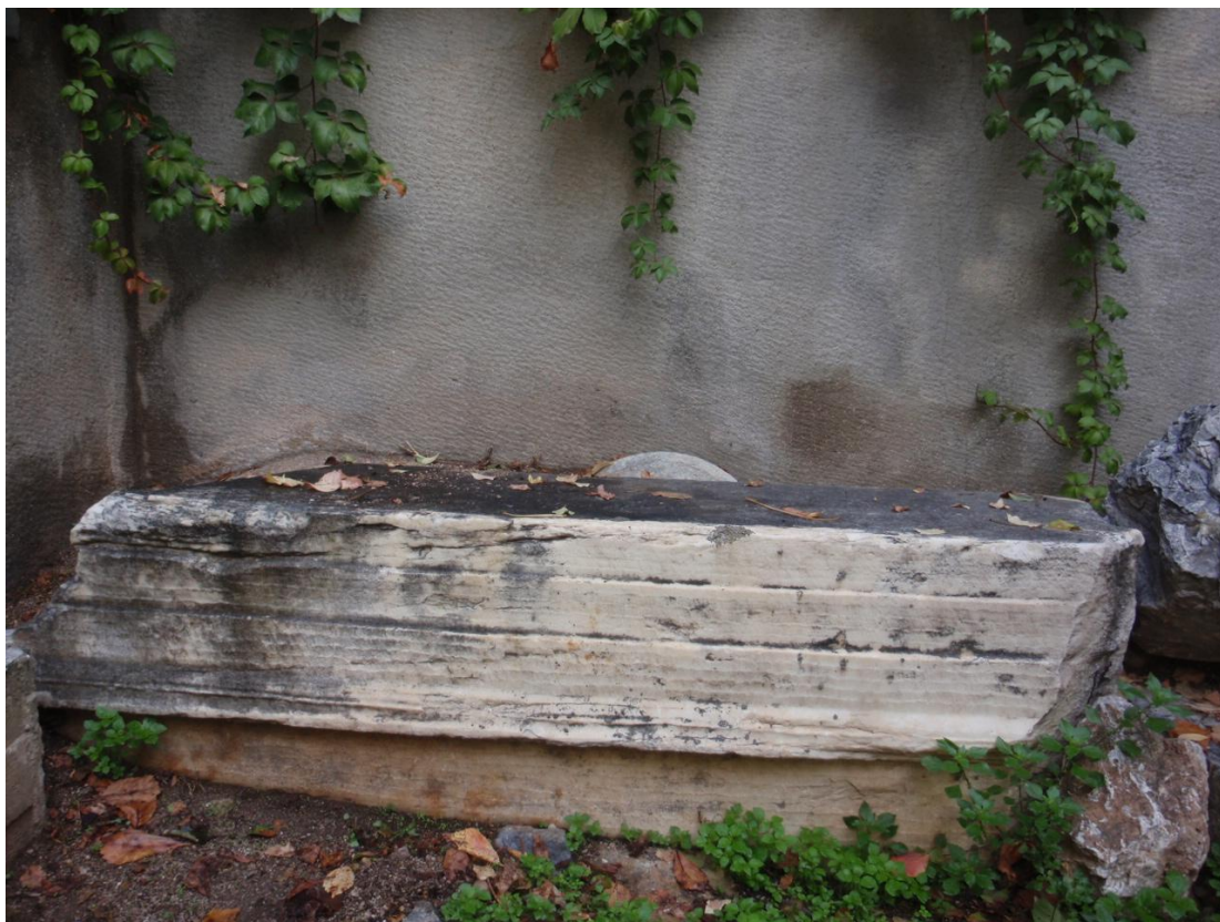
Εικ. 34. Τόρμος για την εμβολή συνδέσμου σχήματος Π στην κάτω επιφάνεια του επιστυλίου.
