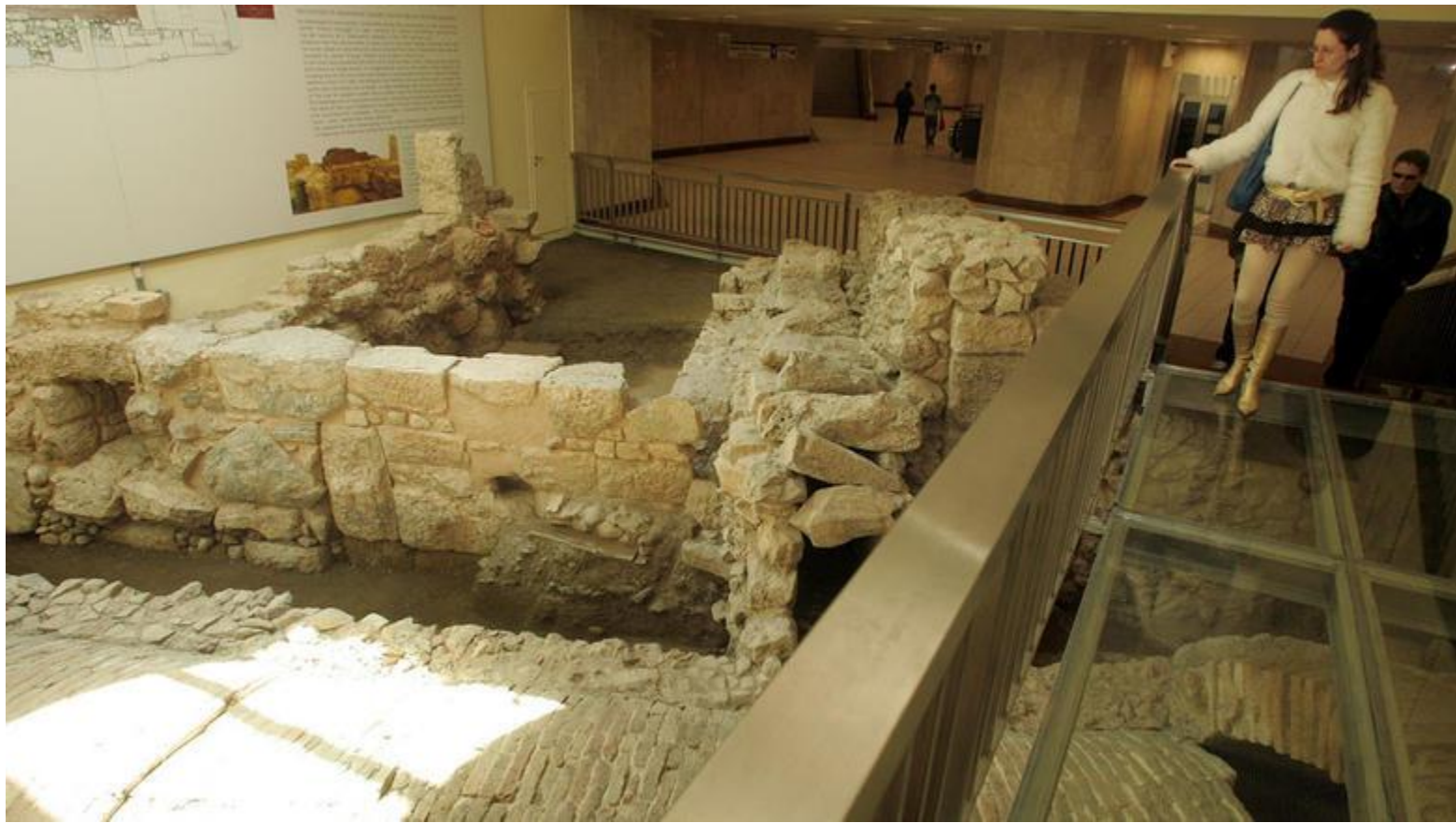
Εικ. 40. Πλατφόρμα από plexiglass και σίδηρο στον αρχαιολογικό χώρο του σταθμού ΗΣΑΠ Μοναστηρακίου.
