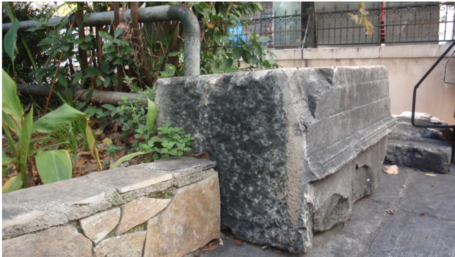
Εικ. 35. Αρμός ώσεως με αναθύρωση.
