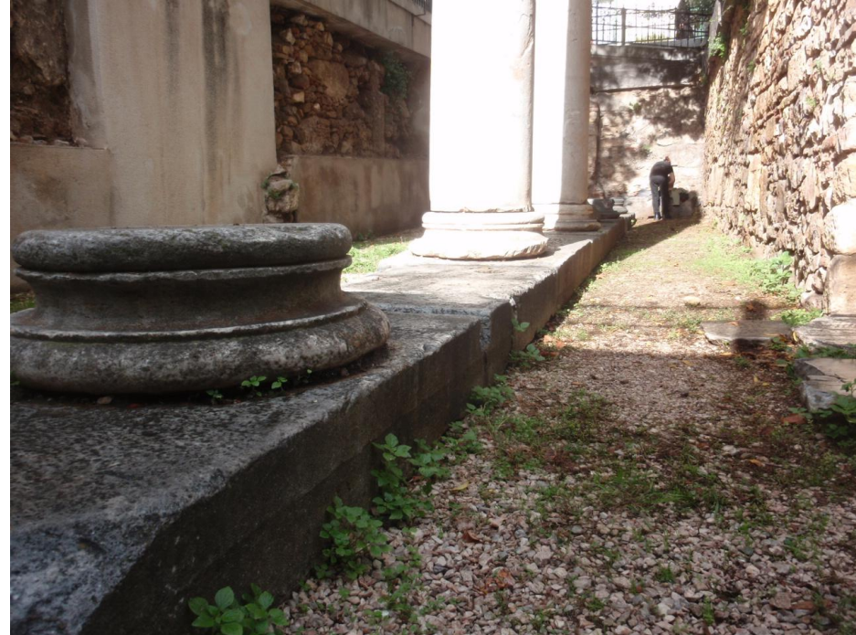
Εικ. 11. Η εσωτερική πλευρά του περιστυλίου.
