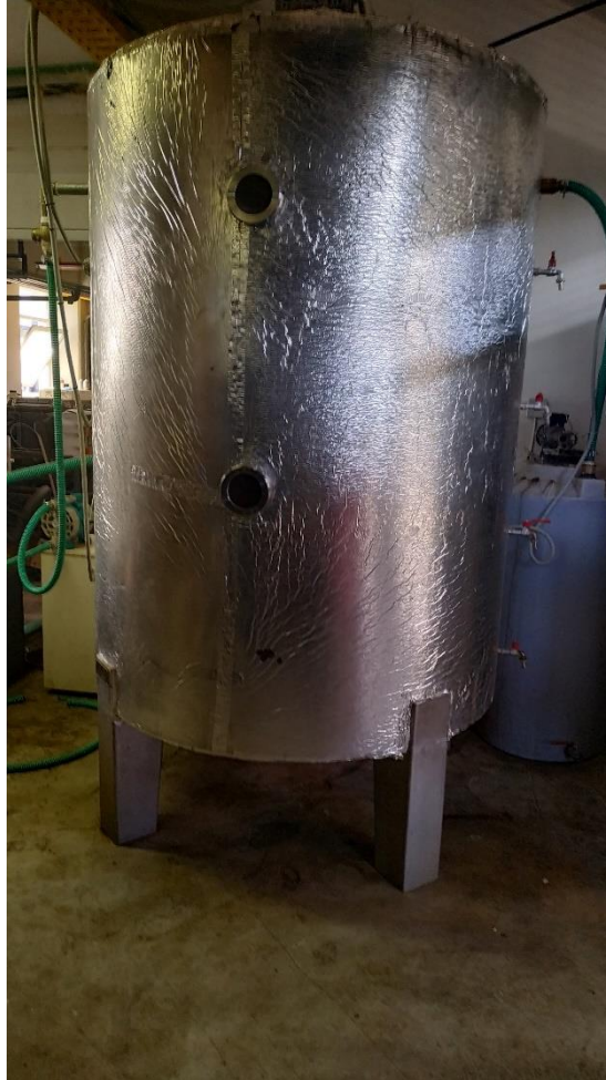
Εικόνα 5. Αναερόβιος χωνευτήρας CSTR 4m 3 από τον οποίο χρησιμοποιούταν το υπόλειμμα.
