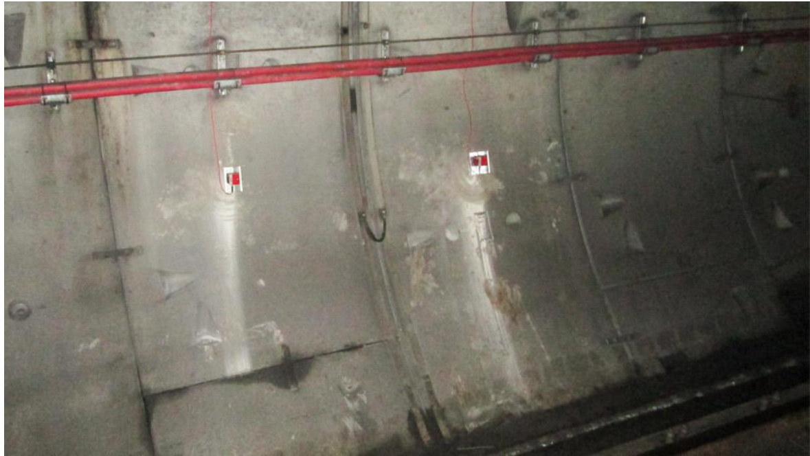
Εικόνα 2.3: Κλινόμετρα στερεωμένα σε πλάκες σε παρειά σήραγγας (πηγή: geotechpedia.com)
