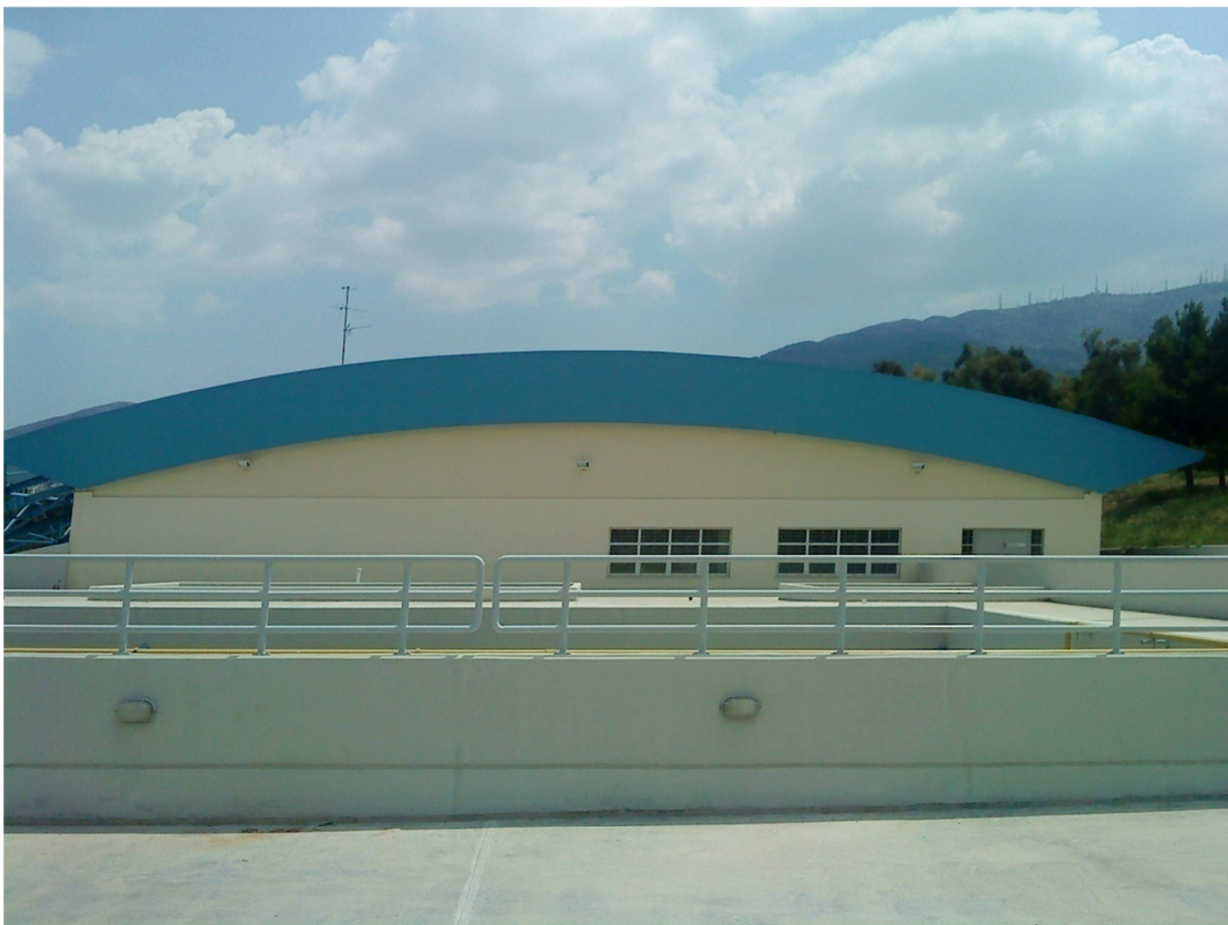
Εικόνα 5.1.β. : δυτική όψη του κλειστού γυμναστηρίου
