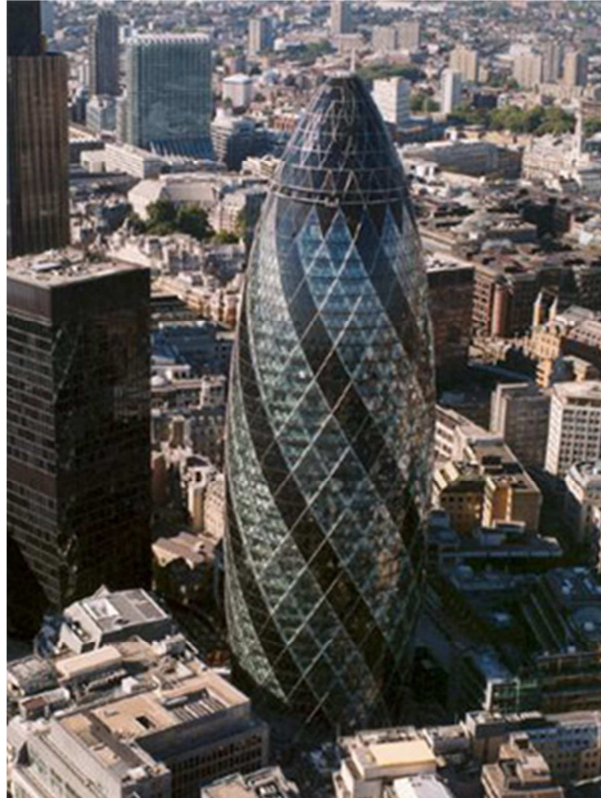
Εικόνα 4.1.1. πύργος Swiss Re του Λονδίνου. Κατέδειξε ότι με ευρηματικές λύσεις του τύπου διπλής λειτουργίας συστήματος γυάλινου θόλου και ανεστραμμένου κώνου κατόπτρων, τα κτίρια μπορούν να αερίζονται και να κλιματίζονται φυσικά.
