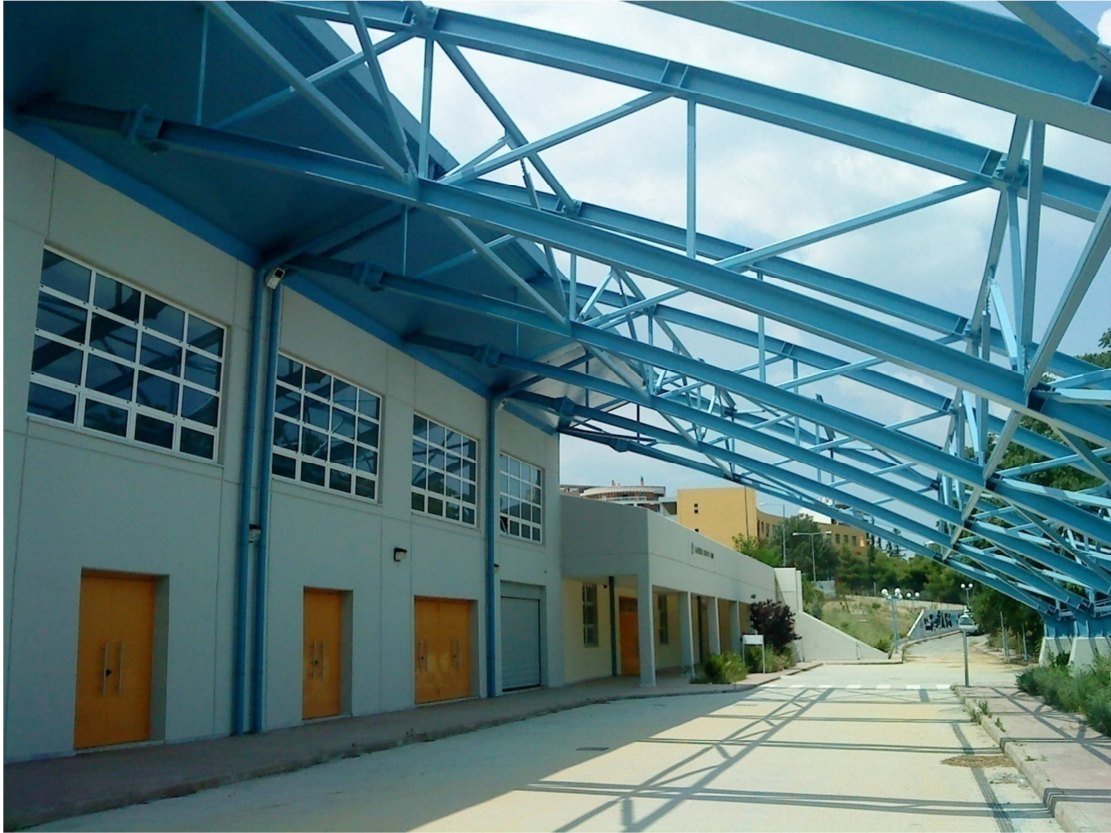
Εικόνα 8.1.γ. : παράθυρα δίχως ηλιοπροστασία στη βόρεια όψη και τυπικές πόρτες του κλειστού γυμναστηρίου
