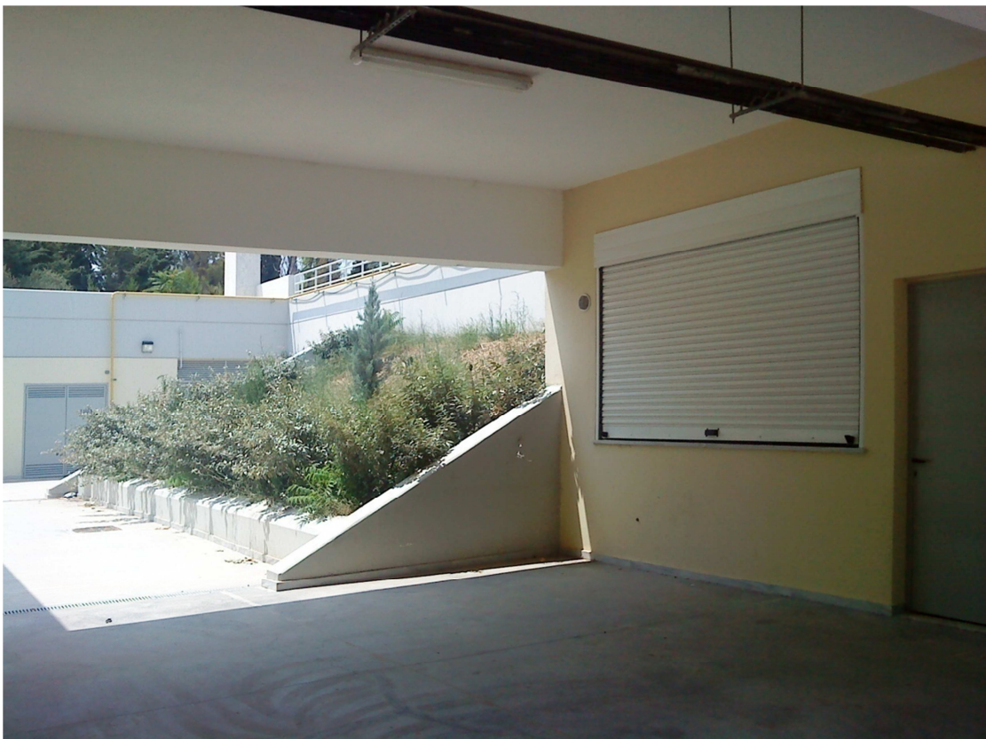
Εικόνα 8.1.β. : παράθυρο κυλικείου με ρολό ηλιοπροστασίας
