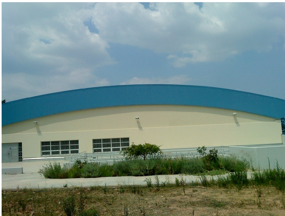
Εικόνα 5.1.γ. : ανατολική όψη του κλειστού γυμναστηρίου
