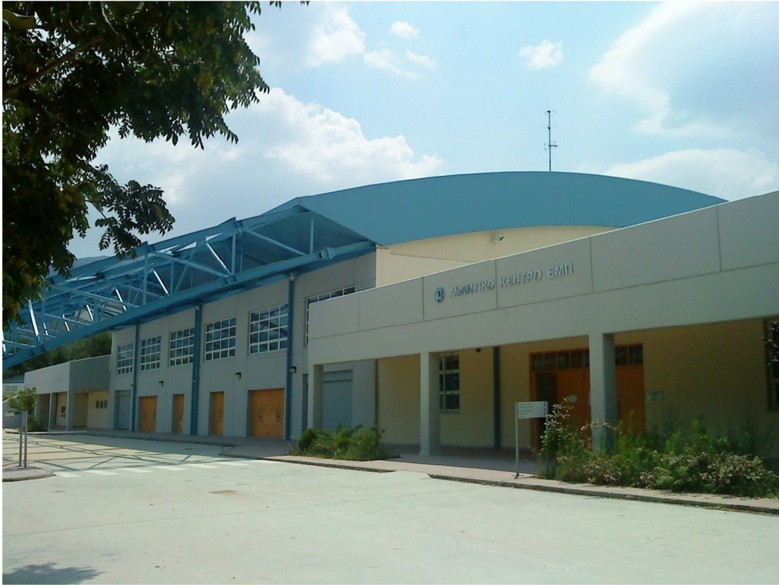
Εικόνα 5.1.α.: βόρεια όψη του κλειστού γυμναστηρίου
