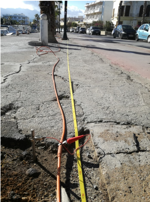
Εικόνα 67. Ηλεκτρόδια και προφίλ γεωηλεκτρικής τομογραφίας του λιμανιού.
