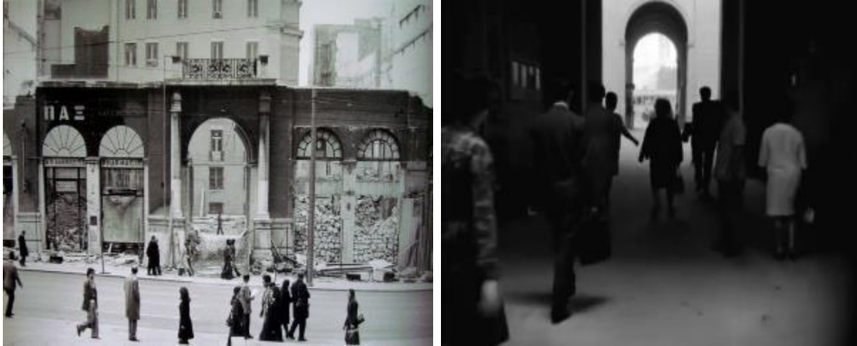
Εικόνα 5. Αριστερά: Χαλάσματα από την κατεδάφιση του Μεγάρου Πρωΐας από φωτογραφία του 1976. Στο κέντρο η είσοδος της στοάς. Δεξιά: Αθήνα 1968. Ο ηθοποιός Θόδωρος Κατσαδράμης, ερχόμενος από την οδό Σταδίου, κατευθύνεται προς την Στοά Πεσματζόγλου και την έξοδό της προς την Πανεπιστημίου. Εκτός από την καμέρα φαίνεται και η πίσω πλευρά του Μεγάρου Πρωΐας που «έβλεπε» στον ακάλυπτο χώρο. Πλάνο από την ταινία μικρού μήκους του Θόδωρου Αγγελόπουλου «Η ΕΚΠΟΜΠΗ».
