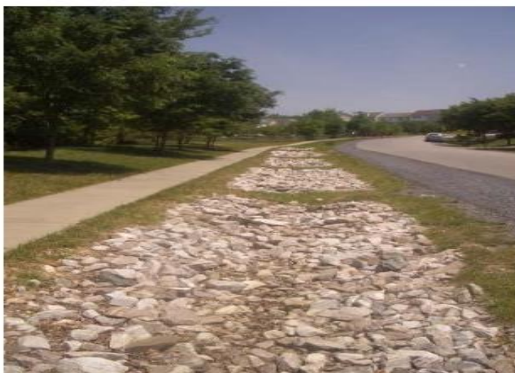
Εικόνα 6:5: Φράγμα διήθησης (Πηγή: http://nwrn.eu/measure/infiltration-trenches )
